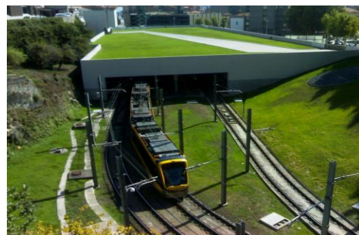
Figura 2.8 - Cobertura verde sobre a estação de metro da Trindade no Porto (Estação da trindade, 2014)
