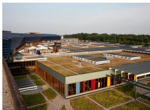
Figura 2.4 – Hospital em Deventer, Holanda, com coberturas vivas (Living Roofs, 2014)
