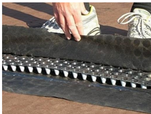
Figura 2.10 – Pormenor da camada de drenagem com pequenos depósitos (Green Roofs Blocks, 2014)
