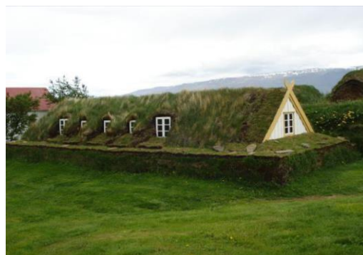
Figura 2.2 – Cobertura ajardinada, Islândia (Stater, 2008)
