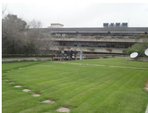
Figura 4.12 - Cobertura verde sobre a sala de ensaios
