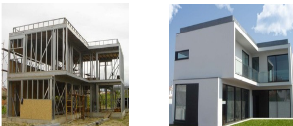
Figura 1.2 – Edifício construído segundo método Light Steel Framing (LSF).
