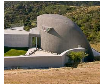
Figura 2.6 - Edifício residencial em painéis sanduíche moldados com lâminas em GFRP e núcleo de balsa [15].
