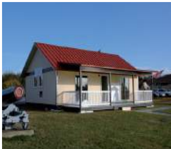
Figura 2.4 - Habitação em painéis sanduíche com lâminas em GFRP [13].
