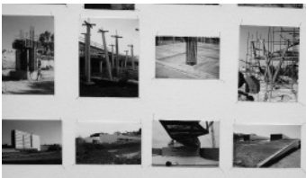
03.41 Pormenor do Atlas: fotografias de obra
