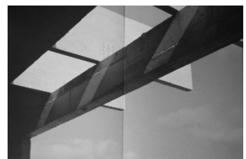
03.18 Pormenor de Brick is Red: fotografia de obra
