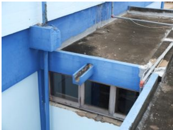
F.an. 14 - Revestimento de parede em falta; Anomalia média.
