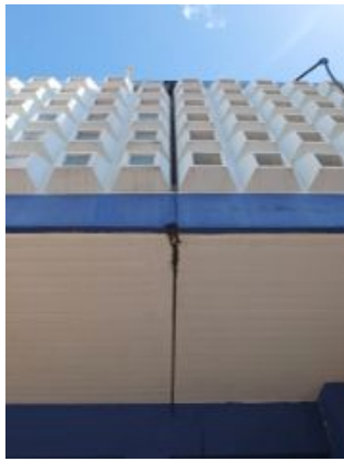
F.an.01 – Destacamento do betão e perda de material. Posteriores reparações com pouca qualidade, colonização biológica; Anomalia média.
