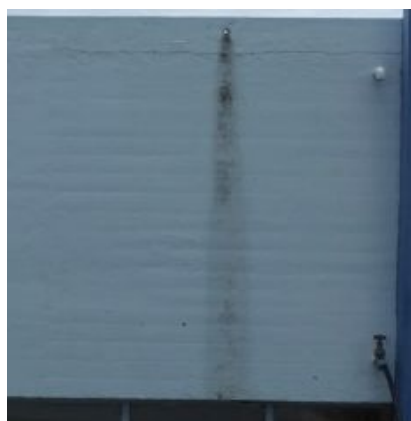
F.an.11 - Revestimento de protecção (reboco) de parede empolado e fissurado em área limitada; Anomalia média.
