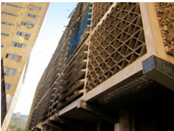
F.an.16 - Fendilhação em áreas limitadas das grelhas em betão armado; Anomalia média.
