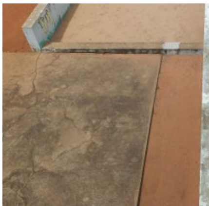
F.an.19 - Betonilha de acabamento do pavimento com fendilhação. Reparações que não preservaram o aspecto original; Anomalia ligeira.
