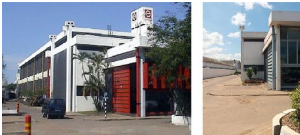
3.48 – Vista do edifício do Grupo Entrepósito segundo a configuração original. 3.49 – Vista do edifício do Grupo Entrepósito na actualidade. Distinguem-se a ausência da cor característica do Grupo Entrepósito e a remoção dos elementos de sombreamento, visível na segunda imagem.
