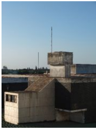
F.an.03 - Superfícies de revestimento das coberturas enegrecidas. Acumulação de detritos e sujeidade; Anomalia ligeira.
