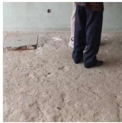
F.an. 15 – Revestimentos de piso com desgaste acentuado ou em falta em grandes áreas; Anomalia grave.
