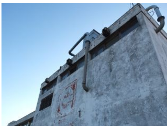
F.an.08 - Desagregação de elemento destacado em betão; Anomalia média.
