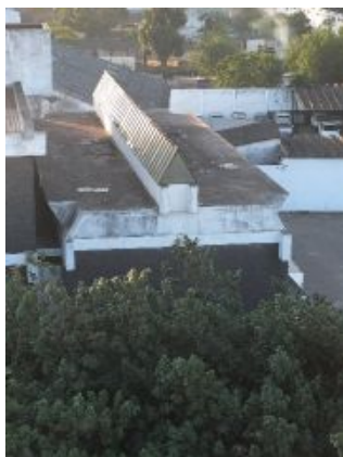
F.an.05 – Falta de elementos da claraboia em vidro; Anomalia média.
