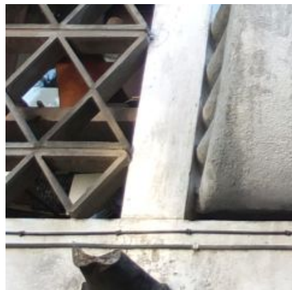
F.an.02 – Delaminação do revestimento das armaduras da viga. Exposição das armaduras muito localizada; Anomalia ligeira.
