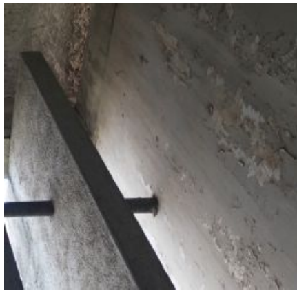
F.an.09 – Delaminação do revestimento das paredes; Anomalia ligeira.
