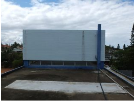
F.an.05 – Fissuração da pintura e reboco da platibanda; Anomalia ligeira.
