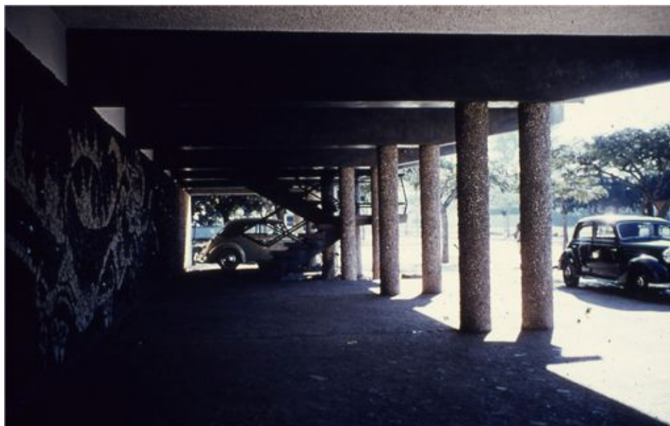
3.3 – Vista de uma das escadarias principais e de um lugar de estacionamento, ao fundo.
