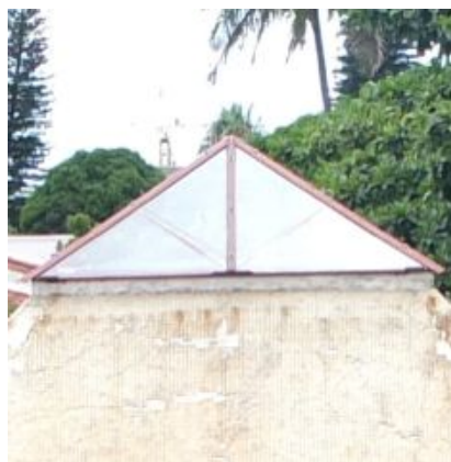
F.an.09 – Caixilharia com elementos oxidados, sujos e alteração de textura; Anomalia ligeira.
