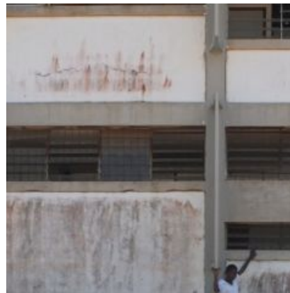
F.an. 14 – Revestimentos de paredes com manchas de sujidade ou alteração de cor; Anomalia média.
