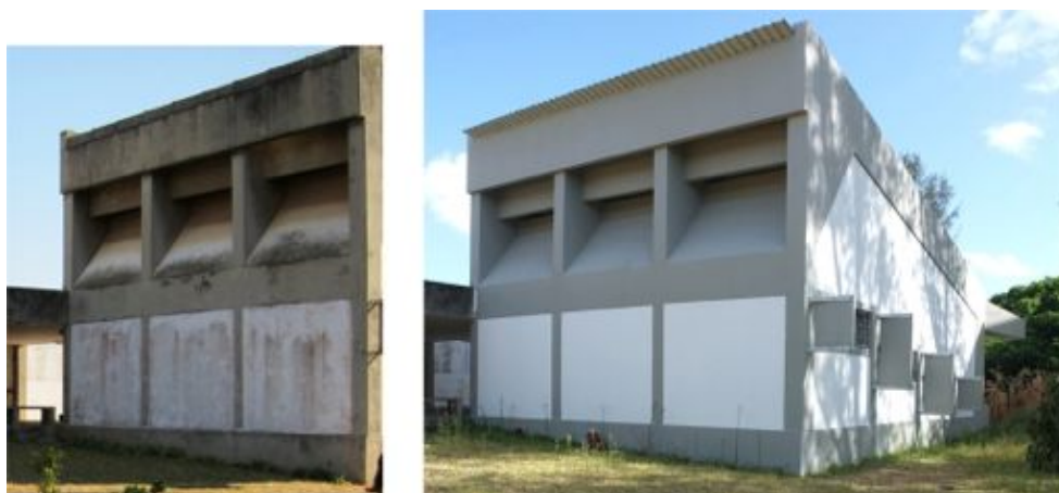
3.72 – Reabilitação das coberturas do auditório (bloco 4): vista de pormenor de remate.
