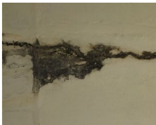
F.an. 05 - Fendilhação de grande extensão de pequena abertura que não indicia problemas estruturais. Sinais de corrosão; Anomalia média.
