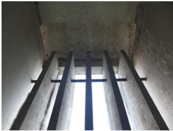
F.an.01 – Fendilhação e delaminação do revestimento das armaduras da viga. Possível colonização biológica; Anomalia média
