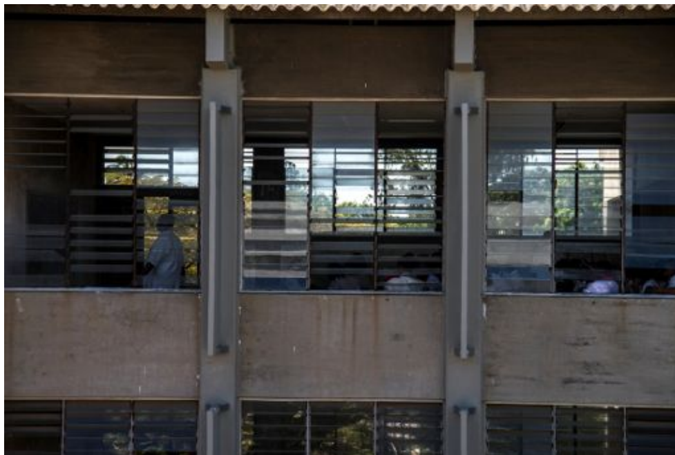
3.76 – Dispositivos de sombreamento em fachada exposta a Sul, no bloco das salas de aula.
