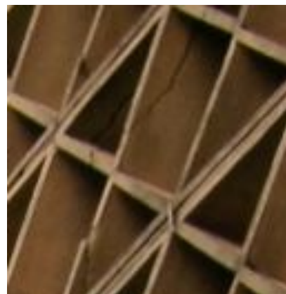
F.an.16 - Fendilhação em áreas limitadas das grelhas em betão armado; Anomalia média.
