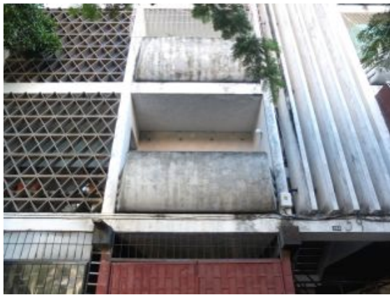
F.an.17 - Coloração do elementos quebra sol em betão armado; Anomalia ligeira.
