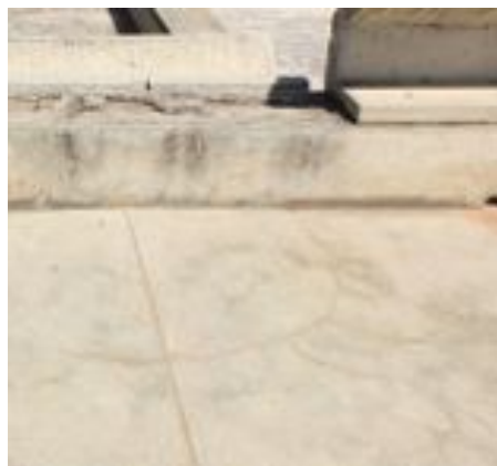
F.an.17 - Fendilhação generalizada de pequena abertura, tipo “craquelê”; Anomalia média.
