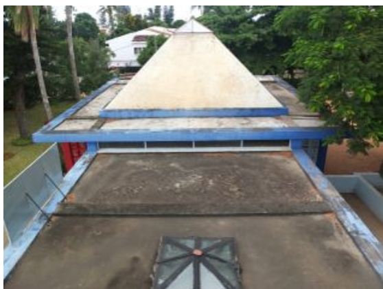
F.an.09 – Caixilharia com elementos oxidados, sujos e alteração de textura; Anomalia ligeira.
