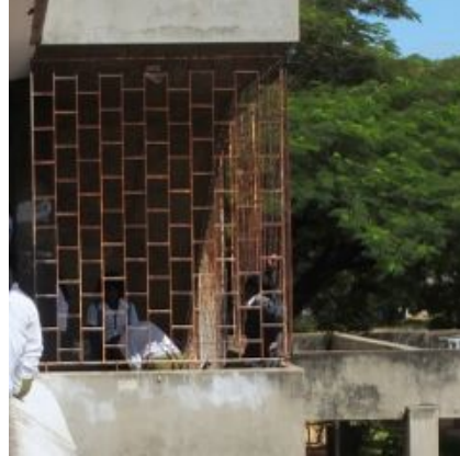
F.an.31 - Corrosão dos gradeamentos em ferro; Anomalia ligeira.
