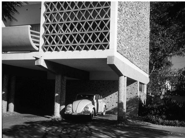
2.23 – Grelhas em betão armado, A importância do arejamento e sombreamento.
