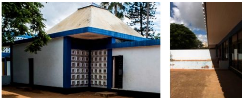
3.23 – Blocos de betão vazados em uso na capela. 3.24 – Sombreamento de vãos envidraçados.
