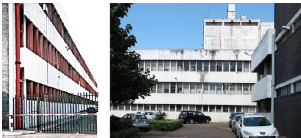
3.45 – Fachada Este-Sudeste (ESE) 3.46 – Fachada Oeste-Noroeste (ONO). A fachada ONO continha dispositivos brise-soleil , à semelhança da fachada ESE.
