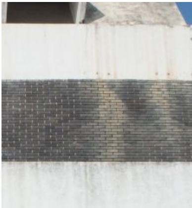
F.an.09 – Enegrecimento das paredes em betão armado; Anomalia ligeira.
