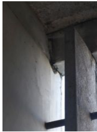
F.an.01 – Fendilhação e delaminação do revestimento das armaduras da viga. Possível colonização biológica; Anomalia média
