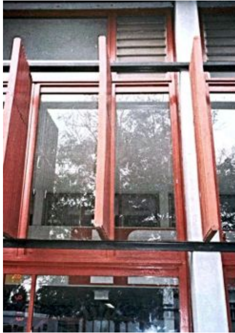
3.53 – Os brise-soleil em madeira assentes numa estrutura metálica (entretanto removidos).
