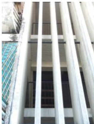
F.an.20 - Coloração das guardas em betão armado. Vestígios de humidade e colonização biológica; Anomalia ligeira.
