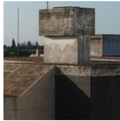
F.an.03 - Superfícies de revestimento das coberturas enegrecidas. Acumulação de detritos e sujeidade; Anomalia ligeira.
