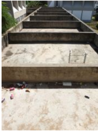
F.an.10 - Laje de cobertura com sujidade; Anomalia ligeira.
