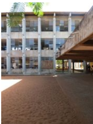
F.an. 20 – Caixilharia inexistente, substituída por painel de cartão; Anomalia grave.
