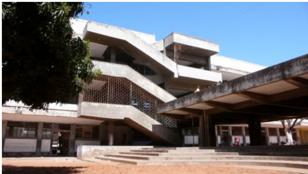
3.62 – Vista de bloco das salas de aula da Escola Secundária da Polana.
