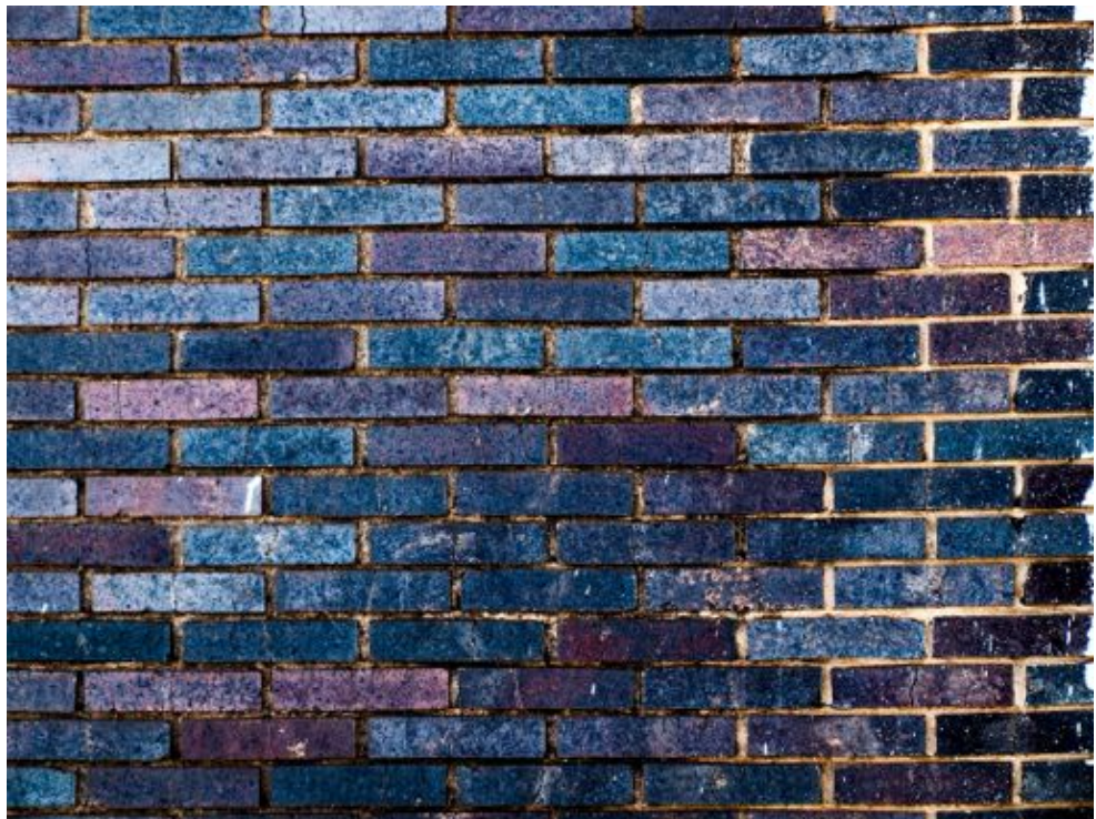
3.55 – O revestimento das paredes exteriores em tijolo de burro.
