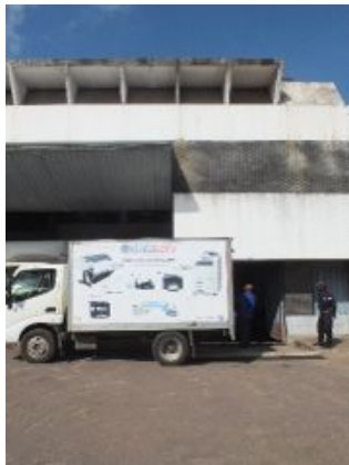
F.an.09 – Enegrecimento das paredes em betão armado; Anomalia ligeira.
