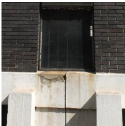
F.an.12 - Coloração do revestimento do elemento estrutural e depósito de sais no mesmo. Fendilhação; Anomalia média.
