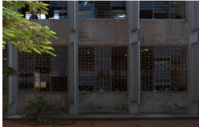
F.an.12 - Sinais de colonização biológica (junto ao solo) e coloração do betão por óxido de ferro; Anomalia ligeira.
