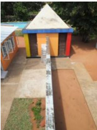
F.an.08 - Revestimento de cobertura inclinada com sujidades e alguns elementos deteriorados; Anomalia média.
