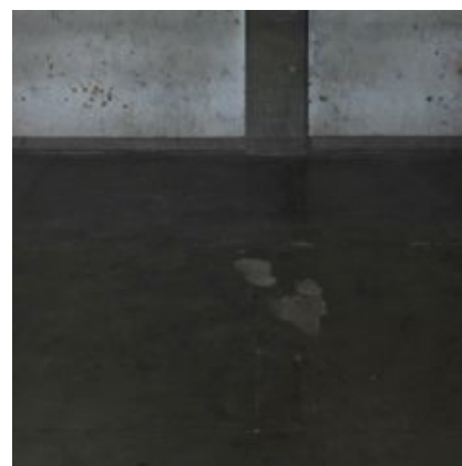
F.an. 16 – Revestimentos de piso em falta, em desagregação, em áreas limitadas; Anomalia ligeira.
