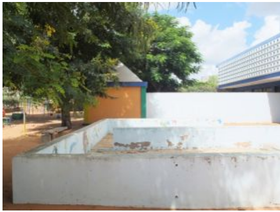
F.an.13 - Descasque da pintura dos muros exteriores; Anomalia ligeira.
