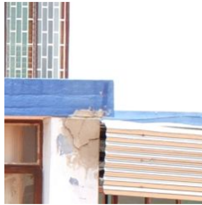
F.an.17 - Desagregação do revestimento (reboco) por esmagamento da parede; Anomalia média.
