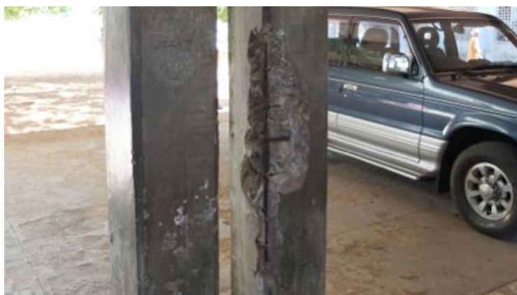
F.an.07 - Estrutura com descolamento do recobrimento das armaduras. Redução da secção. Corrosão das armaduras; Anomalia grave.
