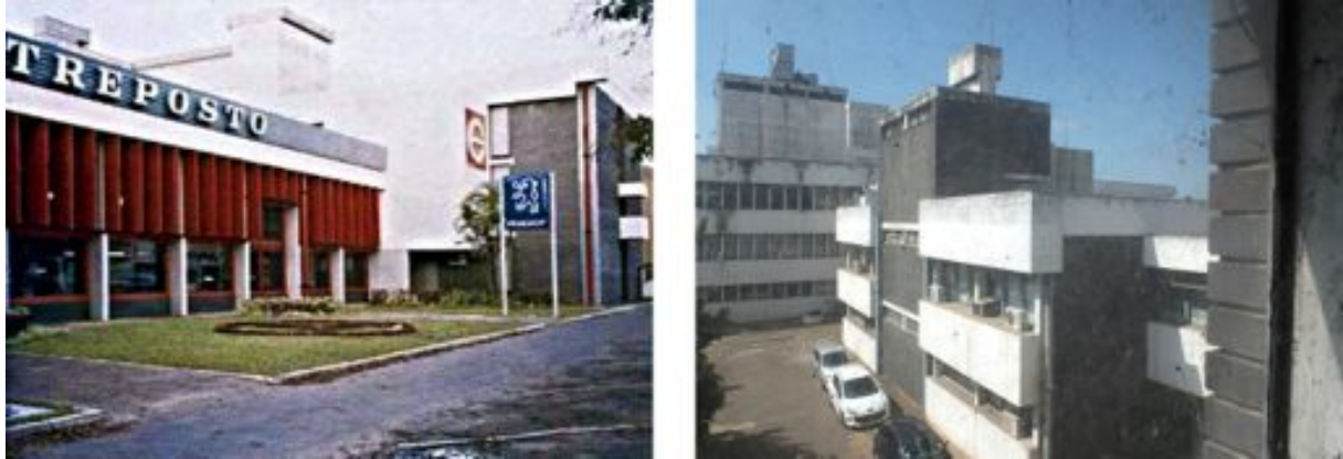
3.39 – Fachada Sul-Sudoeste (SSO) 3.40 – Fachada Norte-Nordeste (NNE). A fachada NNE incluía dispositivos brise-soleil semelhantes aos existentes na fachada SSO
