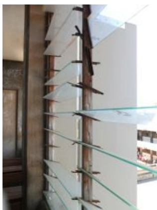
F.an.19 - Caixilharia com elementos removidos, motivando funcionamento muito deficiente ou eventuais acidente; Anomalia grave.
