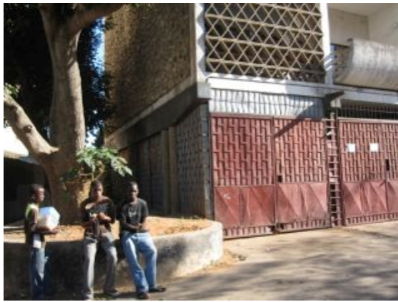
F.an.05 – Colonização biológica e coloração da laje; Anomalia ligeira.
