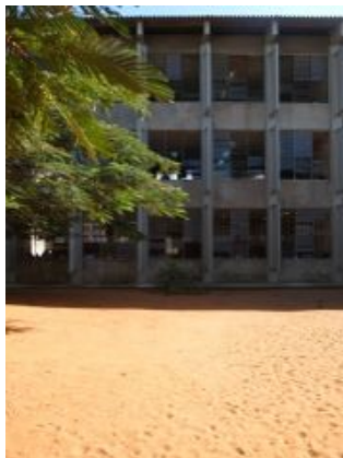
F.an.12 - Sinais de colonização biológica (junto ao solo) e coloração do betão por óxido de ferro; Anomalia ligeira.
