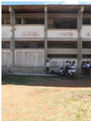
F.an. 14 – Revestimentos de paredes com manchas de sujidade ou alteração de cor; Anomalia média.
