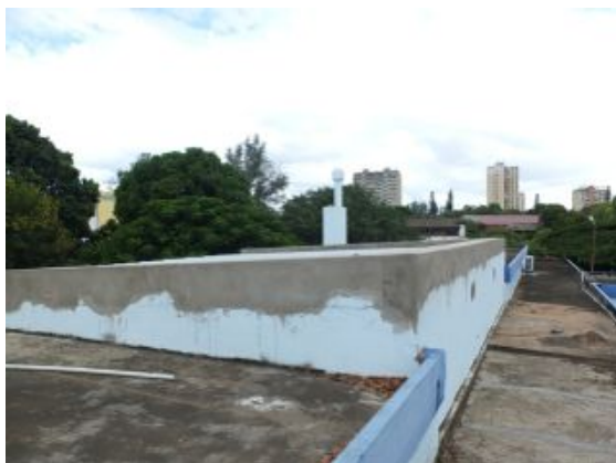
F.an.04 - Fissuração da pintura e reboco da platibanda; Anomalia ligeira.
