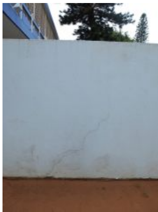
F.an.15 - Fissuração a 45° no reboco de muros exteriores, sugerindo assentamento diferencial das fundações; Anomalia ligeira.
