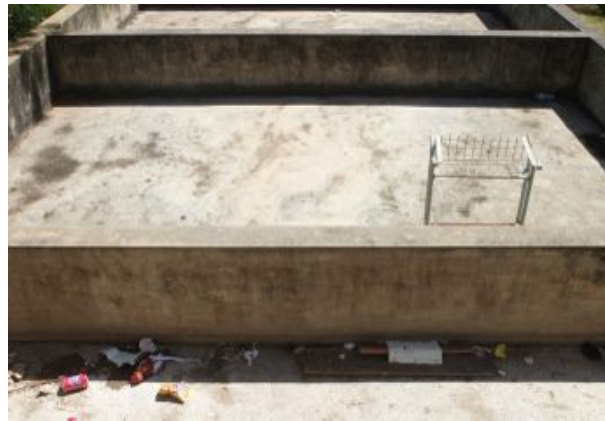
F.an.10 - Laje de cobertura com sujidade; Anomalia ligeira.
