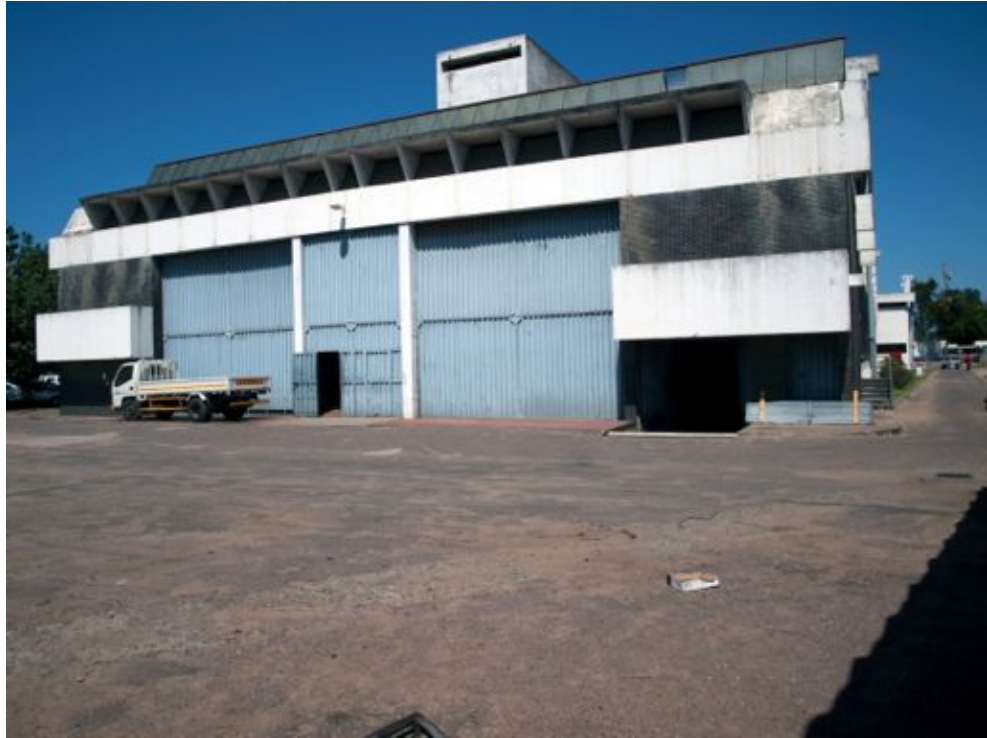
3.34 – Cais de cargas e descargas, na actualidade. Observa-se a tipologia da cobertura.
