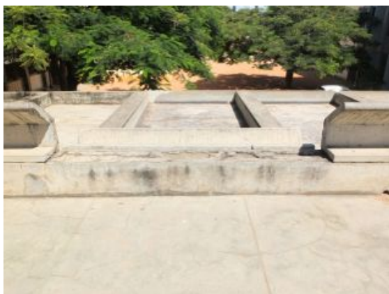
F.an.17 - Fendilhação generalizada de pequena abertura, tipo “craquelê”; Anomalia média.
