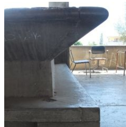
F.an.24 - Fissuração das guardas pré-fabricadas, seccionando a totalidade do elemento.
