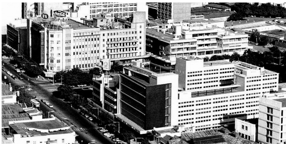
2.11 – Vista da Avenida da República (actual Avenida 25 de Setembro), com o edifício do Banco Nacional Ultramarino (1956-65), da autoria de José Bastos (1914-91).
