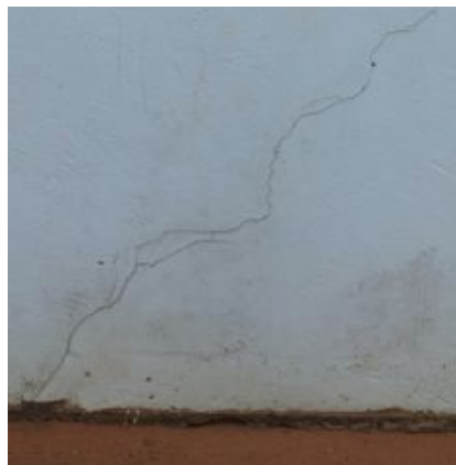
F.an.15 - Fissuração a 45° no reboco de muros exteriores, sugerindo assentamento diferencial das fundações; Anomalia ligeira.
