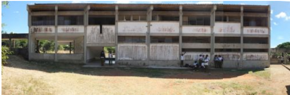
3.63 – Edifícios de canto coral e cantina 3.64 – Interior da cantina 3.65 – Fachada Sul do edifício da Mocidade Portuguesa (fotomontagem). 3.66 – Vista das salas de aula do bloco 3.
