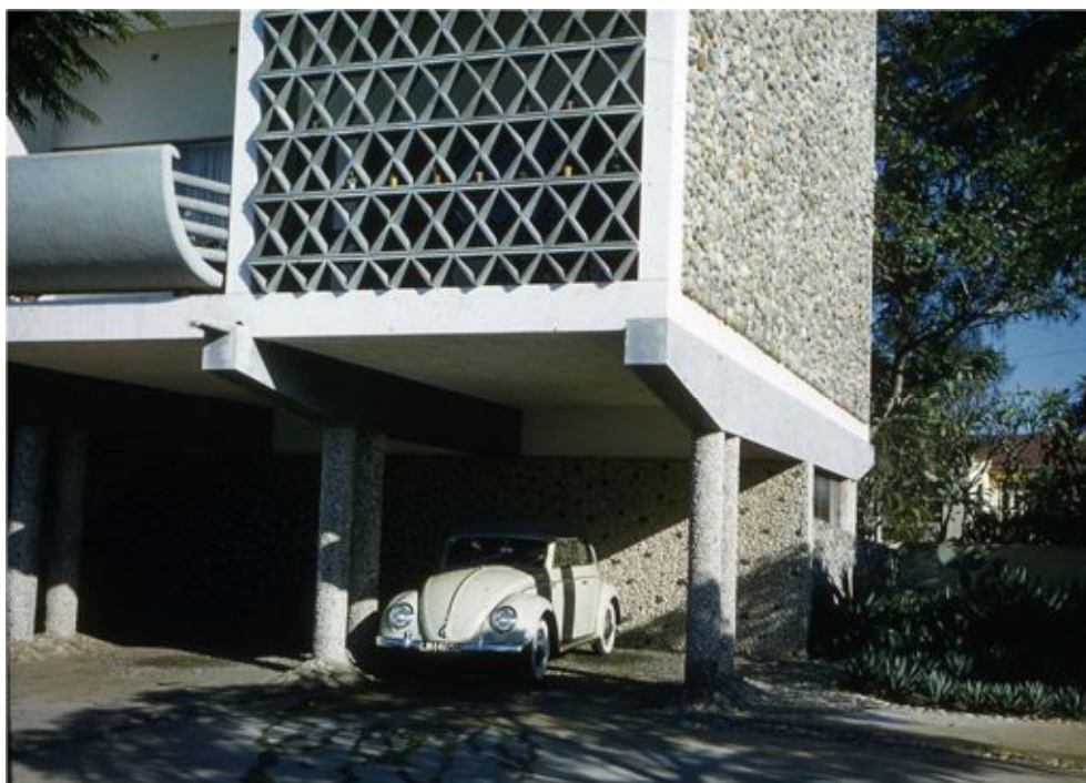
3.7 – Grelhas pré-fabricadas em betão, dispostas nas varandas expostas a Este-Sudeste.
