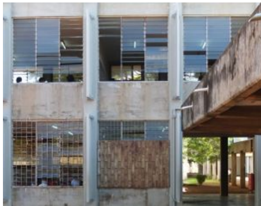
F.an. 20 – Caixilharia inexistente, substituída por painel de cartão; Anomalia grave.
