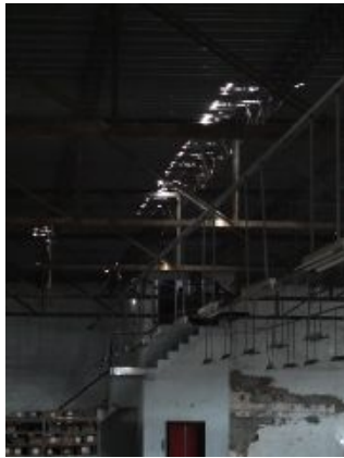
F.an.02 – Revestimento da cobertura em muito mau estado de conservação, não assegurando a estanquidade da solução. Anomalia grave.
