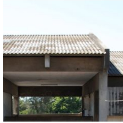
F.an.09 - Revestimento de cobertura inclinada com sujidades ou vegetação, mas não comprometendo a estanquidade à água; Anomalia ligeira.
