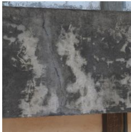
F.an.22 - Fissuração de elemento de sombreamento vertical; Anomalia ligeira.
