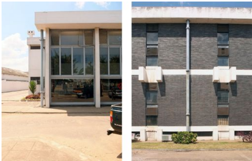
3.35 – Fachada Sul-Sudoeste (SSO) e 3.36 – Fachada Oeste- Noroeste (ONO). A fachada Sul-Sudoeste incluía dispositivos brise-soleil , entretanto removidos, que protegiam os vãos envidraçados.
