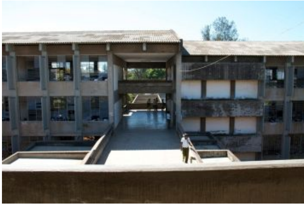
F.an.09 - Revestimento de cobertura inclinada com sujidades ou vegetação, mas não comprometendo a estanquidade à água; Anomalia ligeira.
