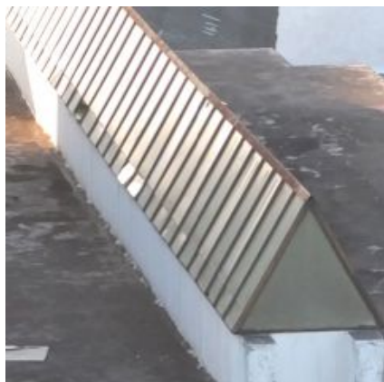
F.an.05 – Falta de elementos da claraboia em vidro; Anomalia média.
