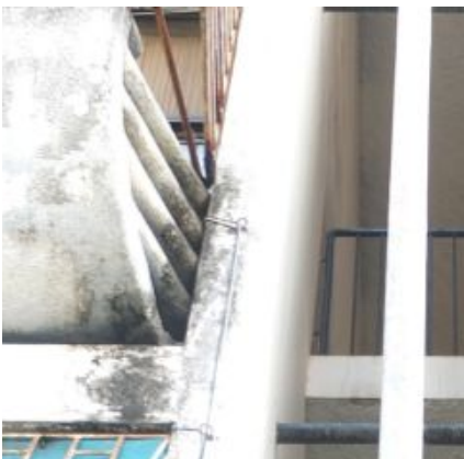
F.an.20 - Coloração das guardas em betão armado. Vestígios de humidade e colonização biológica; Anomalia ligeira.
