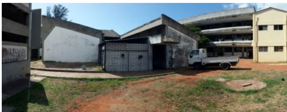
3.71 – Cobertura adicionada junto ao refeitório e edifício das instalações sanitárias.
