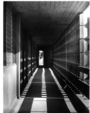
2.23 – Grelhas em betão armado, A importância do arejamento e sombreamento.
