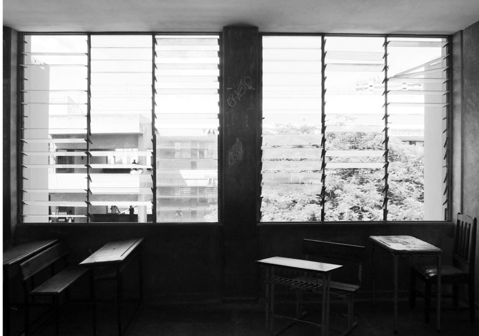
2.29 – Janelas tipo “beta” na “Escola Secundária da Polana”, Tinoco e José Forjaz, 1970.
