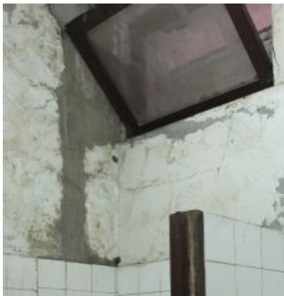
F.an.11 - Fissuração e degradação do reboco. Descamação da pintura. Amarelecimento da pintura da parede; Anomalia ligeira.
