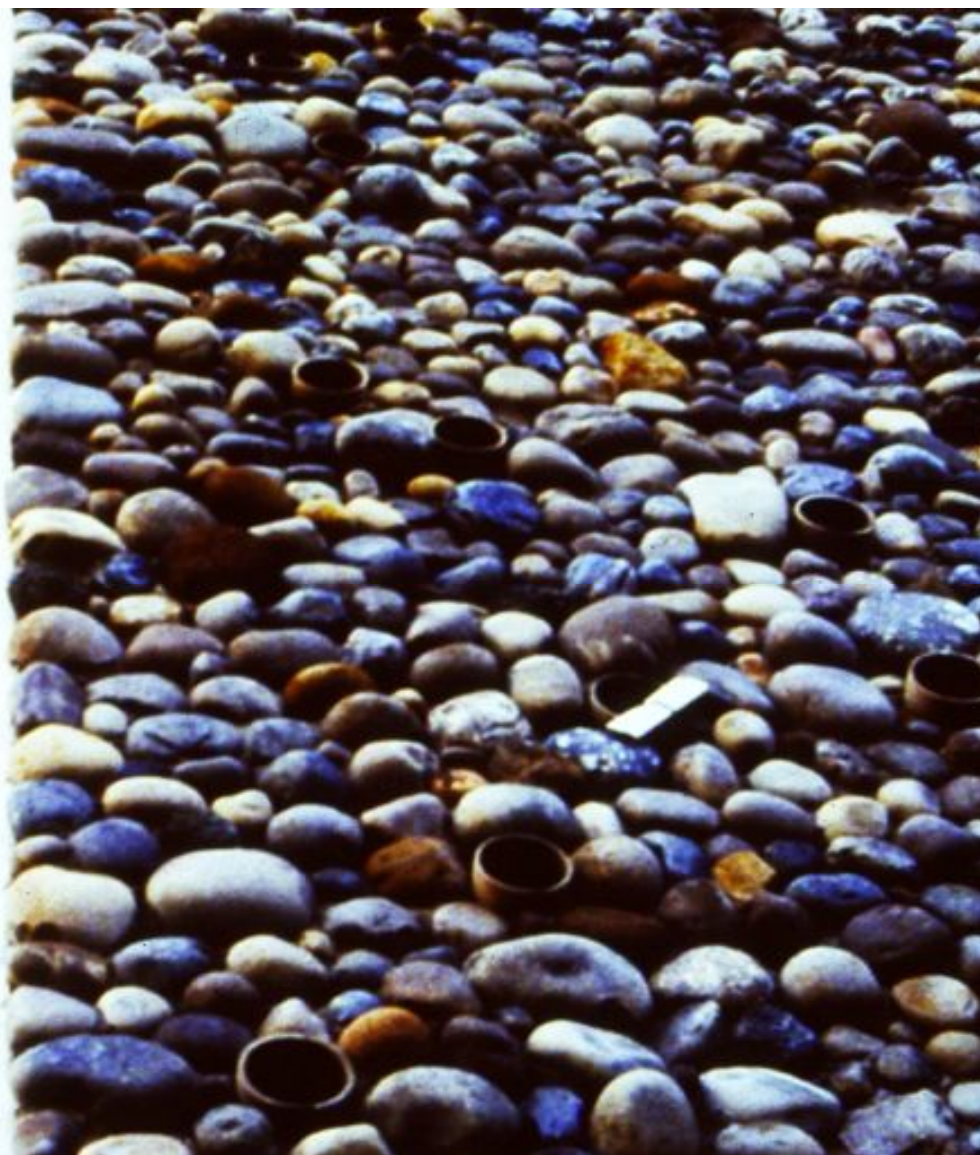
2.28 – Empena do edifício “Casa do Dragão” de Pancho Guedes, 1951. Tubos de betão pré-fabricados inseridos na parede revestida a seixos.
