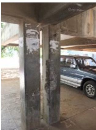
F.an.07 - Estrutura com descolamento do recobrimento das armaduras. Redução da secção. Corrosão das armaduras; Anomalia grave.
