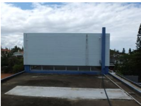
F.an.12 - Coloração do revestimento da parede. Anomalia ligeira.
