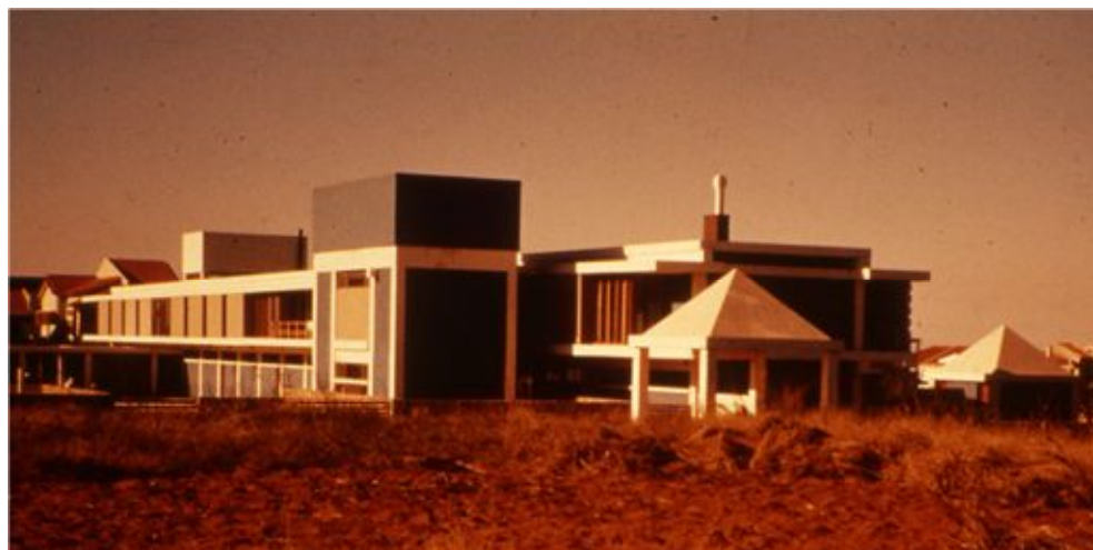
3.16 – As galerias viradas a Noroeste. 3.17 – As arrecadações de apoio à área dos pátios.
