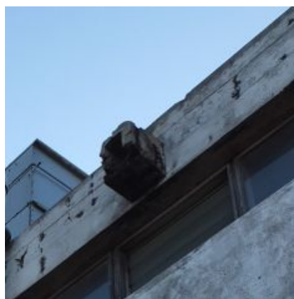
F.an.07 - Coloração do revestimento das paredes a sugerir presença de água e humidade; Anomalia ligeira.
