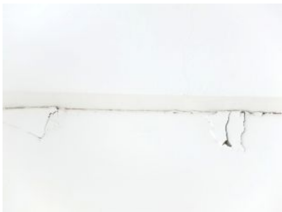
F.an.16 - Fendilhação e empolamento do revestimento (reboco) por esmagamento da parede; Anomalia ligeira.
