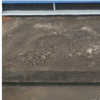
F.an.06 - Superfície com sujidade e vestígios de colonização biológica sem comprometer a estanquidade à água; Anomalia ligeira.
