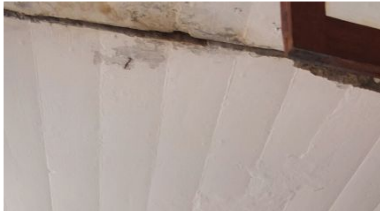
F.an.02 – Coloração do betão a sugerir corrosão das armaduras. Anomalia média.
