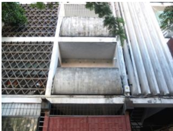
F.an.03 - Fendilhação dos pilares em betão armado; Anomalia ligeira.
