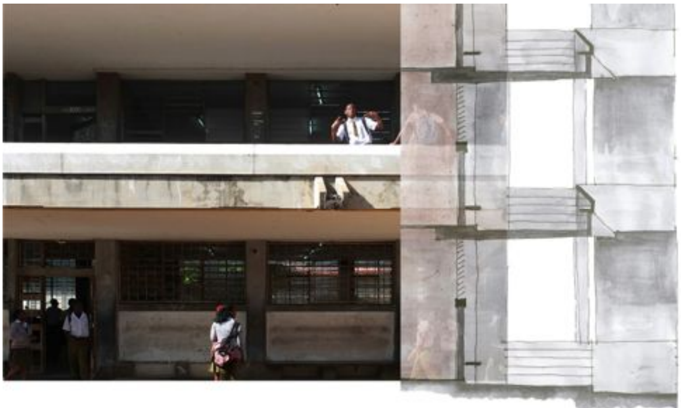
3.77 – Vista da galeria de circulação, exposta a Sul, de acesso ao bloco das salas de aula.
