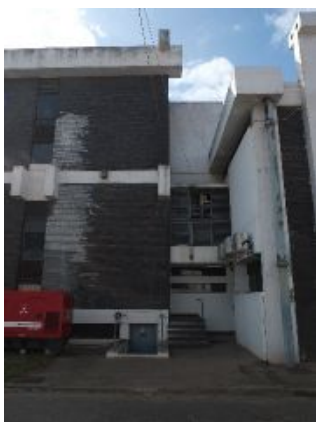
F.an.07 - Coloração do revestimento das paredes a sugerir presença de água e humidade; Anomalia ligeira.
