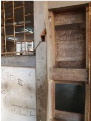
F.an.11 - Fendilhação do revestimento e desintegração da alvenaria de tijolo, podendo motivar danos noutros elementos; Anomalia média.
