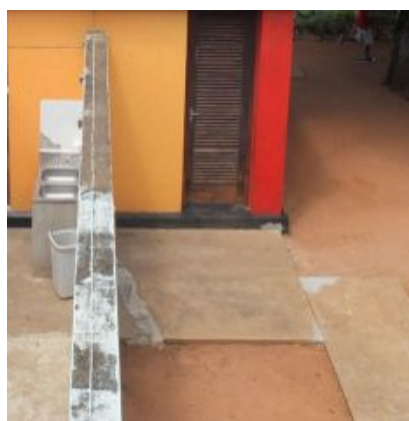
F.an.19 - Betonilha de acabamento do pavimento com fendilhação. Reparações que não preservaram o aspecto original; Anomalia ligeira.
