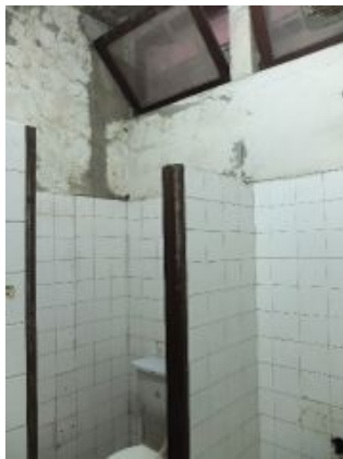
F.an.11 - Fissuração e degradação do reboco. Descamação da pintura. Amarelecimento da pintura da parede; Anomalia ligeira.
