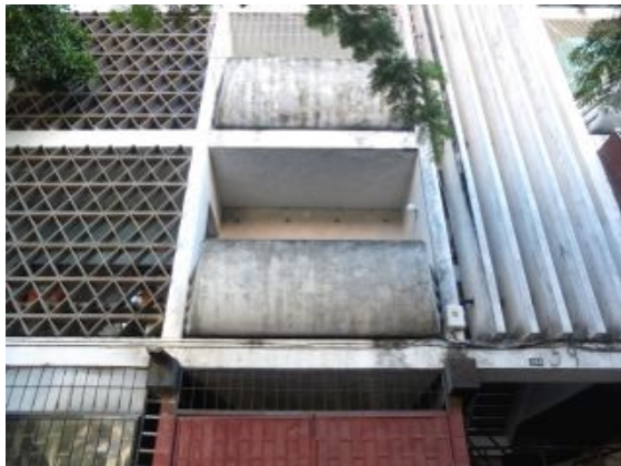
F.an.19 - Coloração e sujidade das guardas em betão armado; Anomalia ligeira.
