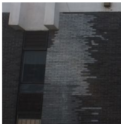
F.an.07 - Coloração do revestimento das paredes a sugerir presença de água e humidade; Anomalia ligeira.
