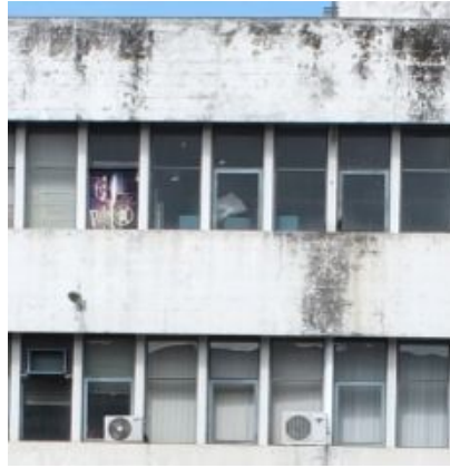
F.an.09 – Enegrecimento das paredes em betão armado; Anomalia ligeira.
