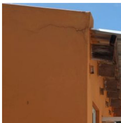
F.an.10 - Sinais de apodrecimento de estrutura em madeira. Fissuração do revestimento da platibanda. Anomalia ligeira.
