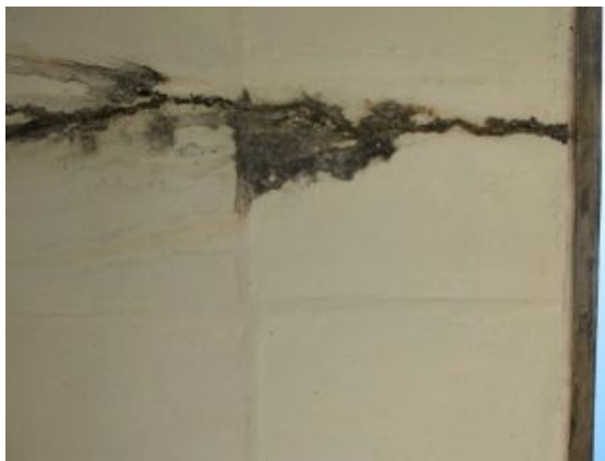
F.an. 05 - Fendilhação de grande extensão de pequena abertura que não indicia problemas estruturais. Sinais de corrosão; Anomalia média.
