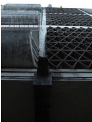
F.an.08 - Coloração dos pilares em betão armado. Possível colonização biológica; Anomalia ligeira.
