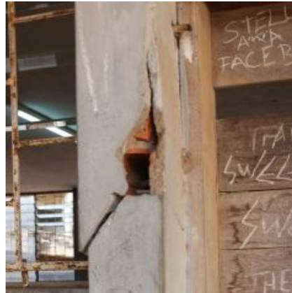
F.an.11 - Fendilhação do revestimento e desintegração da alvenaria de tijolo, podendo motivar danos noutros elementos; Anomalia média.
