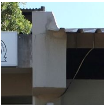
F.an.08 - Estrutura secundária da cobertura com deterioração de elementos; Fissuração do revestimento de platibanda; Anomalia ligeira.
