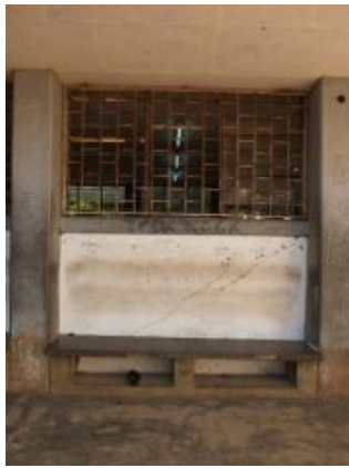
F.an. 13 – Revestimentos de piso em falta, em desagregação, em áreas limitadas; Anomalia ligeira.
