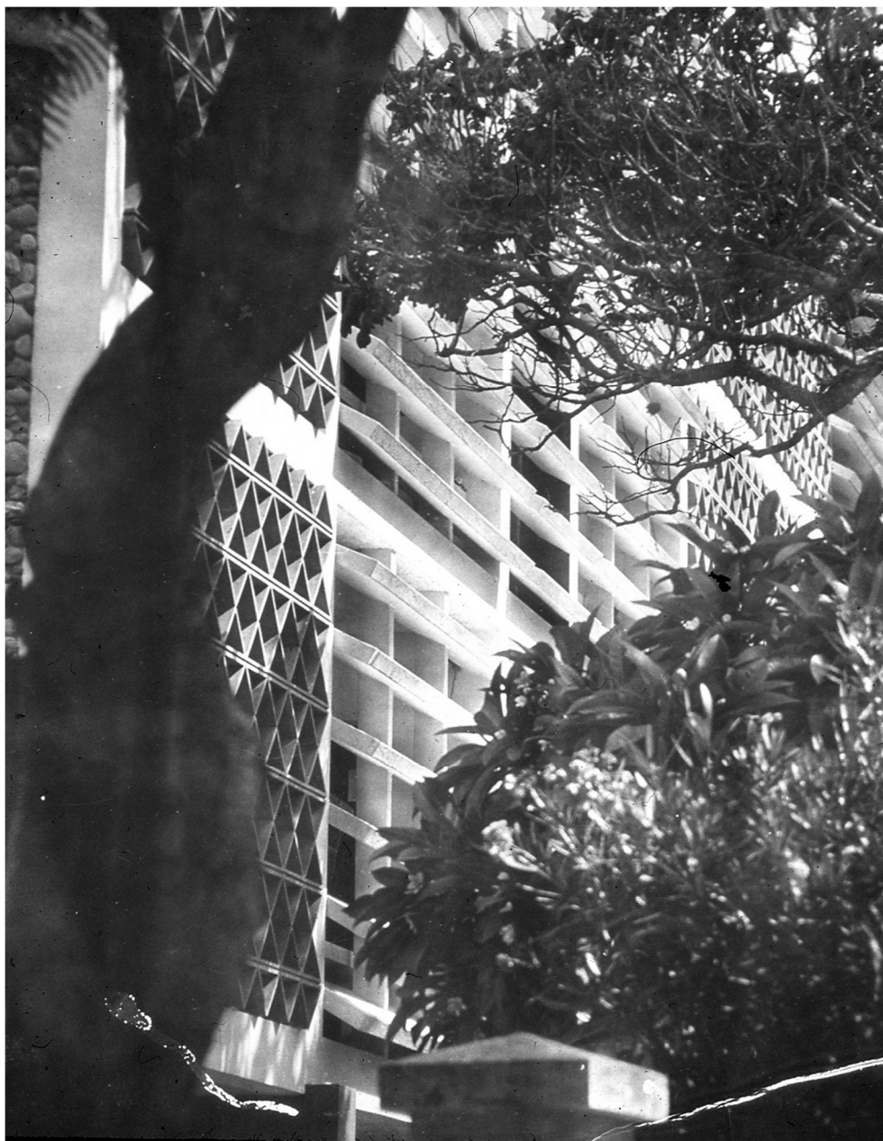
3.8 – Grelhas pré-fabricadas em betão, e brise-soleil , em varandas expostas a Oeste-Noroeste.
