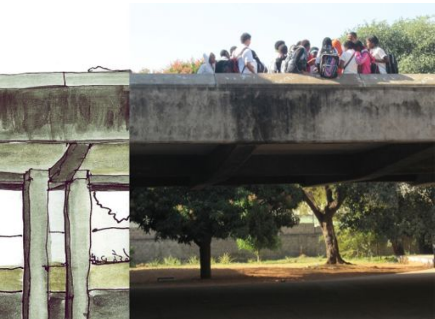
3.70 – Pormenor da galeria de circulação entre os dois blocos de salas de aula, ao nível do primeiro piso. Na sua dimensão inclui um vão de 10,80 metros de extensão.
