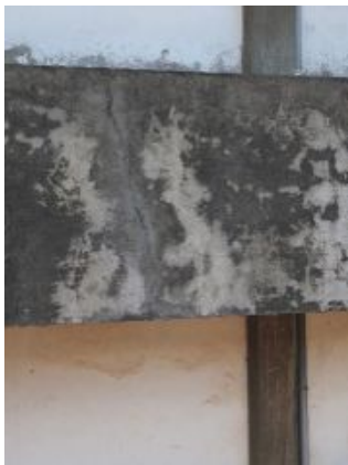
F.an.22 - Fissuração de elemento de sombreamento vertical; Anomalia ligeira.
