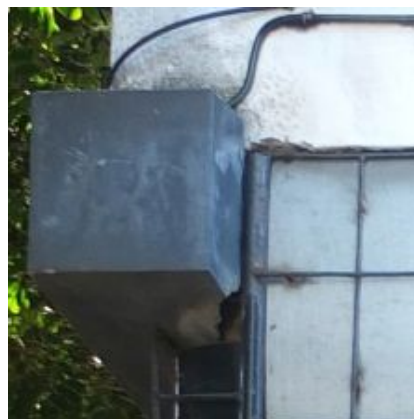
F.an.04 - Destacamento do revestimento da laje em betão armado; Anomalia média.
