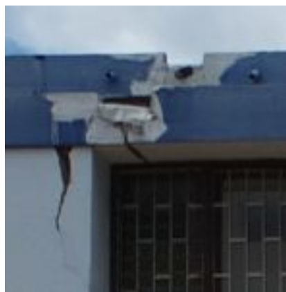
F.an.11 - Revestimento de protecção (reboco) de parede empolado e fissurado em área limitada; Anomalia média.
