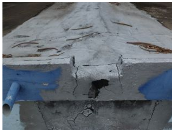
F.an.03 - Revestimento de impermeabilização incorrectamente aplicado, colocando em risco a estanquidade à água; Anomalia média.
