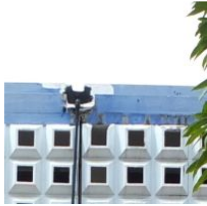
F.an.21 - Falta de parte de bloco de betão, pondo em causa a estanquidade da solução construtiva; Anomalia média.
