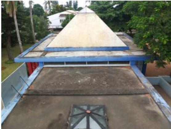
F.an.06 - Superfície com sujidade e vestígios de colonização biológica sem comprometer a estanquidade à água; Anomalia ligeira.
