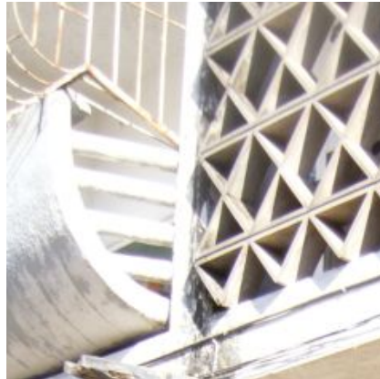
F.an.08 - Coloração dos pilares em betão armado. Possível colonização biológica; Anomalia ligeira.
