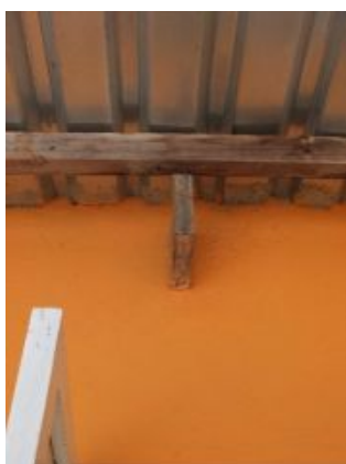
F.an.10 - Sinais de apodrecimento de estrutura em madeira. Fissuração do revestimento da platibanda. Anomalia ligeira.
