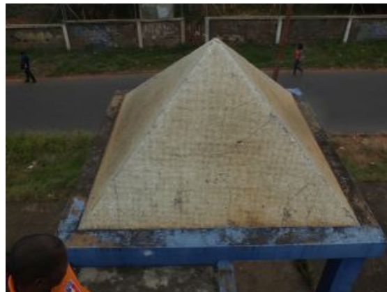
F.an.08 - Revestimento de cobertura inclinada com sujidades e alguns elementos deteriorados; Anomalia média.
