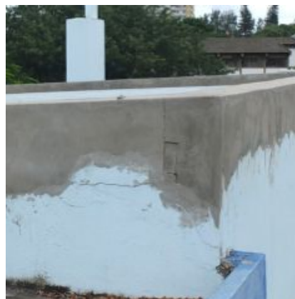
F.an.03 - Revestimento de impermeabilização incorrectamente aplicado, colocando em risco a estanquidade à água; Anomalia média.
