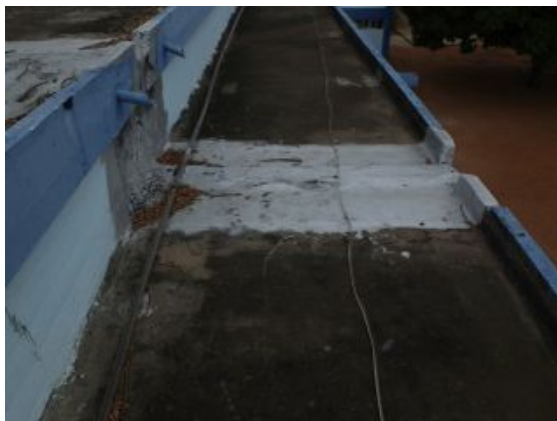
F.an.03 - Revestimento de impermeabilização incorrectamente aplicado, colocando em risco a estanquidade à água; Anomalia média.
