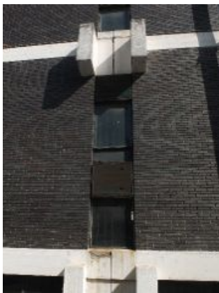
F.an.12 - Coloração do revestimento do elemento estrutural e depósito de sais no mesmo. Fendilhação; Anomalia média.
