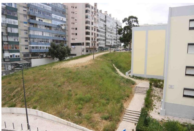
Figura 4.12: Interior do quarteirão a norte da Rua dos Soeiros
