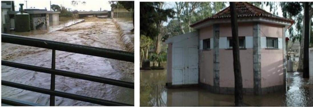
Figura 4.14 Cheias de 2008, no troço final da Ribeira da Laje. Fonte: (Municipia, 2011)
