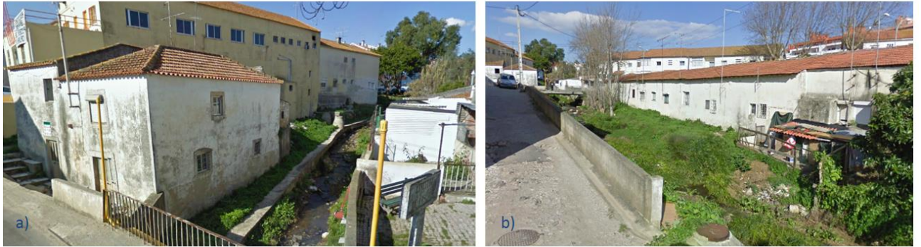
Figura 4.11 Troços da Ribeira da Laje, na povoação de Talaíde. Fonte: (Google, 2013)
