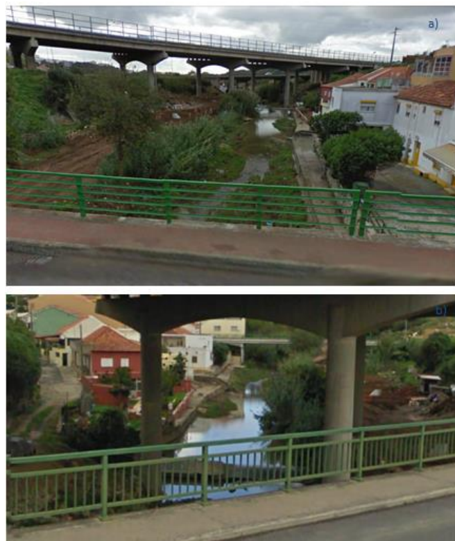
Figura 4.12 Troços da Ribeira da Laje, na povoação da Laje. Fonte: (Google, 2013)
