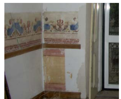
Fig. 4.20 - Pinturas murais. Calçada de Santana, nº 18 - 22
