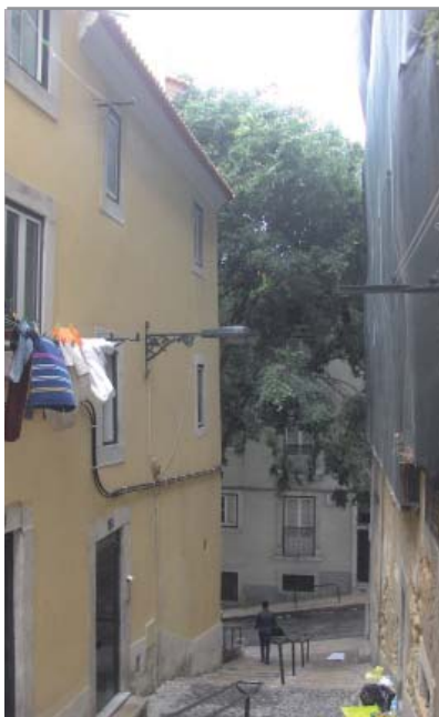
Fachada lateral. 07 de Junho 2013
