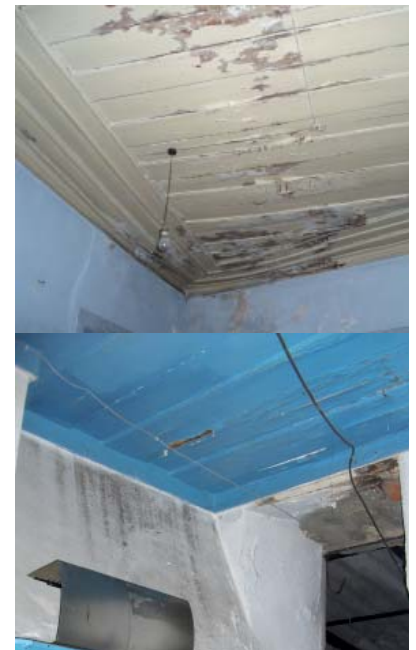
Fig. 4.17 e 4.18- Tecto ‘encabeirado’ e ‘saia e camisa’. Rua do Arco da Graça nº 45.e Tv. Forno do Torel, nº 19
