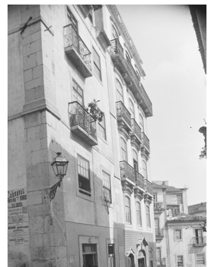
Fig. 5.05 - Cç. Santana, nº 24-26. Edifício de habitação plurifamiliar joanino classificado como imóvel de interesse municipal. Apresenta elevado grau de degradação.
