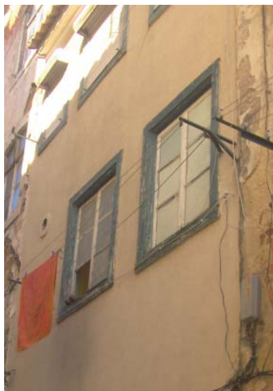
Fig. 4.05 - Moldura de janela em madeira. Cç. Nova do Colégio, nº 24 - 26.
