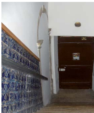
Fig. 4.58 - Arco fechado entre as escadas e o restaurante no rés-do-chão, nº 29-31.
