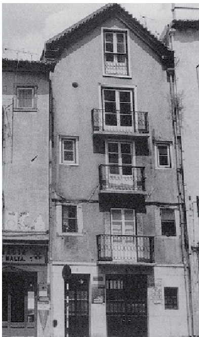
Fig. 2.02 - Prédio de fachada em bico, Rua dos Remédios nºs 1 -3, in Prédios e vilas de Lisboa , Irene Buarque, Nuno Teotónio Pereira, 1995.
