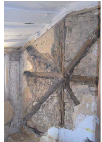
Fig. 4.08 - Parede de frontal. Largo do Convento da Encarnação, nº1.
