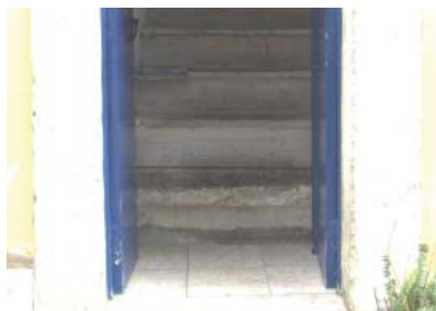
Fig. 4.27 - Primeiro degrau em pedra. Rua Martim Vaz, 76-78.
