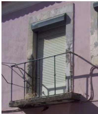
Fig. 4.15 - Grade em 'varão e nó'. Tv. do Forno do Torel, nº 13 - 23.
