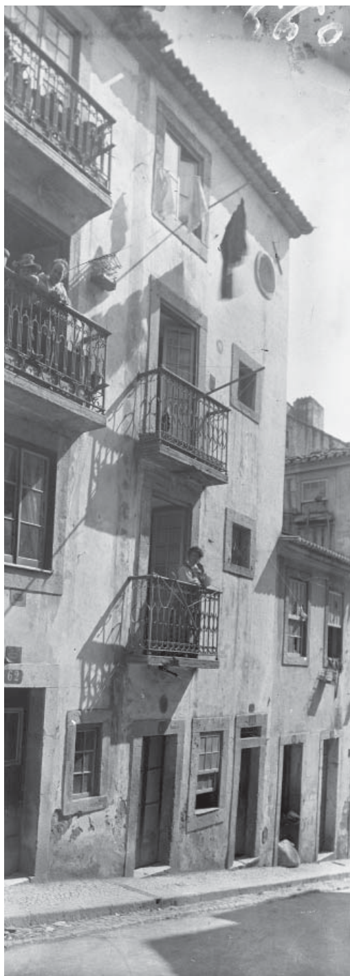
Autor NI; entre 1898 a 1908; Arquivo Fotográfico Municipal
