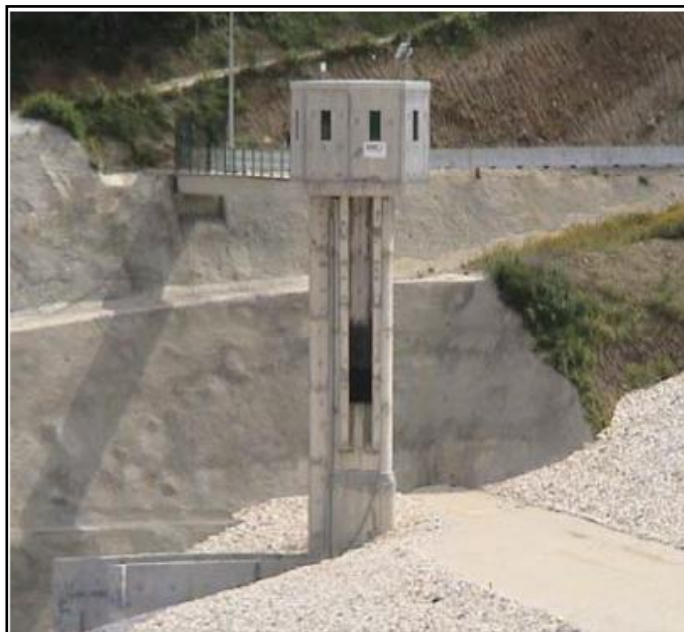
Figura 5.4- Torre de manobra de equipamentos. Barragem de Óbidos (Pinheiro,2006).
