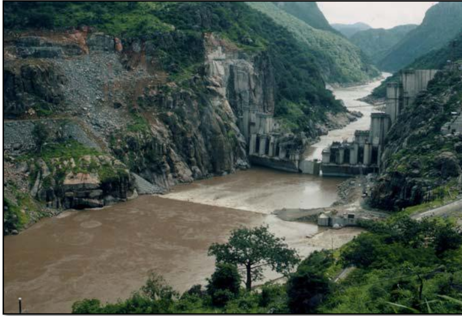
Figura 3.27- Barragem de Cahora Bassa (Moçambique), galgamento das ensecadeiras (Fotografia cedida por Prof. António Quintela in Pinheiro, 2002)
