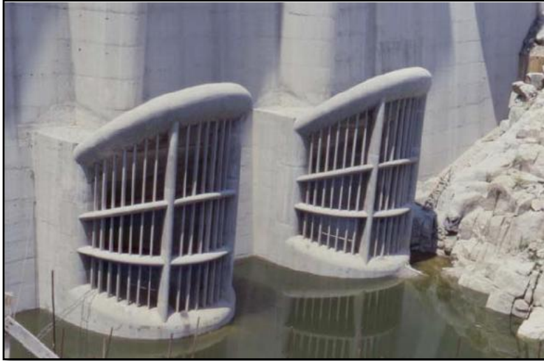
Figura 5.3- Exemplo de grelha de betão instalada numa estrutura de descarga de fundo (Pinheiro,2006).
