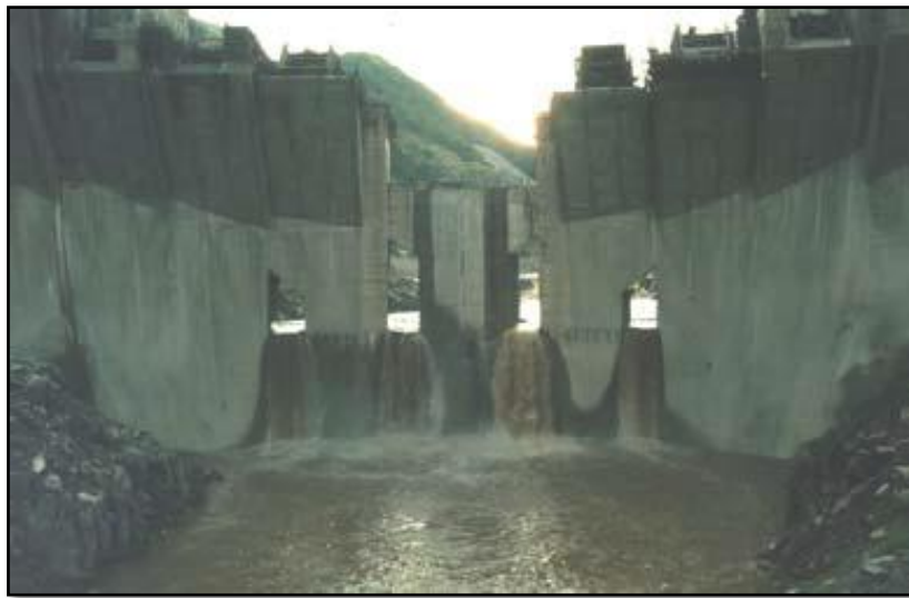
Figura 3.12- Barragem de Cahora Bassa. Desvio provisório por orifícios e brecha central na barragem (Quintela, 2002).
