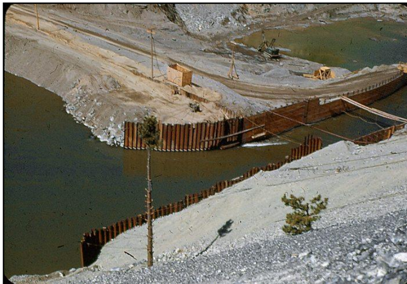
Figura 3.8- Barragem de Canyon Ferry (EUA). Canal de desvio revestido com estacas-prancha. ( http://www.helenahistory.org/dams.htm )
