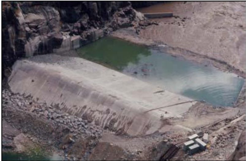
Figura 3.23- Barragem de Cahora Bassa (Moçambique), ensecadeira de jusante (Fotografia cedida por Prof. António Quintela in Pinheiro, 2002).
