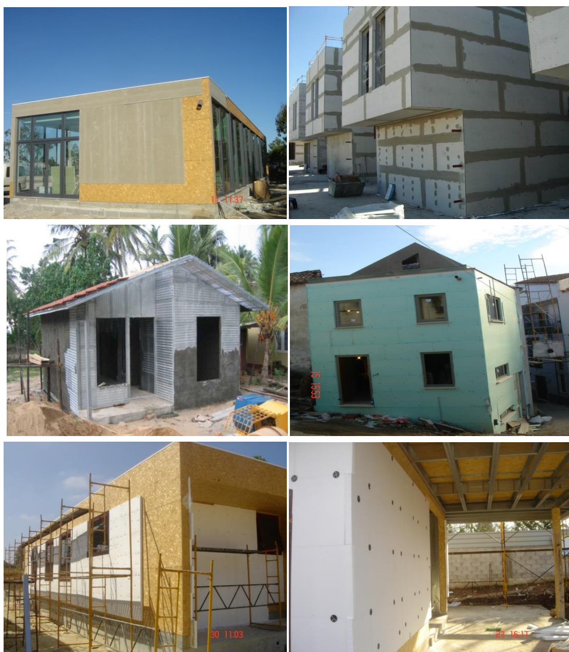
Figura 3.11 – Utilização de diversas soluções de revestimento exterior sobre o OSB
