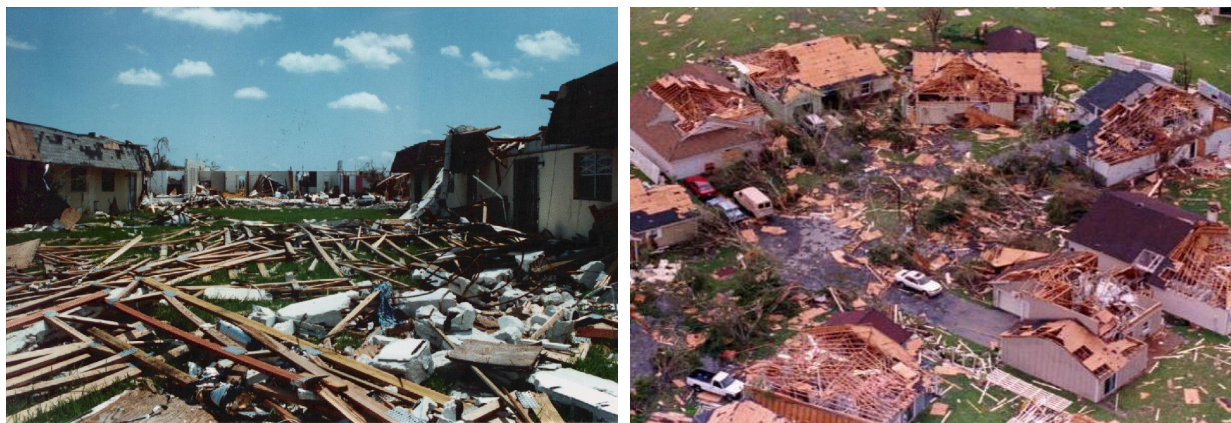
Figura 1.4 - Fotografias de Dade County (Florida, 24 Agosto de 1992) mostrando o nível de destruição de habitações, essencialmente construídas com estrutura de madeira
