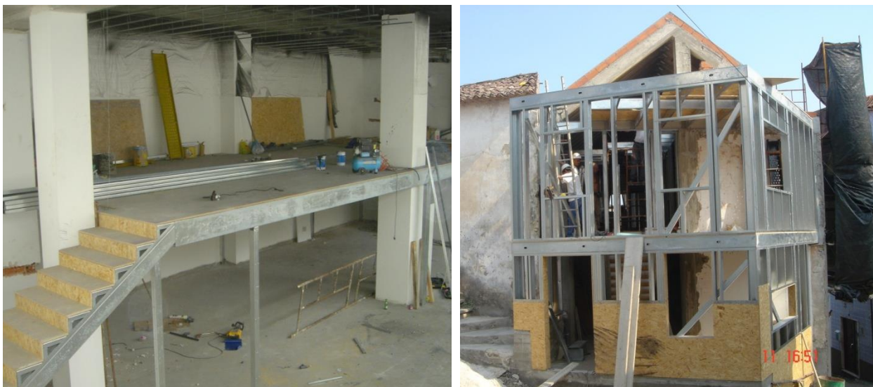
Figura 2.8 - (a) Compartimentação vertical (introdução de pisos intermédios) e (b) ampliação horizontal
