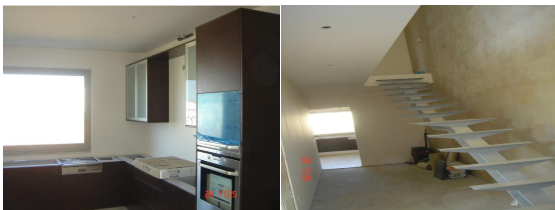
Figura 3.15 – Utilização de acabamentos interiores tradicionais (armários e revestimentos cerâmicos).
