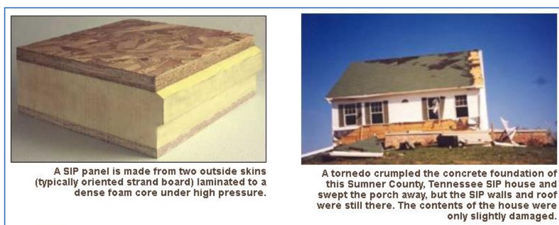
Figura 10.8 – Painel SIPS e Casa construída com SIPS arrancada da fundação por um tornado, mas não destruída (Starcraft Custom Builders, www.starcraftcustombuilders.com )
