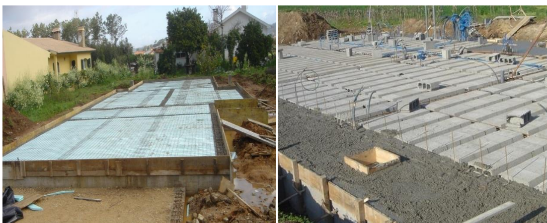
Figura 3.2 – Fundações e laje com caixa de ar
