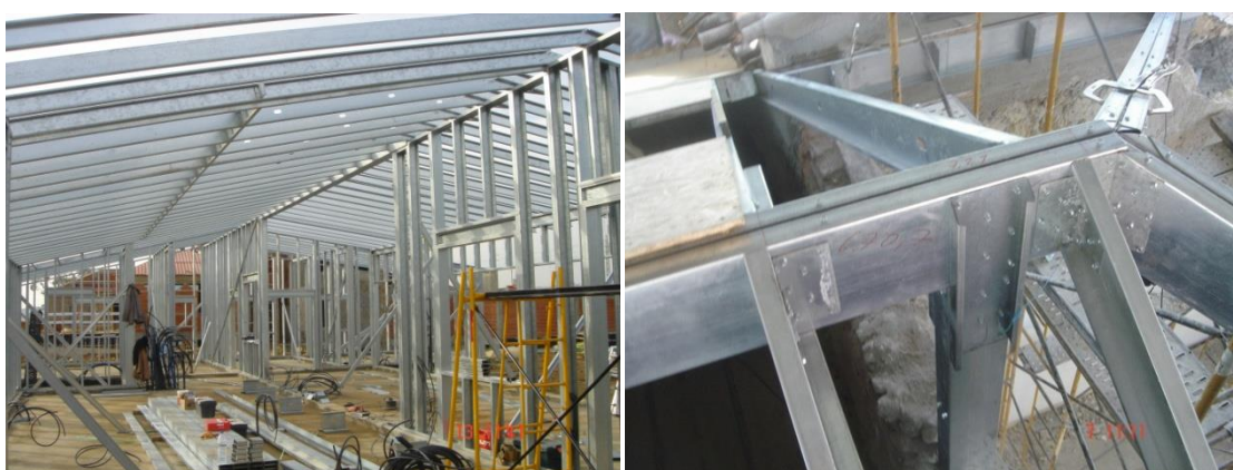
Figura 3.5 – Vista interior da estrutura metálica com travessas inclinadas: (a) pormenor de zona de janela e (b) pormenor do nó de ligação de cobertura.
