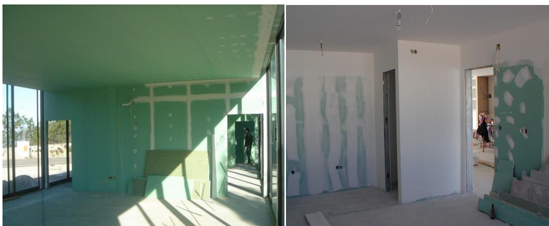
Figura 3.13 – A utilização de gesso cartonado como revestimento interior permite obter um ótimo desempenho acústico e resistência melhorada ao fogo.
