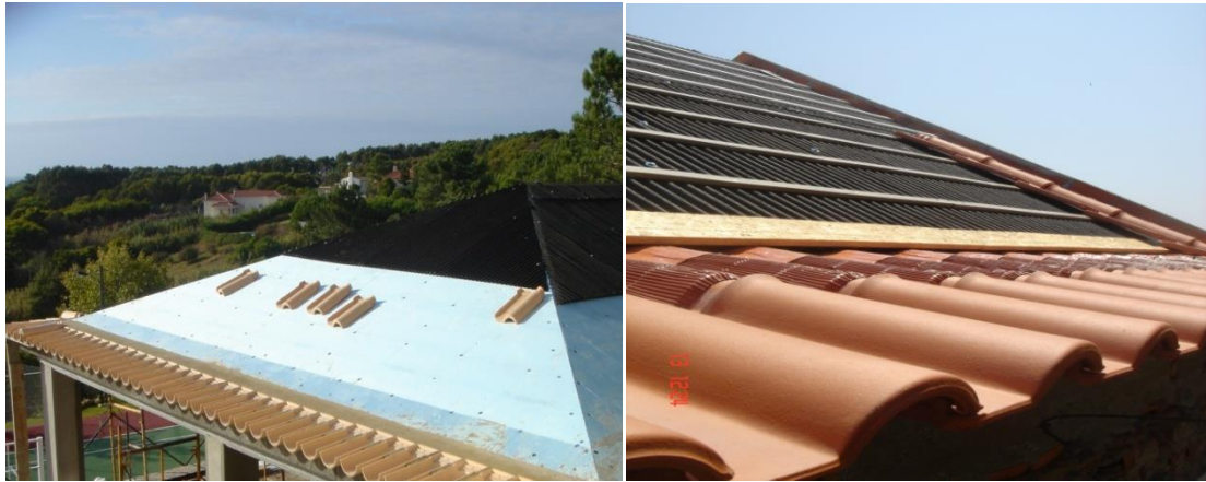
Figura 3.8 – Utilização de telha lusa e beirado à Portuguesa em cobertura inclinada tradicional
