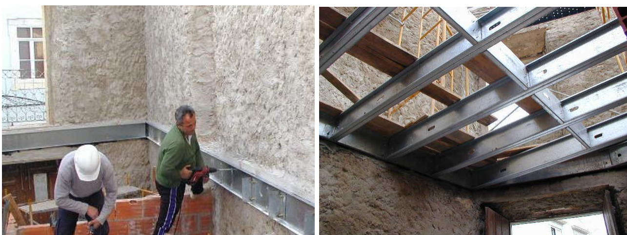
Figura 2.9 - (a) Fixação do canal de aço leve sobre tela asfáltica e lintel de coroamento e (b) inserção de vigas de aço leve apoiadas no canal de bordadura.
