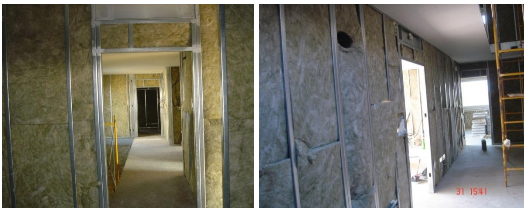
Figura 3.12 – A utilização de lã-de-rocha permite obter uma elevado desempenho acústico, térmico e resistência ao fogo.
