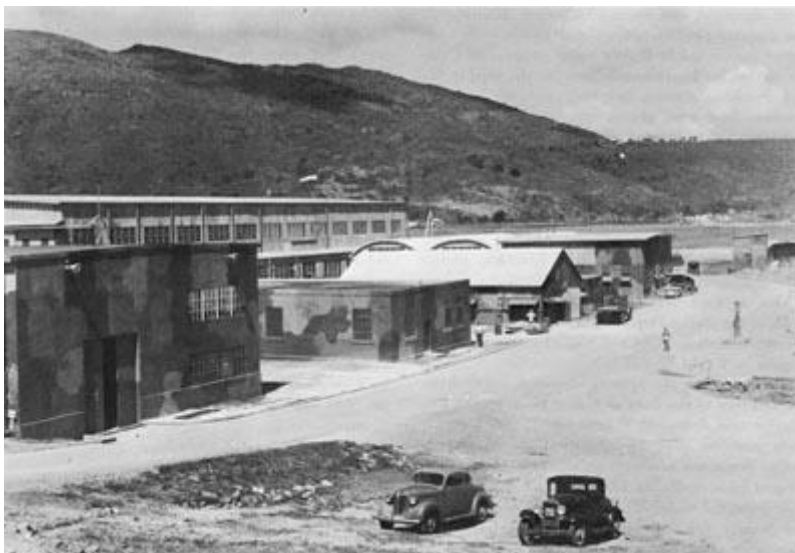
Figura 1.3 - Construção em LSF no campo Bourne, em Saint Thomas Island [2]
