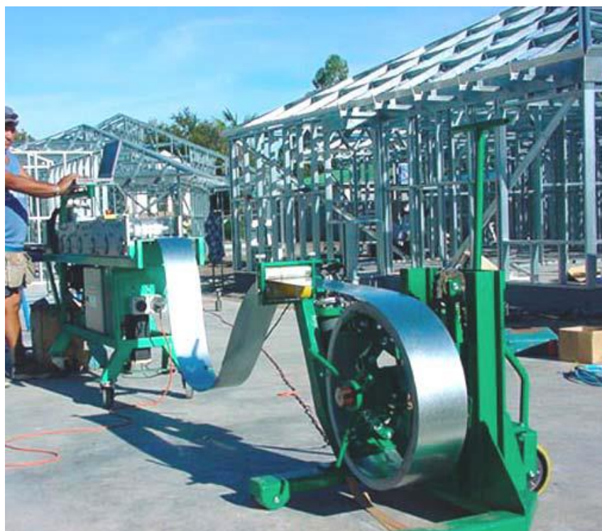
Figura 1.5 – Perfiladora em utilização numa obra
