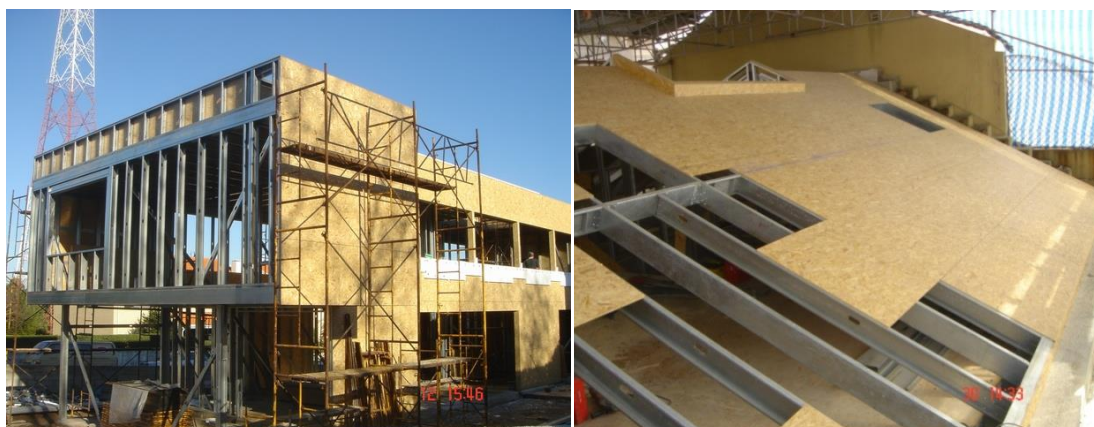
Figura 3.6 – Utilização de OSB como revestimento exterior e diafragma estrutural: (a) nas paredes e (b) na cobertura inclinada.
