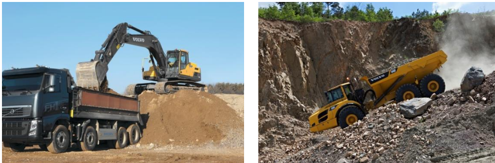
Figura 25: Camião basculante e escavadora (Esq.); Dumper (Dir.). (36)
