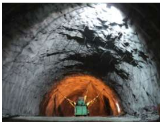
Figura 40 - Fotografia da colocação de pregagens.
