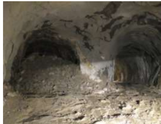
Figura 37 - Fotografia do resultado da detonação.
