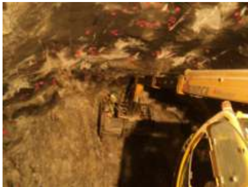
Figura 31 – Fotografia da marcação da frente.
