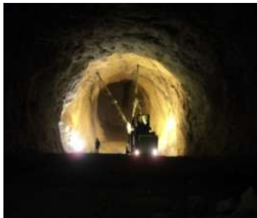
Figura 32 - Fotografia da furação da frente.
