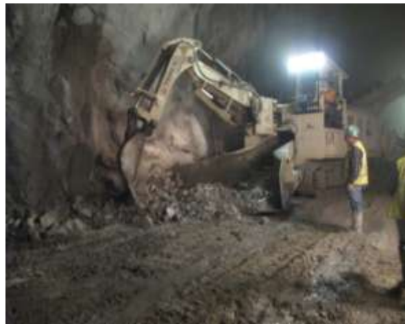
Figura 39 - Fotografia da remoção do escombro.
