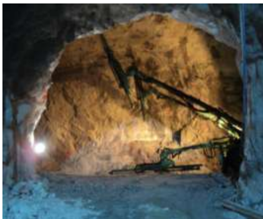
Figura 33 - Fotografia da furação da frente.
