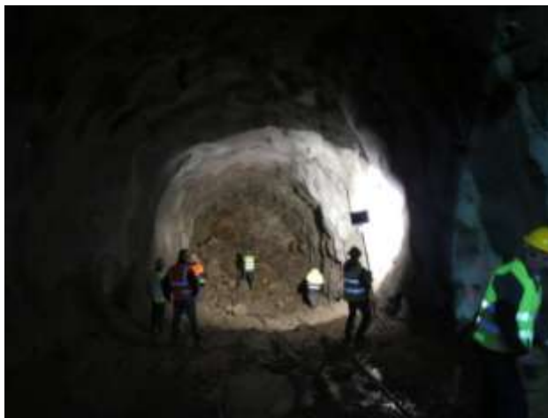
Figura 38 - Fotografia da rega do escombro.
