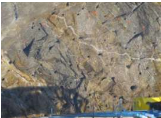
Figura 36 - Fotografia da frente antes da detonação.
