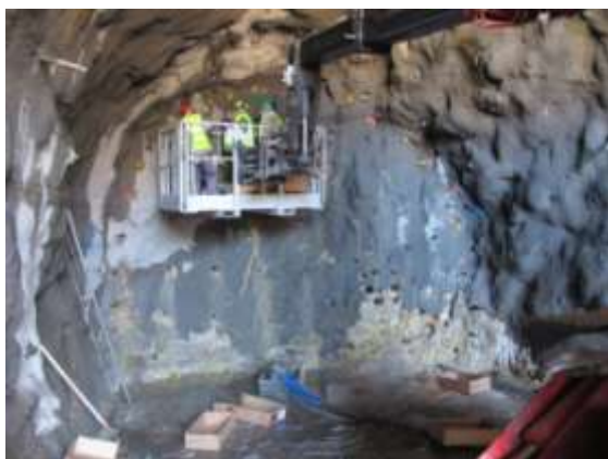
Figura 34 - Fotografia do carregamento dos explosivos.
