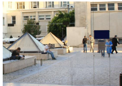
Figura 4: Pátio da Biblioteca da FLUL. As pirâmides envidraçadas, pontos de iluminação zenital para iluminação do corredor do piso inferior, funcionam igualmente como assento para quem quiser descansar ou ler ao ar livre. Ao fundo do pátio localiza-se o bar da faculdade.
