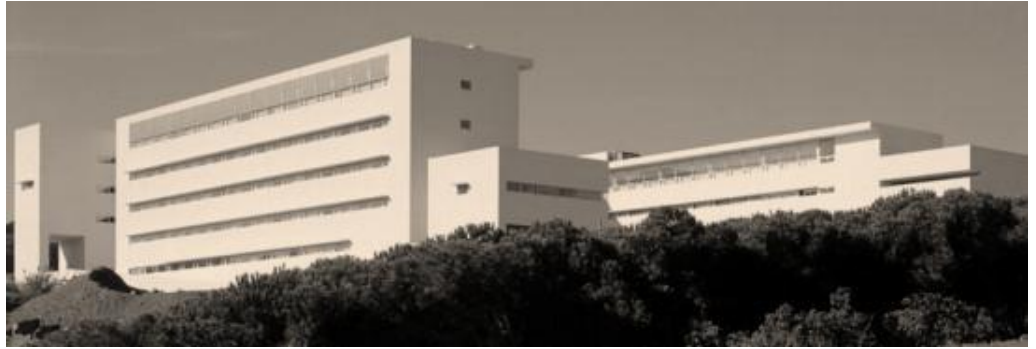
Figura 122: Vista da fachada sudeste do Instituto Superior de Ciências Sociais e Políticas. A implantação do edifício num planalto permite-lhe o destaque visual desde longe. A sua dominância visual sobre os arredores e vistas panorâmicas para a cidade de Lisboa, são características intrínsecas deste objeto arquitetónico. Autores: Sérgio e Fernando Guerra e José Manuel Costa Alves. Fonte: http://www.byrnearqu.com . Consultado a 07-06-2012.
