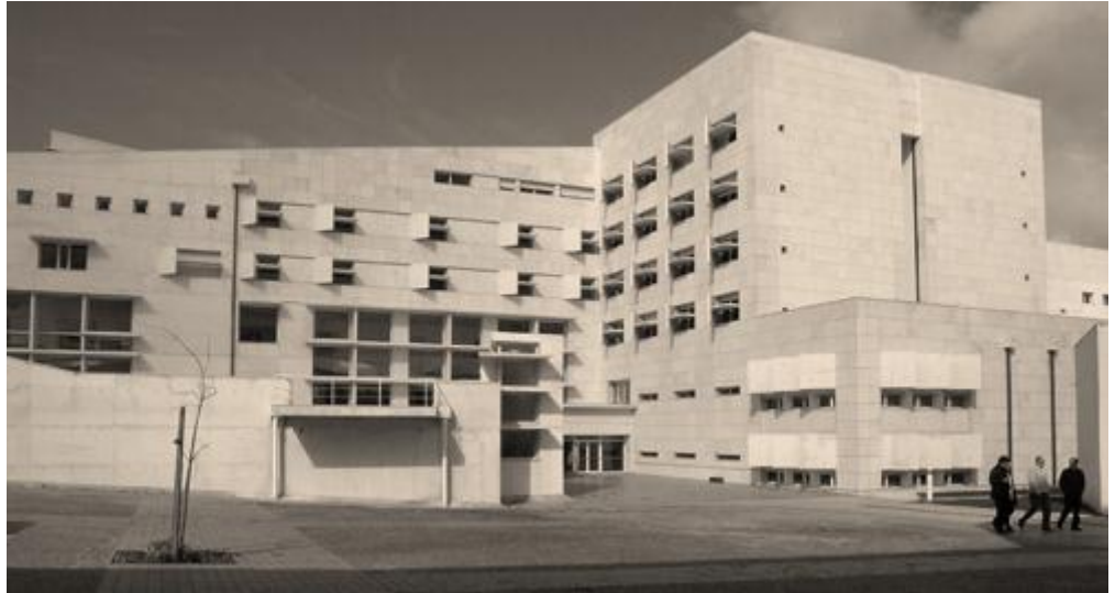
Figura 85: Vista da fachada da biblioteca do Instituto Superior de Ciências do Trabalho e da Empresa. Fonte: http://arrumario.blogspot.pt/2006/02/ral-hestnes-ferreira.html . Consultado a 27-08-2012.
