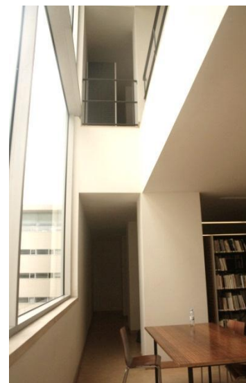
Figura 132: Vista do átrio de triplo pé-direito que atravessa as salas de leitura do corpo norte da Biblioteca do ISCSB. A existência deste vazio enriquece o sistema de vistas múltiplas sobre o espaço dinamizando a sua vivência interior. No entanto, é uma fonte de propagação de ruído entre os pisos.
