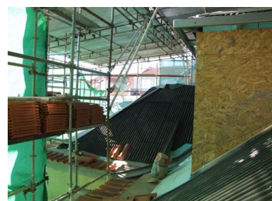
119: Cobertura sem revestimento final
