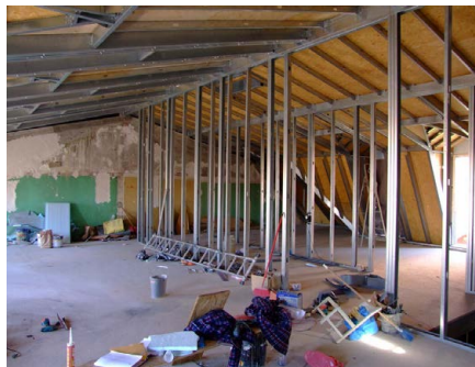
102: Núcleo central do piso da cobertura
