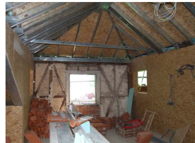
116: Integração de paredes preexistentes
