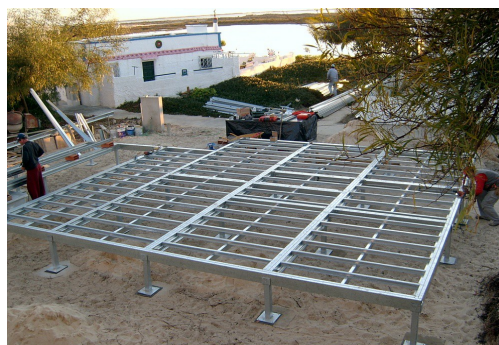
41: Laje de pavimento sobre-elevada apoiada em pilotis, Ilha da Armona, Olhão
