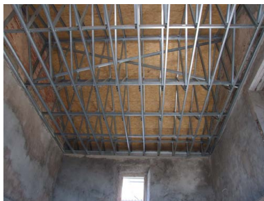
127: Perspectiva inferior da estrutura da cobertura
