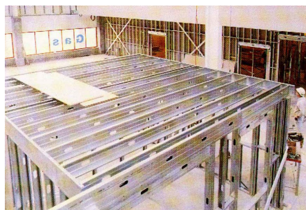
28: Execução de sub-piso (Trebilcock 1994)
