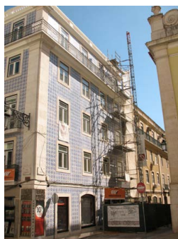
105: Estaleiro localizado na Rua Anchieta
