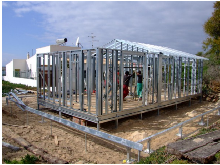
30. Construção por elementos, Ilha da Armonia, Olhão, 2007
