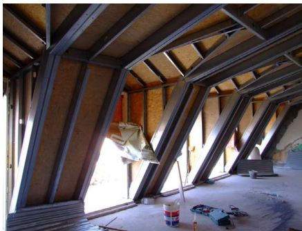
101: Trapeiras para a fachada principal no piso da cobertura
