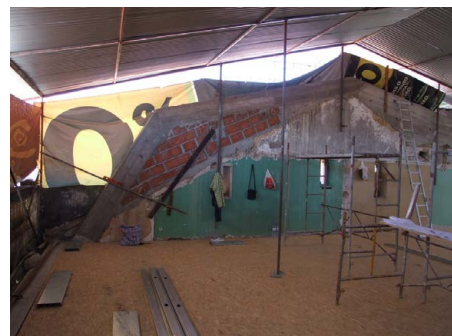
85: Vigas de betão armado nas parede de empena no piso do sótão
