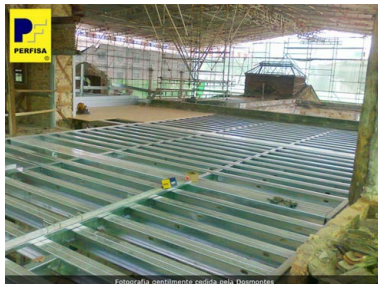
114: Execução do pavimento do 4º piso (Dosmontes & Perfisa 2012)
