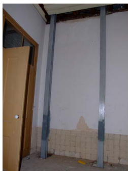
83: Pilares HEB120 no piso 2
