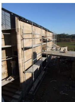
120: Parede nova de alvenaria aparelhada
