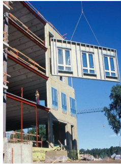
31. Instalação de painéis pré-fabricados (Veljkovic & Johansson 2006)
