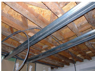
110: Reforço dos pavimentos de madeira
