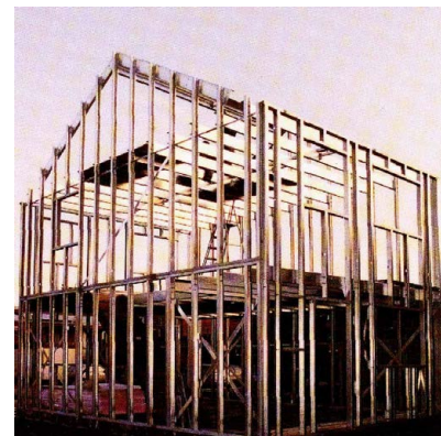
35: Construção por elementos com "balloon system" (Trebilcock 1994)
