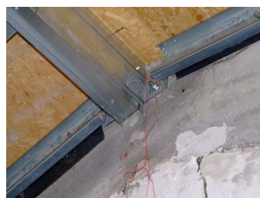
95: Ancoragem da viga de cumeeira
