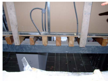
109: Apoio de vigas de pavimento de madeira
