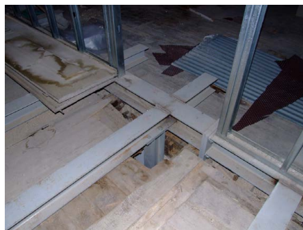
84: Estrutura de laje composta por vigas HEB160 no piso 3
