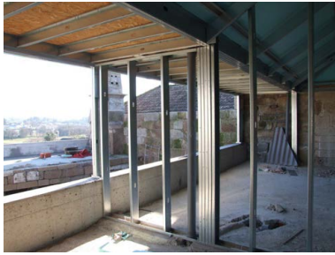
123: Viga para apoio da cobertura paralela à fachada tardez
