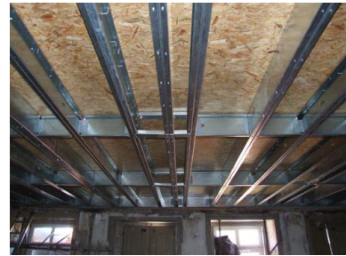
100: Estrutura de pavimento do piso do sótão observado pelo piso 3
