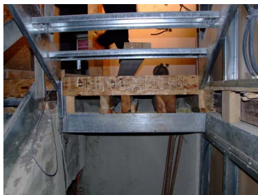
108: Apoio de vigas de pavimento de madeira
