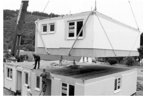
32. Construção modular em Alho, Alemanha (Lawson et al. 1999)
