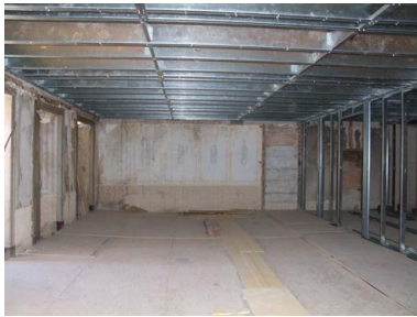
98: Zona junto à fachada principal no piso 3
