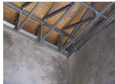
128: Pormenor da fixação da cobertura
