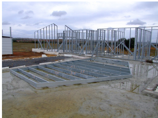
43: Exemplo de execução de parede em obra, Beja
