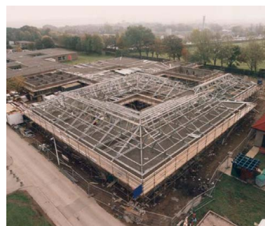
38: Sobreposição de cobertura "over-roofing"
