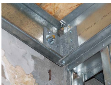
94: Ancoragem complementar à parede de alvenaria
