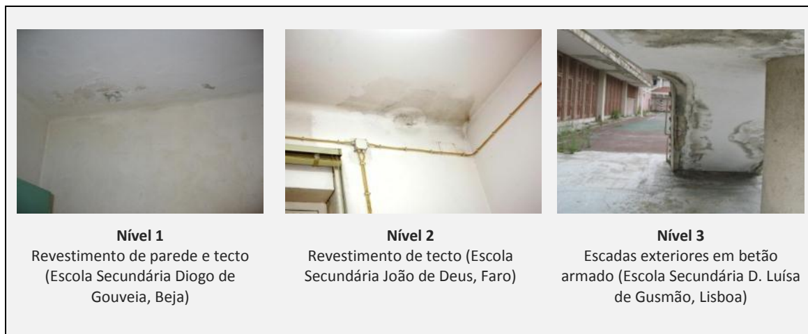
Figura 4.3 - Comparação visual de gravidades das anomalias A3 - Descoloração ou mancha.
