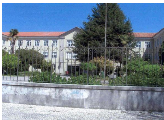
Figura 3.13 - Imagem da fachada principal do antigo Liceu Nacional de Aveiro.
