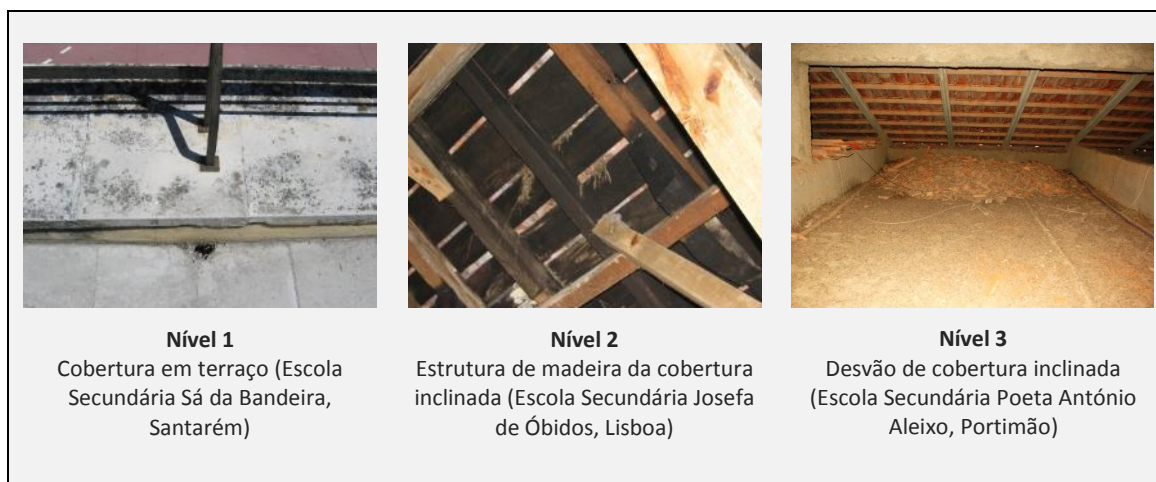
Figura 4.23 - Comparação visual de gravidades das anomalias A28 - Detritos.
