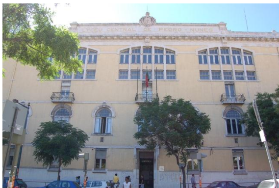
Figura 3.26 - Vista da fachada principal do Liceu Pedro Nunes, a partir da Avenida Álvares Cabral, em Lisboa. Fonte: ICIST
