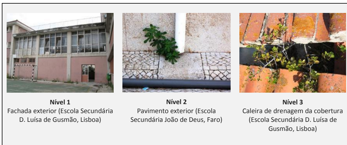
Figura 4.21 - Comparação visual de gravidades das anomalias A24 - Vegetação parasitária.
