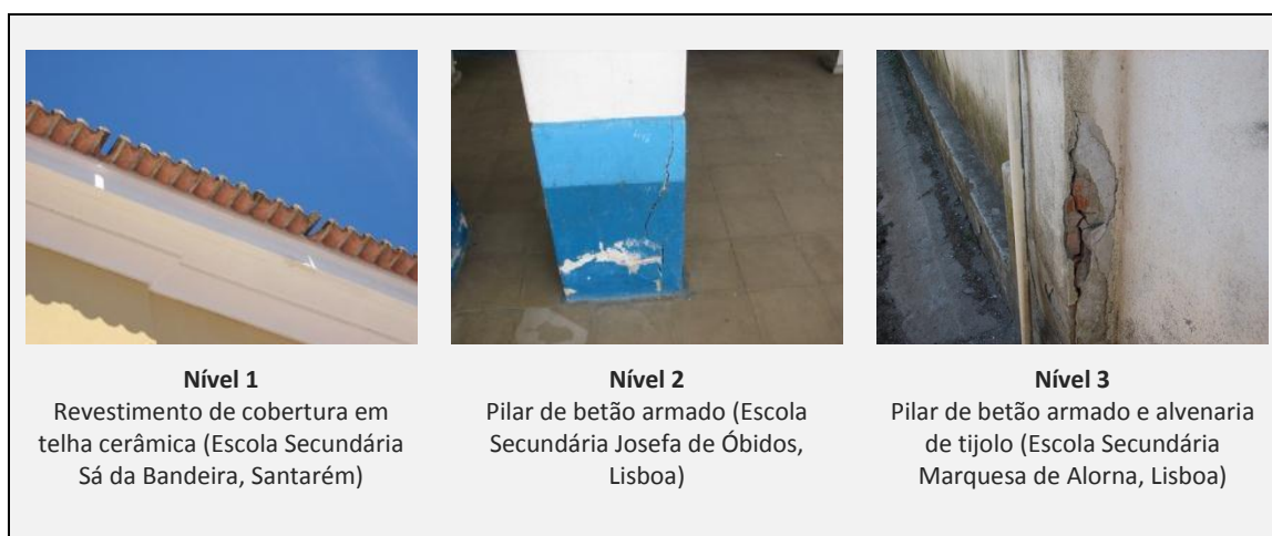
Figura 4.6 - Comparação visual de gravidades das anomalias A7 - Fractura e/ou elemento(s) partido(s).
