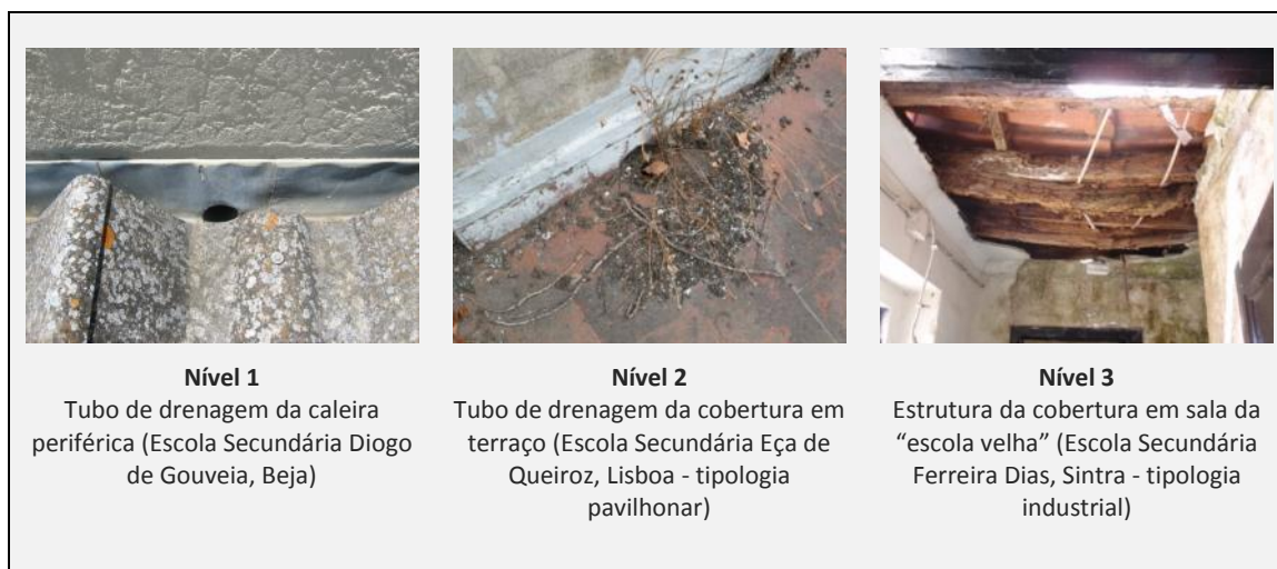
Figura 4.18 - Comparação visual de gravidades das anomalias A20 - Sem funcionamento.
