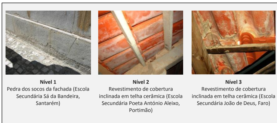
Figura 4.15 - Comparação visual de gravidades das anomalias A18 - Desgaste uniforme.
