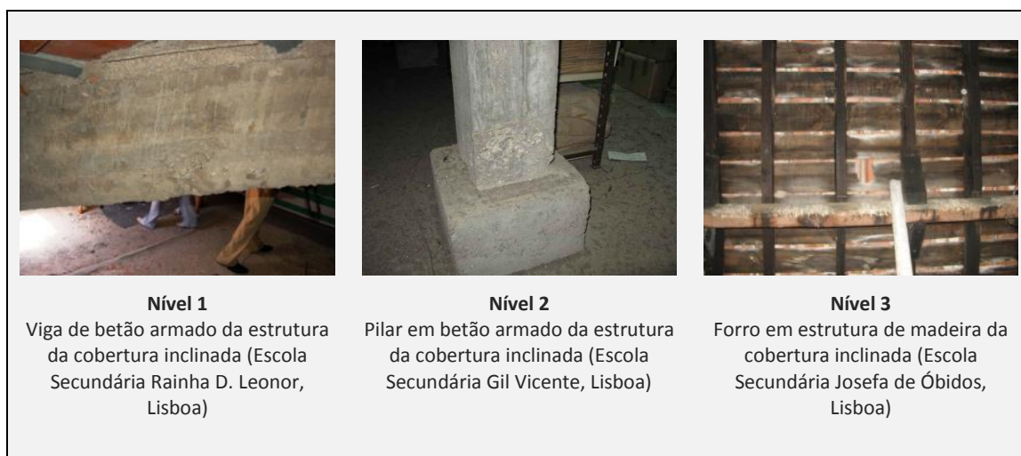
Figura 4.9 - Comparação visual de gravidades das anomalias A10 - Lacuna em profundidade.
