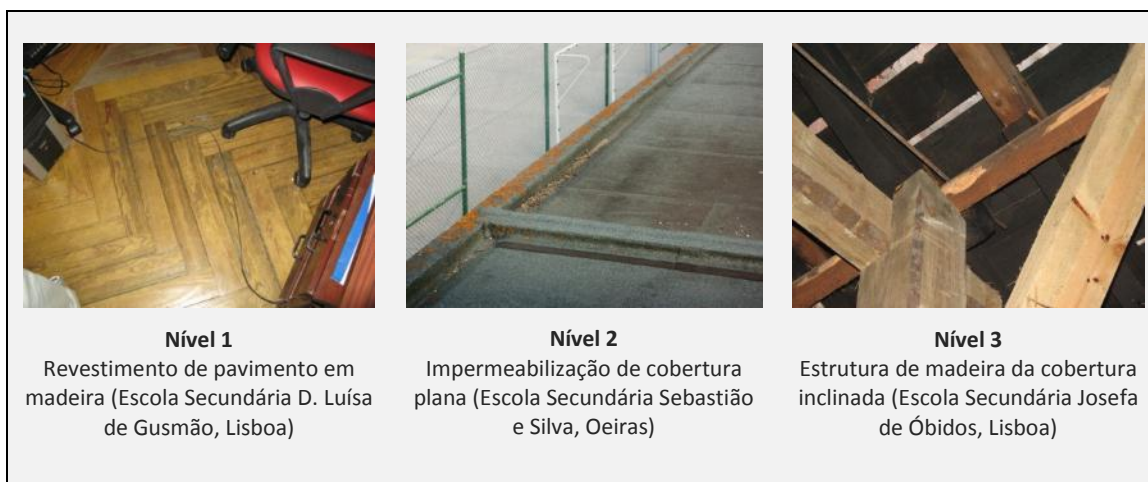
Figura 4.20 - Comparação visual de gravidades das anomalias A23 - Colonização e/ou ataque biológico.
