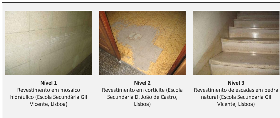
Figura 4.14 - Comparação visual de gravidades das anomalias A17 - Desgaste localizado.
