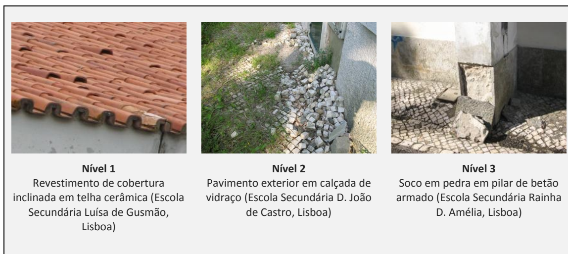
Figura 4.12 - Comparação visual de gravidades das anomalias A14 - Elemento(s) solto(s).
