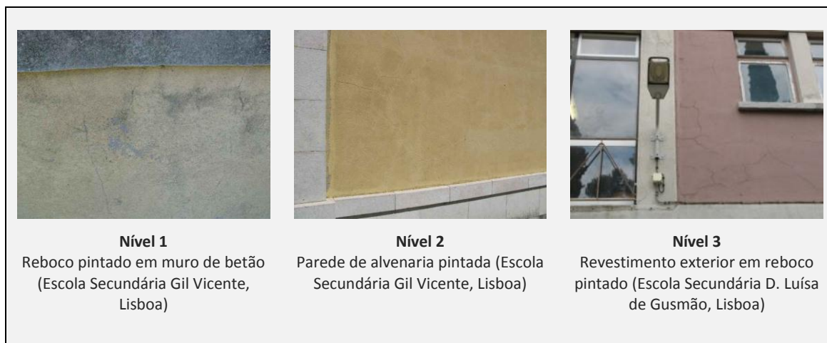
Figura 4.4 - Comparação visual de gravidades das anomalias A4 - Fissuração mapeada.
