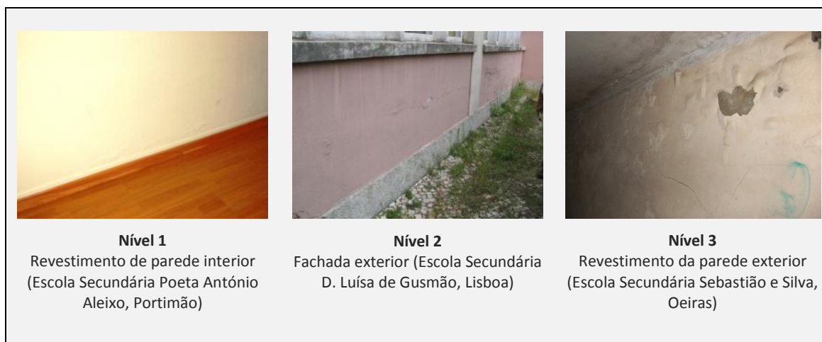
Figura 4.26 - Comparação visual de gravidades das anomalias A31 - Empolamento.
