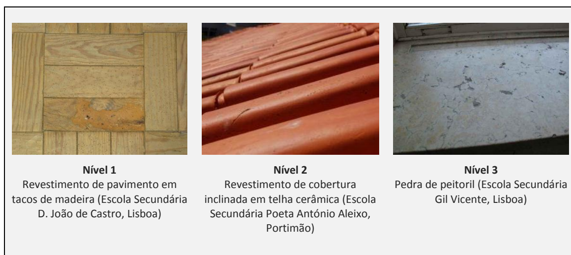
Figura 4.8 - Comparação visual de gravidades das anomalias A9 - Alveolização e/ou picadura.
