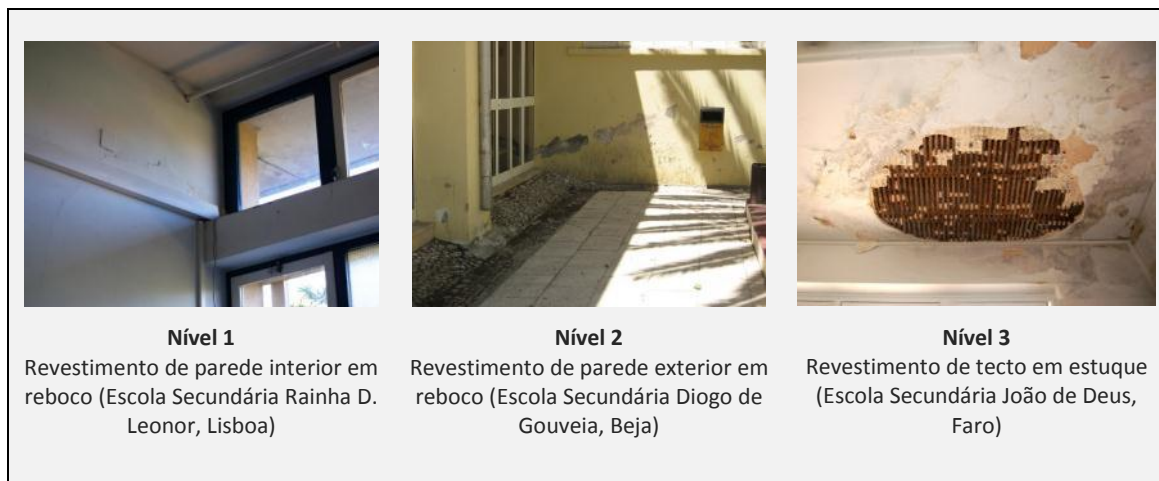
Figura 4.7 - Comparação visual de gravidades das anomalias A8 - Descasque e/ou escamação.
