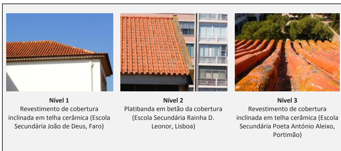
Figura 4.2 - Comparação visual de gravidades das anomalias A2 - Sujidade uniforme.
