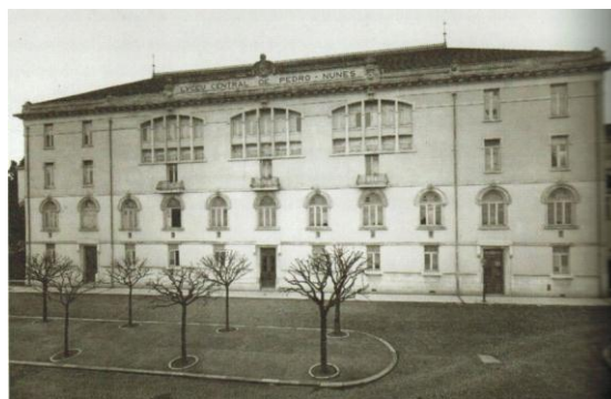
Figura 3.15 - Fachada principal do Liceu Pedro Nunes, em Lisboa.
