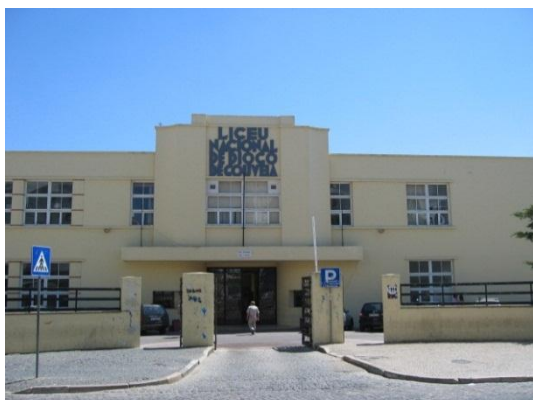
Figura 3.16 - Imagem da fachada principal do Liceu de Beja. Fonte: ICIST
