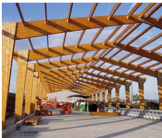
Figura 22 - Pavilhão para autoclave, em Oliveira de Frades [26]
