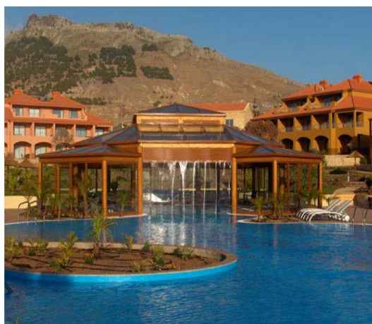
Figura 23 - Estruturas de apoio à piscina, em Porto Santo [26]
