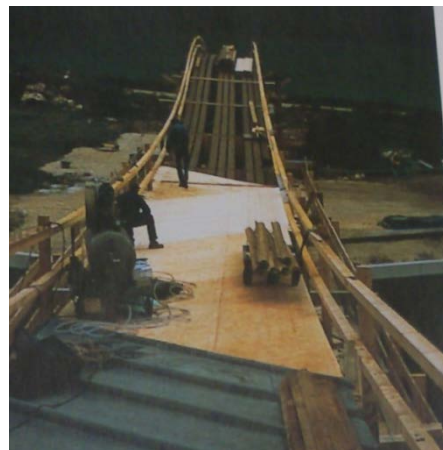
Figura 5 - Pormenor na construção do tabuleiro
