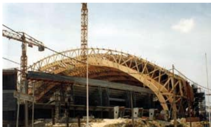
Figura 7 - Construção do Pavilhão Atlântico [3]
