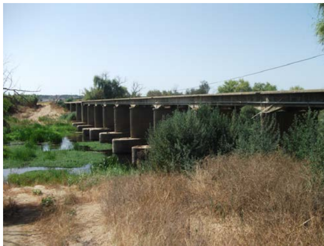
Figura 60 – Ponte Joaquim Casanova do Bêco
