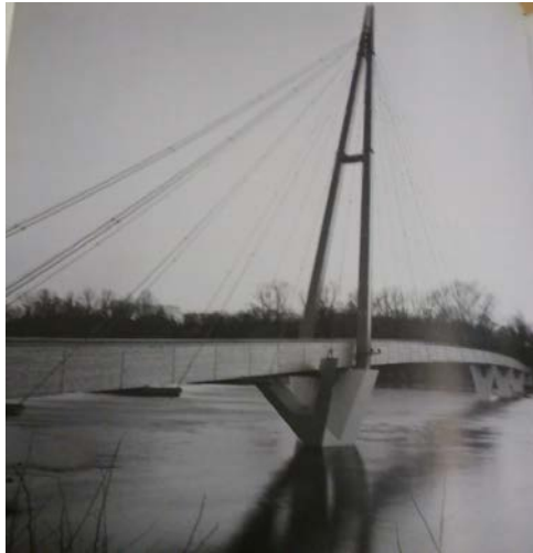
Figura 6 - Ponte suspensa sobre o rio Elba com camada de “sacrifício” [1]
