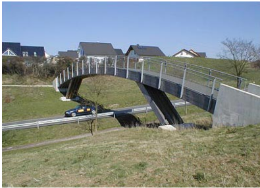
Figura 25 – Passagem para peões em Simmern, Alemanha [27]
