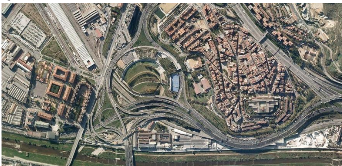
Fig. 02.03 | Vista Aérea do Nó Viário de Trinitat
