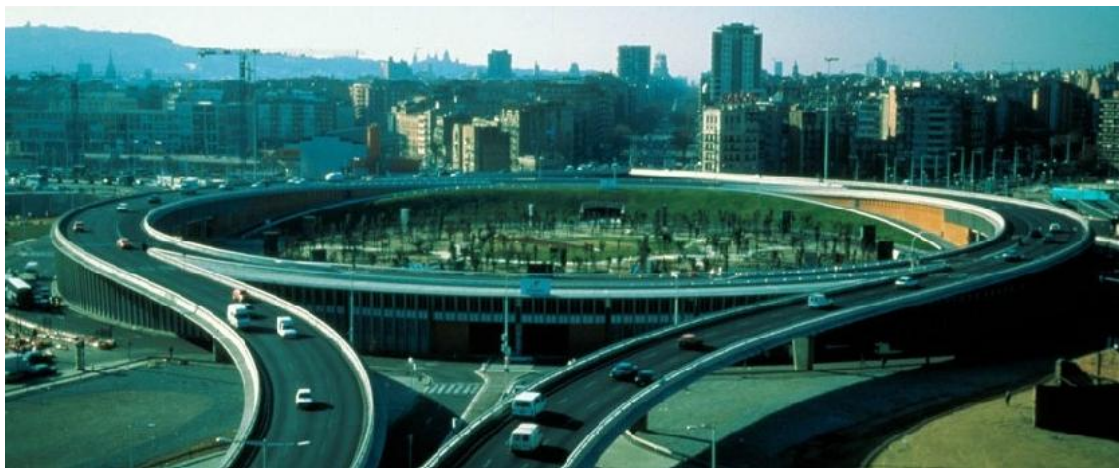
Fig. 02.04 | Fotografia da Plaça de les Glòries Catalanes
