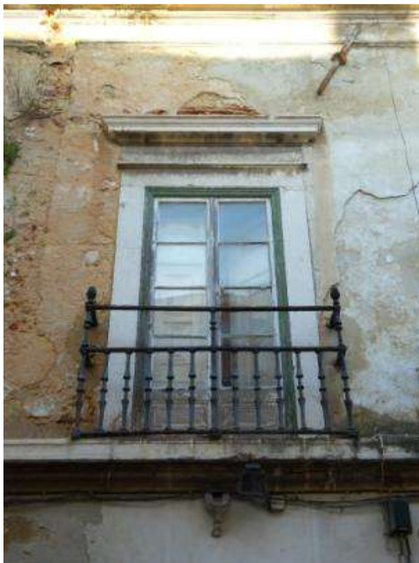
Figura 32: Ampliação de uma das onze janelas de sacada do andar nobre. Neste exemplo são visíveis vários pormenores interessantes: as pinhas metálicas a decorar a guarda, e a goteira decorada com um pequeno arabesco, elementos já desaparecidos da maior parte das janelas; e o friso com os rebordos em relevo. Fonte: fotografia do autor.
