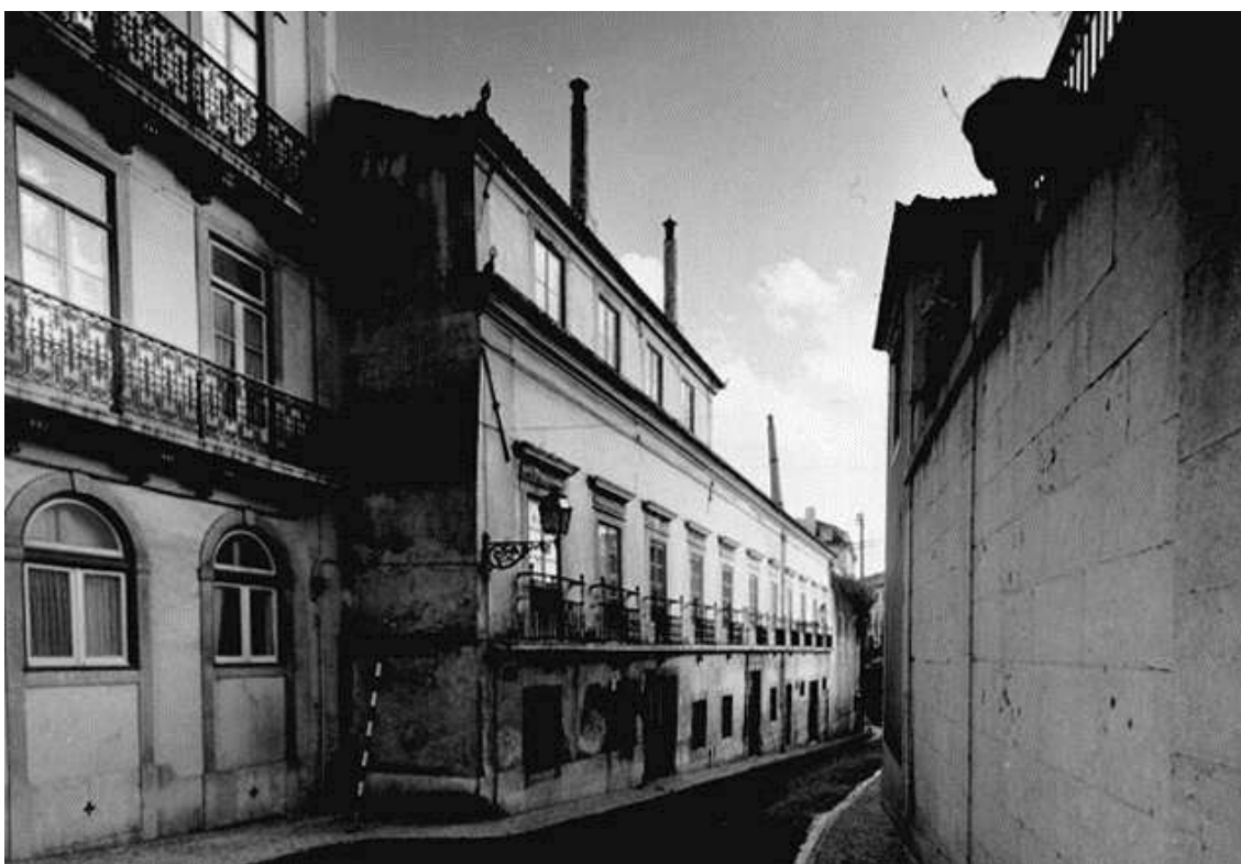
Figura 31: Fotografia do Palácio visto de norte.
