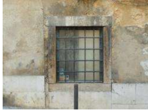
Figura 39: Vão de janela. Ponto 6 da figura 33. Vão de janela provavelmente acrescentado no final do século XIX. Apresenta uma espessura de cantaria de cerca de 16 centímetros. Fonte: fotografia do autor.
