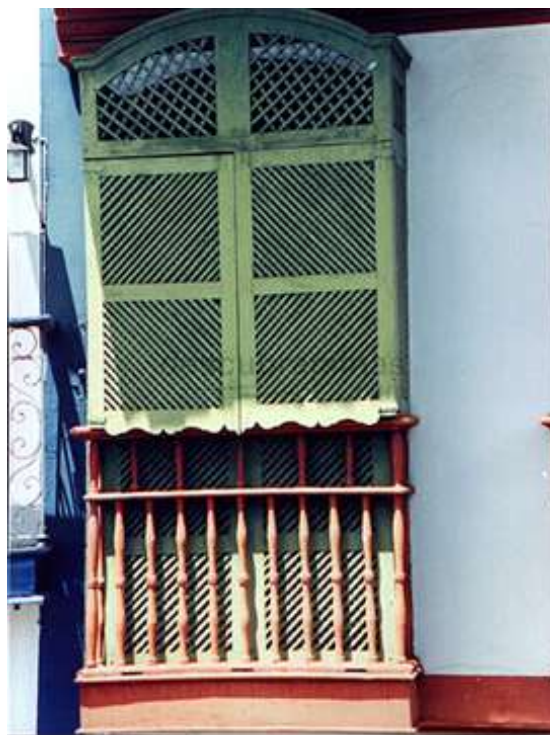
Figura 13: Exemplo de gelsias numa janela de sacada. Gelsias numa das janelas de sacada da Casa do Muxarabi , actual Biblioteca António Torres, na cidade de Diamantina, Estado de Minas Gerais, Brasil. Fonte: http://www.descubraminas.com.br
