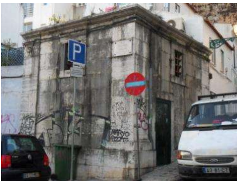
Figura 22: “Casa” de acesso à galeria que abastece o Chafariz da Rua de “O Século”.
