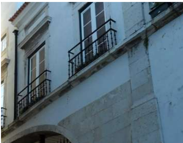
Figura 16: Exemplo de um friso ao nível do pavimento do andar nobre. Este exemplo, retirado do Palácio de Santo Estêvão, é composto por uma consola contínua com rebordos salientes na face. Sob esta consola ainda é visível uma cornija muito simplificada. Fonte: fotografia do autor.
