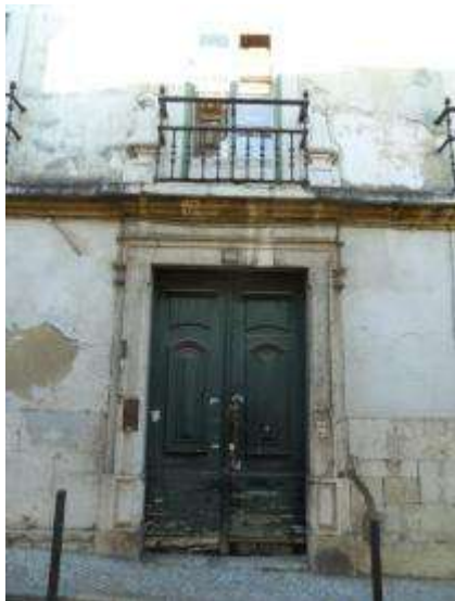
Figura 36: Portal nobre. Ponto 3 da figura 33.
