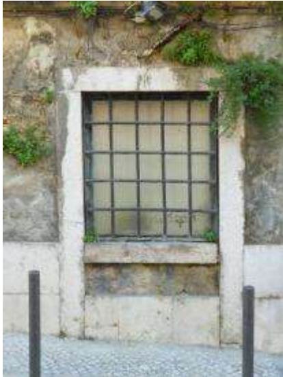
Figura 38: Vão de janela/porta. Ponto 5 da figura 33. Actualmente uma janela, este vão foi, obviamente, uma porta. Fonte: fotografia do autor.
