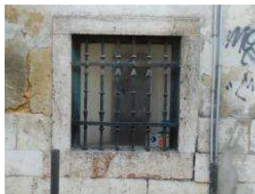
Figura 37: Vão de janela. Ponto 4 da figura 33.
