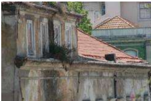
Figura 42: Terceiro Piso. Ponto 9 da figura 33. Terceiro piso acrescentado na fachada principal. Fonte: PPST arquitetura, Lda.
