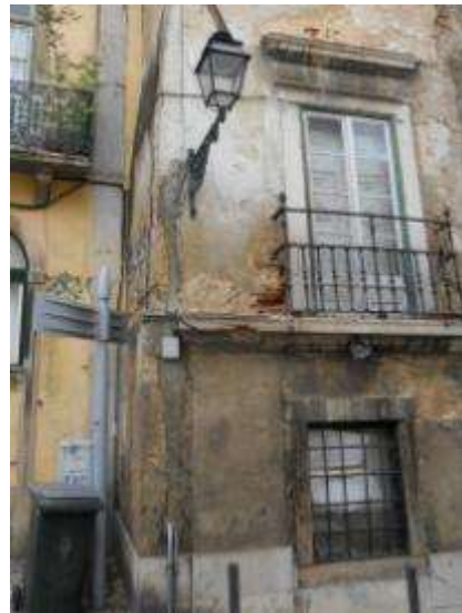
Figura 41: Pilastra no extremo norte. Ponto 8 da figura 33. Pilastra já referida anteriormente que procura reequilibrar esteticamente a simetria da fachada, devido à ausência do cunhal original. Fonte: fotografia do autor.
