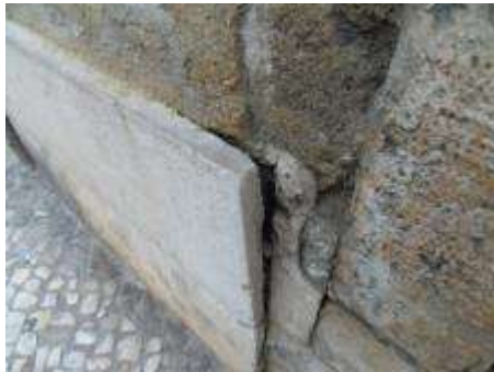
Figura 40: Capeamento do basamento. Ponto 7 da figura 33. Neste extremo do Palácio o basamento original, já desaparecido, aparece substituído por uma pedra de capeamento de dois centímetros de espessura. Fonte: fotografia do autor.
