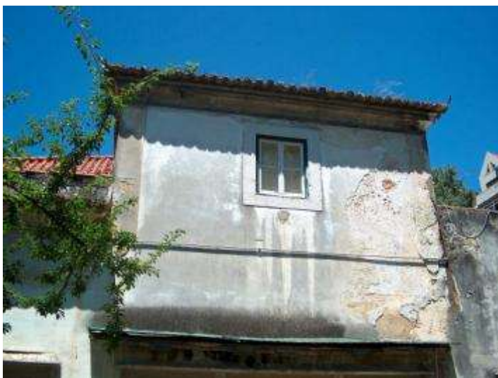
Figura 48: Janela do “quarto das raparigas” vista do jardim. O notório desgaste da cantaria e os 22 centímetros de espessura, apontam para uma concepção deste volume contemporânea à concepção do Palácio. A contrastar com este vão estão os capeamentos dos restantes vãos nesta fachada, provavelmente feitos durante a campanha de divisão do Palácio, no final do século XIX. Fonte: PPST arquitectura, Lda.
