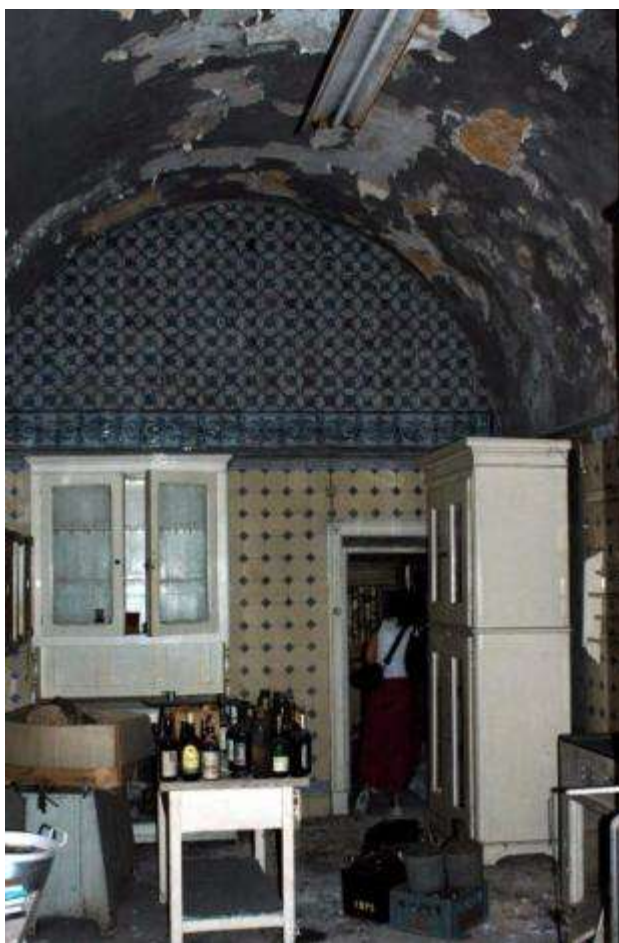
Figura 46: Aspecto geral da cozinha original. Na fotografia é visível o tecto em abóbada de berço, bem como o revestimento azulejar. Fonte: PPST arquitectura, Lda.
