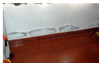
Figura 4.95: Nível 3 de empolamento (A31) de pintura em paramento interior (Escola Secundária de Sebastião da Gama).
