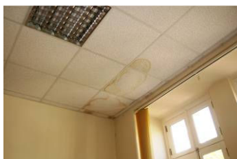
Figura 4.31: Nível 2 de descoloração ou mancha (A3) em revestimento de teto (Escola Secundária Tomás Cabreira).
