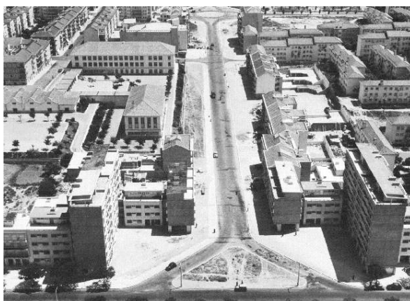
Figura 3.2: Fotografia aérea do cruzamento da Avenida de Roma com a Avenida do Brasil em Lisboa em 1953, em que se vê à esquerda os edifícios principal, do ginásio e das oficinas da escola mais conhecida por Escola Eugénio dos Santos (Oliveira, 1953).
