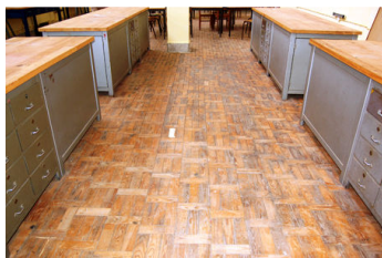
Figura 4.64: Nível 2 de desgaste uniforme (A18) em pavimento em taco de madeira (Escola Secundária Jorge Peixinho).
