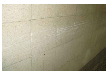
Figura 4.60: Nível 1 de desgaste localizado (A17) em revestimento em mosaico hidráulico (Escola Secundária Gil Vicente 8 ).
