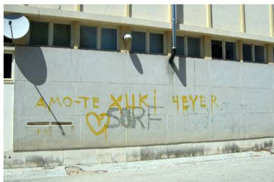
Figura 4.22: Graffiti (A30) sobre revestimento de parede em pedra (Escola Secundária D. Sancho II).
