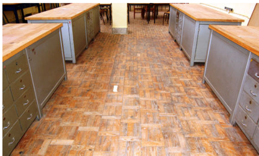
Figura 4.14: Desgaste generalizado (A18) de pavimento em tacos de madeira (Escola Secundária Jorge Peixinho).
