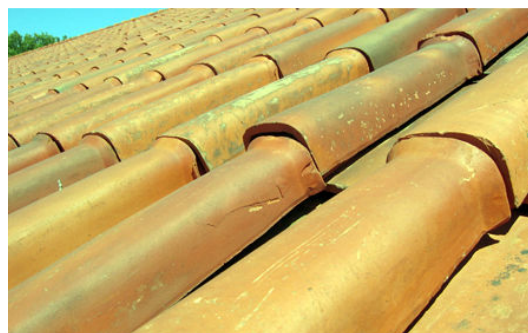
Figura 4.11: Elementos soltos (A14) em revestimento de cobertura em telhas cerâmicas (Escola Secundária Emídio Navarro).
