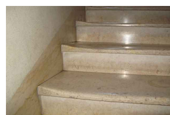
Figura 4.62: Nível 3 de desgaste localizado (A17) em revestimento de escadas em pedra natural (Escola Secundária Gil Vicente 8 ).
