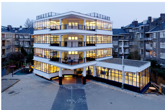
Figura 3.15: Fotografia do edifício da Escola ao Ar Livre em 2011, após o seu último restauro (Elst, 2011).
