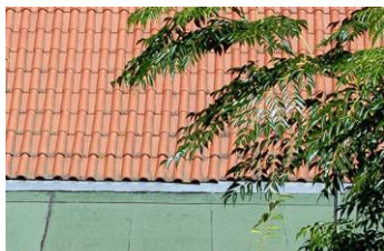
Figura 4.27: Nível 1 de sujidade uniforme (A2) em revestimento de cobertura inclinada em telha cerâmica (Escola Secundária Rainha Santa Isabel).
