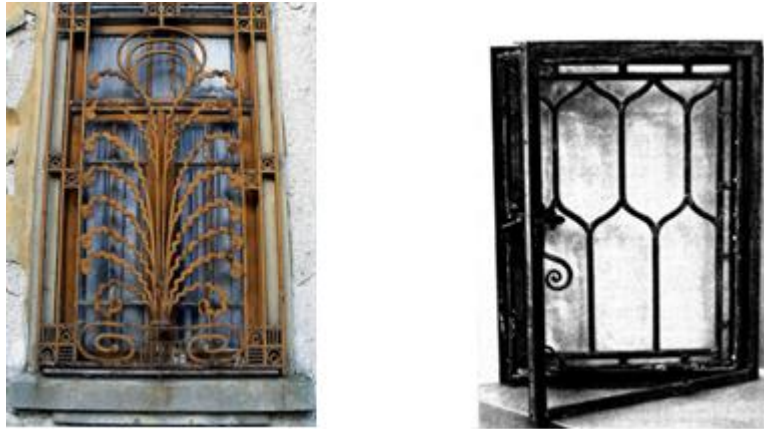
Figura 2.19 - Caixilharia e gradeamento em ferro forjado - Lapa, Portugal (à esquerda) (fotografia gentilmente cedida pelo fotógrafo David Ramalho) e janela de aço (à direita) (Tutton e Hirst, 2007)
