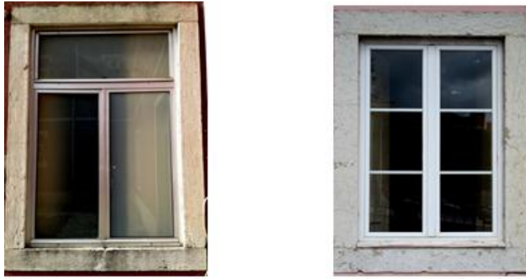
Figura 2.22 - Caixilharia de alumínio anodizado (à esquerda) e caixilharia de alumínio termolacado (à direita)
