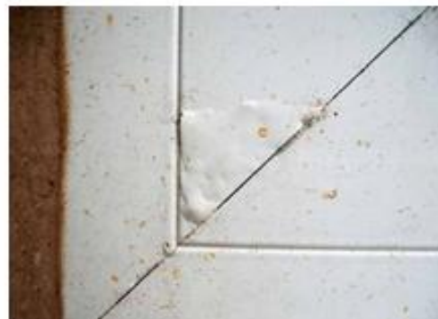
Figura 3.18 - Descamação da pintura - caixilharia de madeira (à esquerda) (Freitas, 2006) e empolamento da lacagem - caixilharia de alumínio (à direita) (Amtec, 2012)
