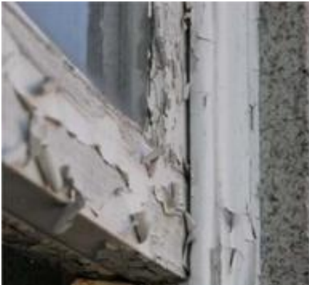
Figura 3.18 - Descamação da pintura - caixilharia de madeira (à esquerda) (Freitas, 2006) e empolamento da lacagem - caixilharia de alumínio (à direita) (Amtec, 2012)
