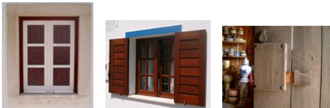
Figura 2.18 - Tipos de revestimentos: janela em madeira pintada (à esquerda), janela e portadas envernizadas (ao centro) e porta tradicional com aplicação de velatura (à direita) (Ferreira, 2004)
