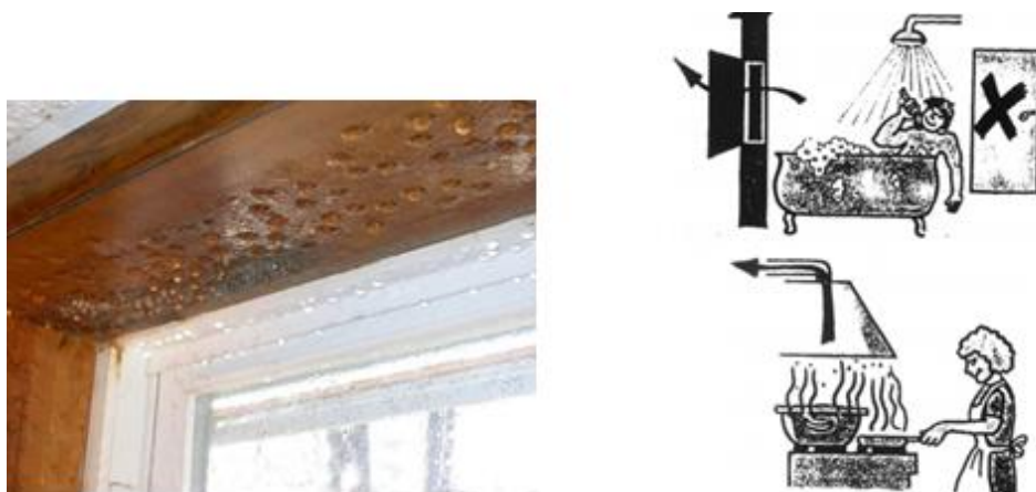
Figura 3.28 - Condensação e consequente humedificação da madeira (à esquerda) (Engenharia Civil, 2012) e principais fontes de vapor de água numa habitação (Velux, 2012)
