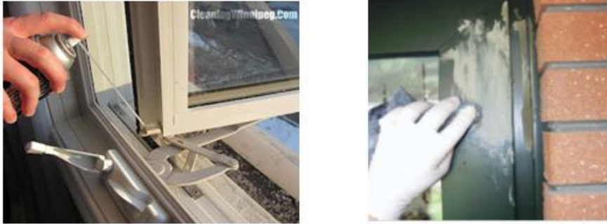
Figura 3.30 - Operações de manutenção: à esquerda, lubrificação dos mecanismos (Cleaning Winnipeg, 2012); à direita, limpeza de restos de cimento em caixilho lacado (nestes casos devem ser utilizados produtos de limpeza recomendados pelos respectivos fabricantes) (Gomes, 2011)
