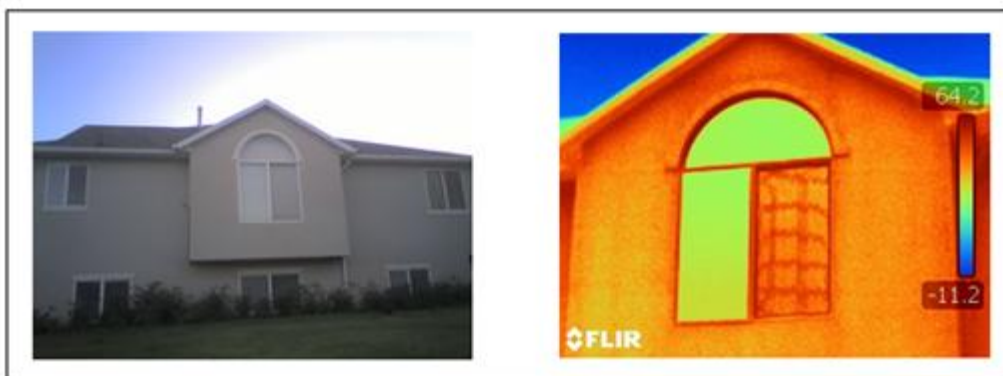
Figura 4.19 - Inspeção a janela recorrendo à termografia de infravermelhos (Utah Infrared, 2012)
