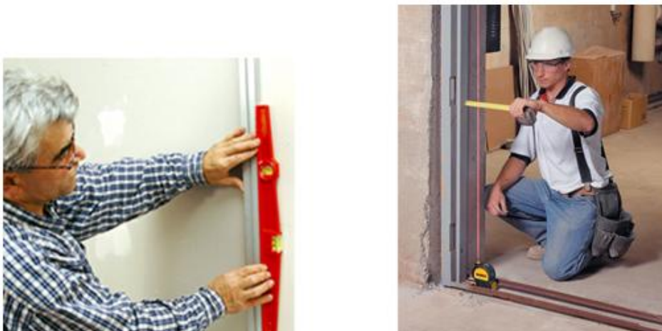
Figura 4.6 - Avaliação de esquadria recorrendo ao nível laser e fita métrica (Teodol, 2012)
