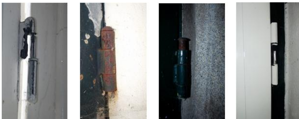
Figura 3.13 - Dobradiças danificadas
