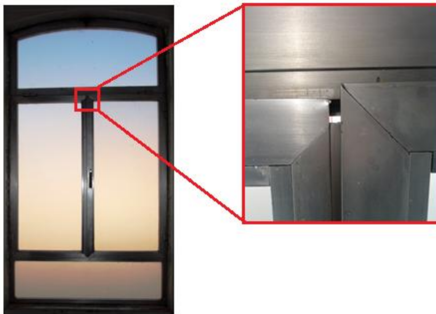
Figura 3.11 - Desnivelamento entre folhas
