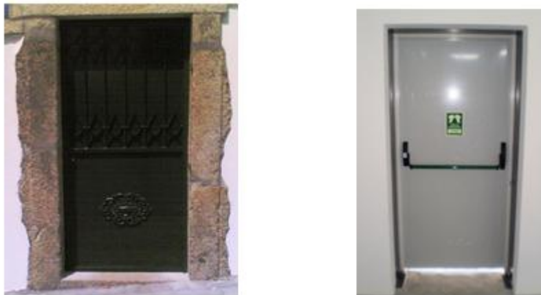
Figura 2.20 - Porta pedonal exterior de aço laminado pintada (à esquerda) e porta corta-fogo, concebida em dupla chapa de aço galvanizado (à direita)
