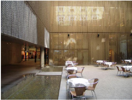
Fig. 3.3.1.8.1. Centro Comercial Funf Hofe – Ventilação natural, circulação de ar entre pátio interior aberto e rua comercial; Munique, Alemanha
