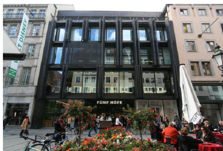
Fig. 3.3.1.7.2. Sombreamento Exterior Ajustável na fachada do Centro Comercial Funf Hofe, Munique, Alemanha
