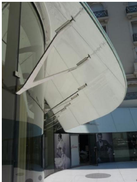
Fig. 3.3.1.7.1. Sistema de sombreamento na área comercial 65 Croisette, Cannes, França
