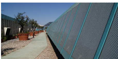
Fig. 4.3.2.4. C.C. Colombo - Cobertura
