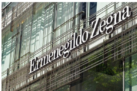
Fig. 3.3.1.7.4. Sombreamento Exterior Fixo na fachada da Loja Ermenegildo Zenga Shinjuku, Tokyo, Japão
