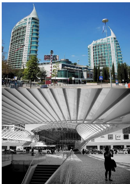
Fig. 3.1.7. Centro Comercial Vasco da Gama, Lisboa exemplo de “uso misto”, edifício comercial e habitação junto a interface de transportes públicos.
