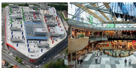
Fig. 3.3.1.7.6. Villach Atrio Shopping Center (vista aérea e praça central) Painéis Fotovoltaicos cobrem e sombreiam a cobertura envidraçada da praça central do Centro Comercial, Carinthia, Austria
