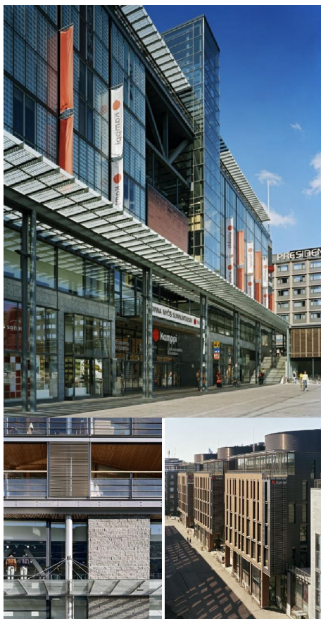
Fig. 3.3.1.12.1. Kamppi Shopping Center , Helsinquia, Finlândia; O edifício assume diferentes fachadas de acordo com a orientação geográfica. A Sul os envidraçados maximizam os ganhos solares no Inverno e o sombreamento horizontal garante protecção na estação quente.
