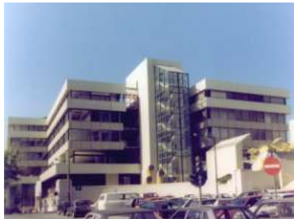
Figura 14: Vista Sul do Pavilhão Fonte: http://www.pardalmonteiro.com/ISTcivil1.htm
