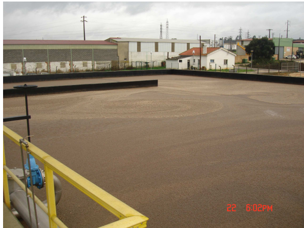
FIGURA VIII: Tanque de Arejamento
