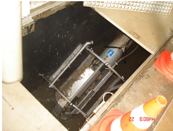
FIGURA VI: Tamisador em funcionamento
