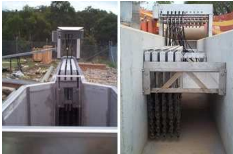
FIGURA XIII: Canal de desinfecção por radiação UV
