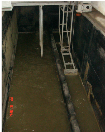
FIGURA VII: Desarenador/Desengordurador
