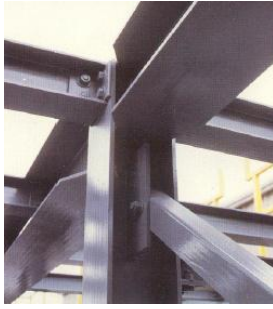
Figura 2.12. Ligação aparafusada entre perfis de GFRP [2.1]
