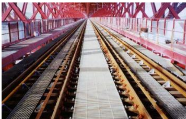
Figura 2.15. Utilização de elementos estruturais de FRP na Ponte 25 de Abril [2.14]
