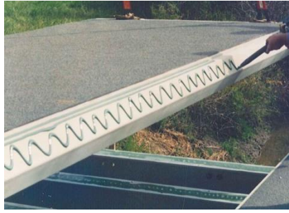
Figura 2.13 Ligação colada (cedida por Creative Pultrusions )
