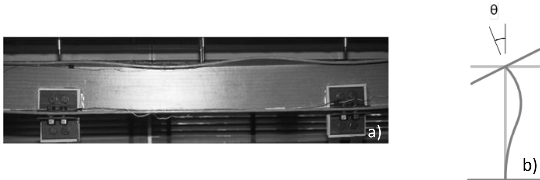
Figura 3.5. (a) Instabilidade local no banzo superior de uma viga de GFRP flectida [3.3] e (b) deslocamentos da secção associados
