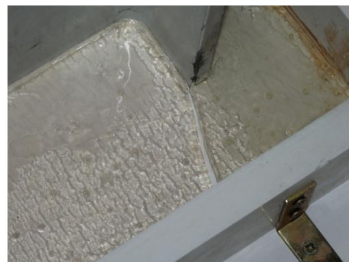
Figura II.2. Fendilhação da primeira camada de resina
