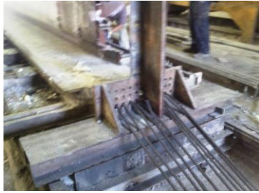
Figura 7.9 – Controlo do alinhamento dos cordões de pré-esforço.
