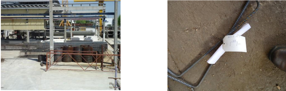
Figura 3.7 – Armazenamento e identificação das armaduras.
