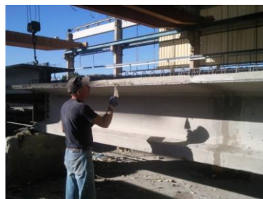
Figura 7.16 – Tratamento de pequenas fracturas na peça.
