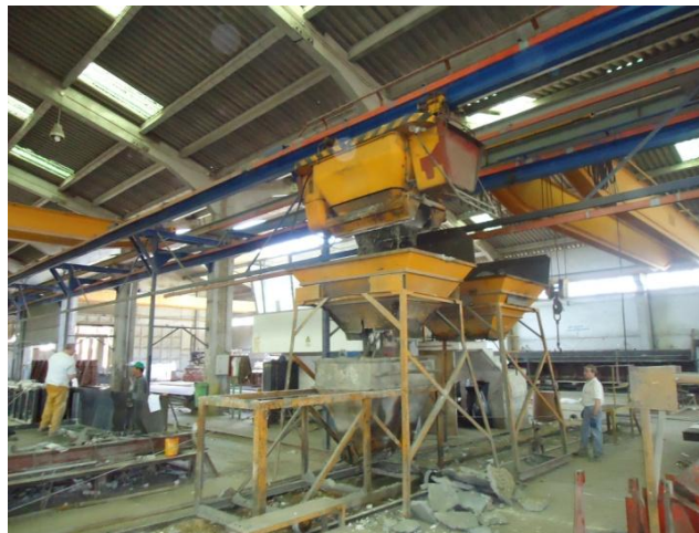
Figura 5.2 – Transporte mecanizado do betão desde a central até ao local de betonagem.
