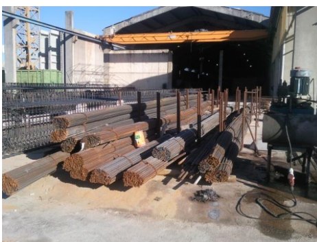
Figura 7.6 – Correcto armazenamento das armaduras passivas.
