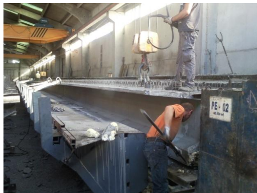
Figura 7.8 – Processo de desmoldagem de uma viga.
