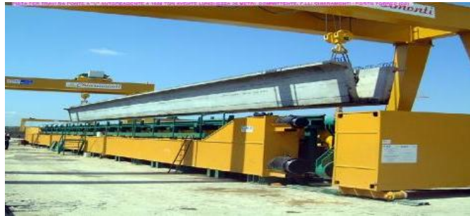
Figura 5.11 – Exemplo de uma viga a ser desmoldada (SOVEPER).
