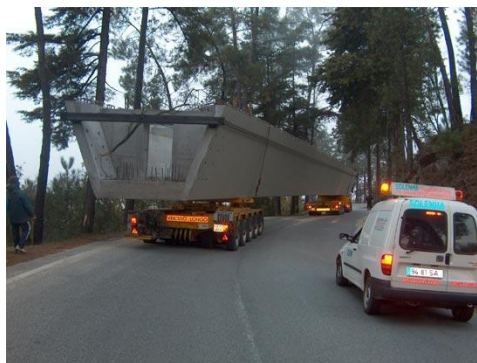
Figura 6.2 – Camião a transportar uma viga pré-fabricada (Solenha, 2005).
