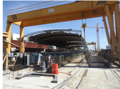
Figura 5.6 – Finalização da preparação da armadura junto ao molde.
