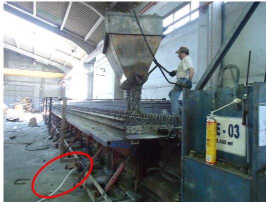
Figura 5.7 – Processo de moldagem de uma viga.
