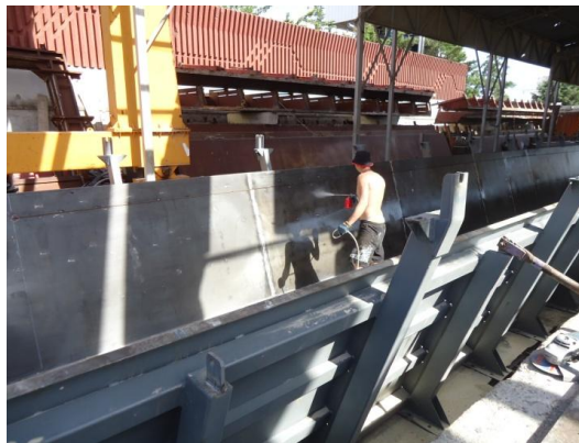
Figura 5.4 – Aplicação do tratamento com óleo descofrante.
