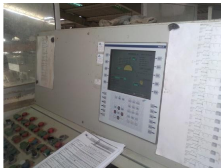
Figura 7.7 – Automatização do processo de fabrico de betão.
