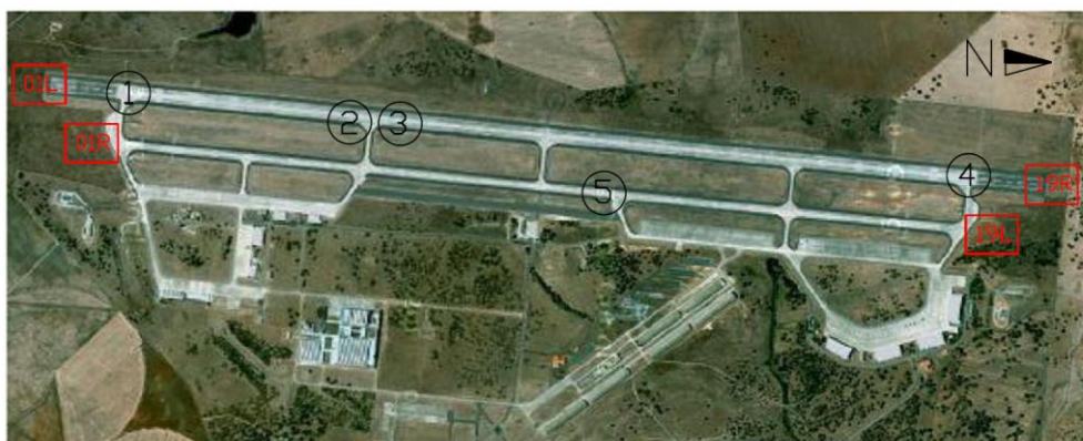
Figura 3.19 - Identificação dos locais da realização de sondagens à rotação com extracção de carotes.
