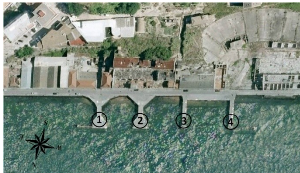
Figura 5.23 – Planta satélite do cais do Ginjal (CA) (Google Earth, 2011 http://earth.google.com/intl/pt/ visitado a 10 de Setembro de 2011).
