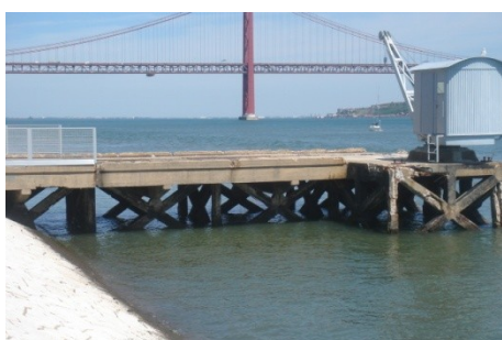
Figura 5.3 – Cais Museu Electricidade (ME).
