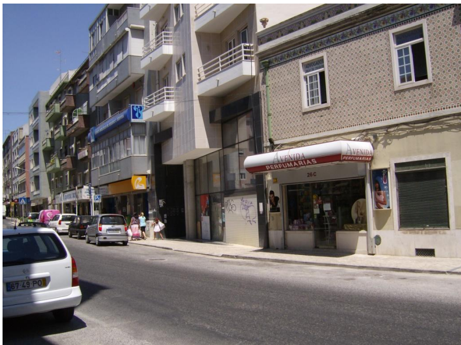
Figura 6 – Terceiro troço da Avenida de Moscavide, imagem recolhida no local no dia 26 de Agosto de 2010
