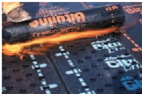
**Figura 3.2** - Ligação a outra membrana de betume através de chama de maçarico, sistema bicapa [w<sub>15</sub>]
