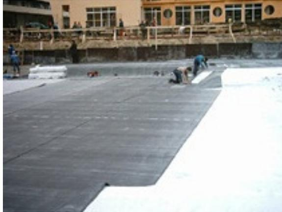
Figura 3.12 - Aplicação da membrana de EPDM num ensoleiramento geral [w<sub>32</sub>]
