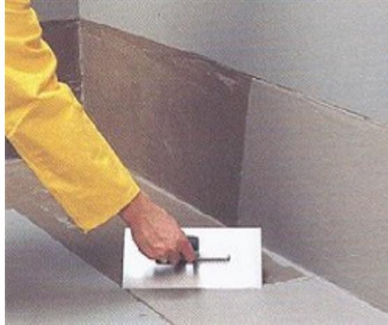
**Figura 3.25** - Aplicação do cimento especial (revestimento de base cimentícia), com talocha [w<sub>40</sub>]
