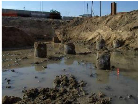
**Figura 2.10** - Encabeçamento da estaca [w<sub>5</sub>]
