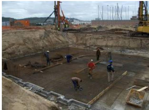
Figura 2.8 - Ensoleiramento geral [w<sub>3</sub>]
