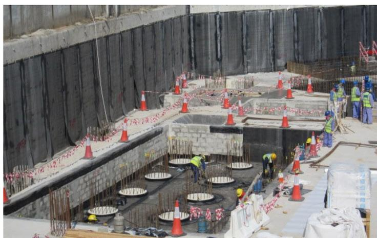
**Figura 4.24** - Maciço de encabeçamento a ser impermeabilizado [w<sub>56</sub>]
