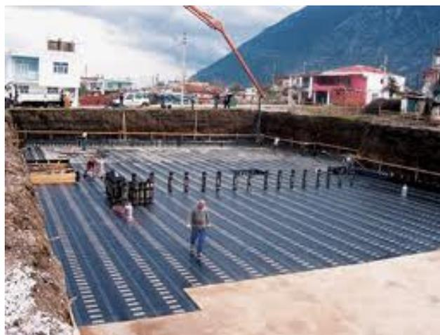
Figura 2.9 - Impermeabilização de ensoleiramento geral [w<sub>4</sub>]
