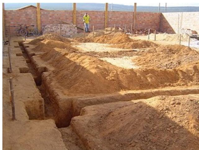
Figura 4.2 - Cabouco para receber fundação directa, sapatas unidas por vigas [w<sub>47</sub>]
