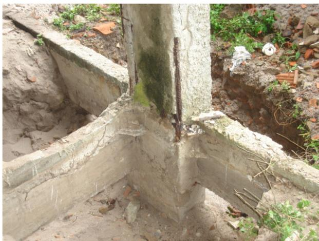
**Figura 5.8** - Corrosão de armaduras de vigas de fundação e do pilar adjacente [w<sub>65</sub>]
