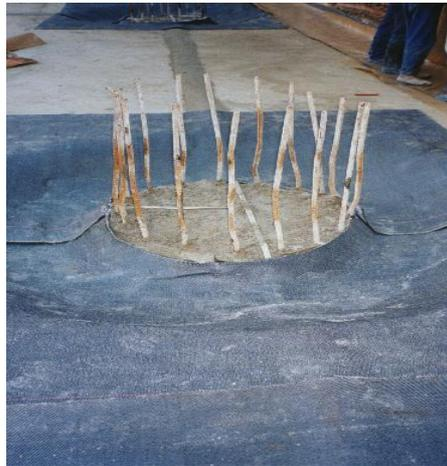
**Figura 2.11** - Impermeabilização do encabeçamento da estaca [w<sub>10</sub>]
