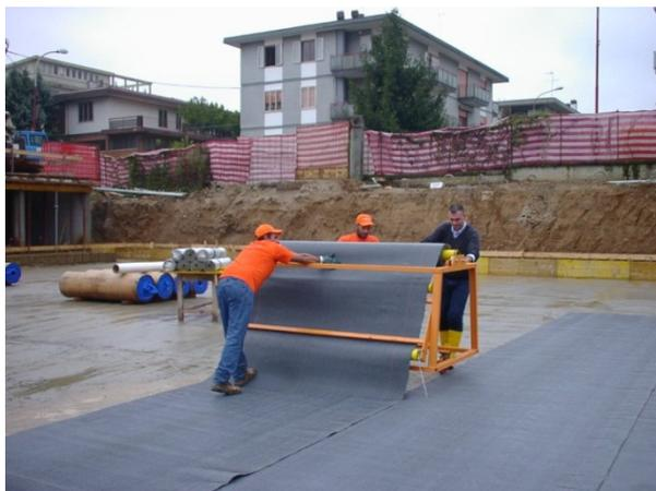
**Figura 4.18** - Aplicação de membrana de EPDM sobre ensaleiramento geral [w<sub>53</sub>]
