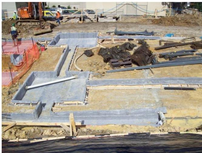
Figura 4.9 - Impermeabilização de fundações do tipo sapata vigada [w<sub>49</sub>]
