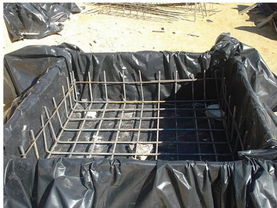
**Figura 2.5 - Impermeabilização da sapata [w<sub>6</sub>]**
