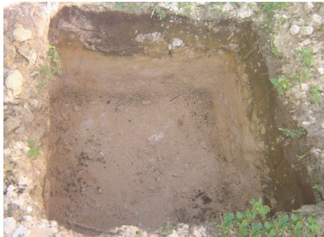
Figura 4.1 - Cabouco para receber fundação directa, sapata isolada [w<sub>46</sub>]
