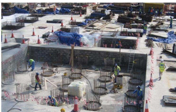
**Figura 4.23** - Maciço de encabeçamento que une as várias estacas [w<sub>56</sub>]
