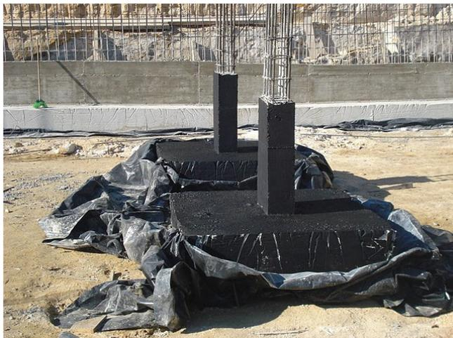
**Figura 4.4** - Sapatas isoladas prefabricadas impermeabilizadas com emulsão betuminosa e membrana [w<sub>48</sub>]
