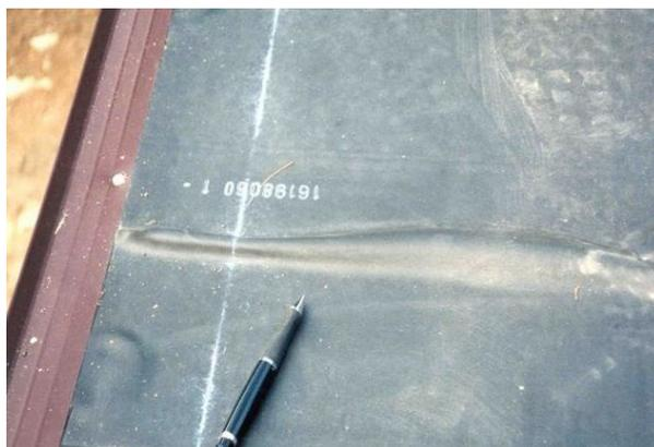
Figura 5.10 - Exemplo de empolamento numa membrana de EPDM [w<sub>66</sub>]
