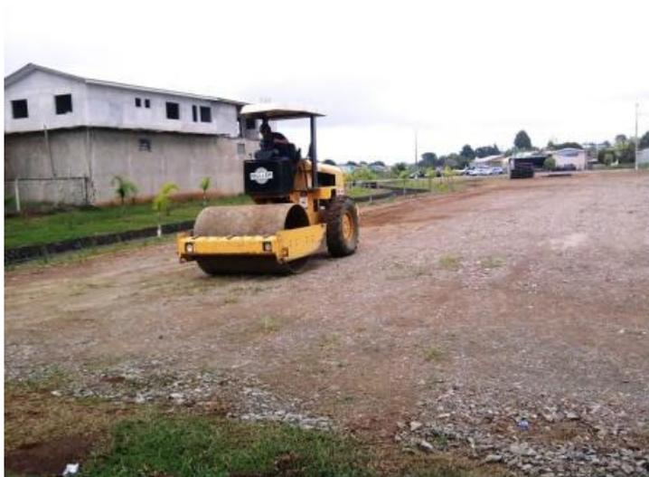
**Figura 4.10** - Compactação do solo com o auxílio do equipamento cilindro [ $w_{50}$ ]
