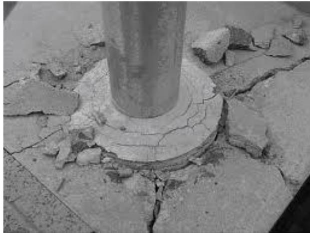
**Figura 5.6** - Pilar danificado devido ao ataque de sulfatos [w<sub>64</sub>]
