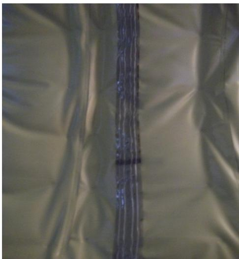
**Figura 3.27** - Junta de dilatação aplicada numa membrana de PVC [arquivo pessoal]
