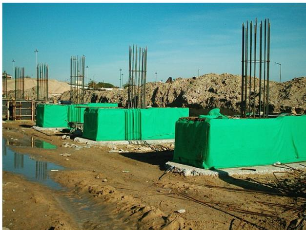
Figura 4.26 - Impermeabilização dos maciços de encabeçamento com o recurso a geocompósitos bentoníticos
