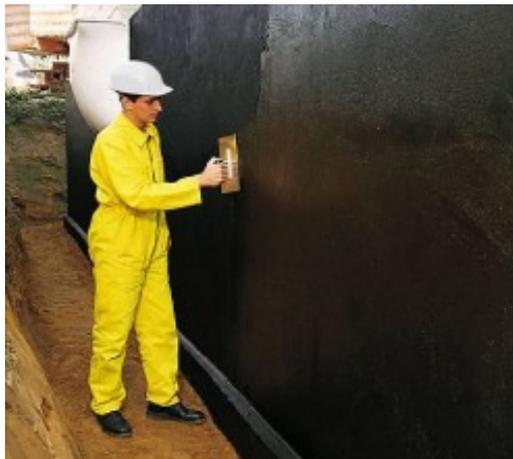
**Figura 3.24** - Aplicação de emulsão betuminosa como primário e elemento de colagem [w<sub>37</sub>]
