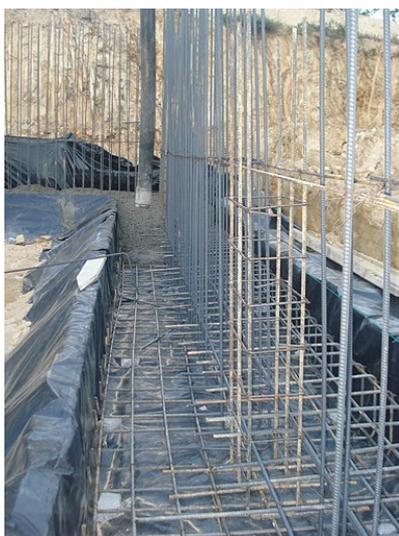
Figura 2.7 - Impermeabilização da sapata corrida [w<sub>6</sub>]
