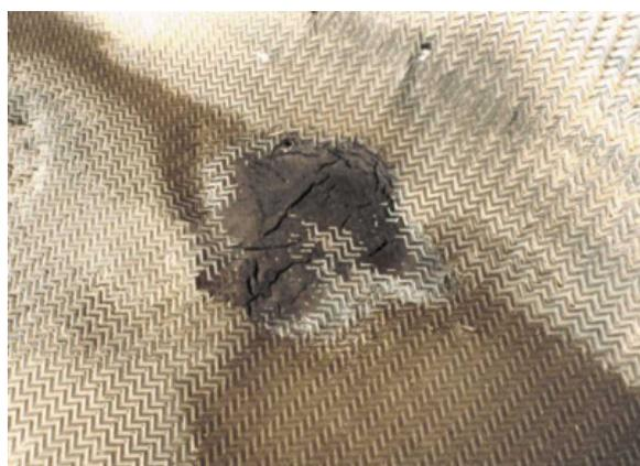
**Figura 5.12** - Fissuração do revestimento de impermeabilização (Walter, 2002)
