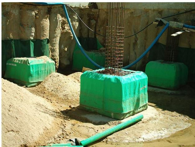
**Figura 4.3** - Sapata impermeabilizada com um geocompósito bentonítico (Acervo pessoal HPedroMartins)
