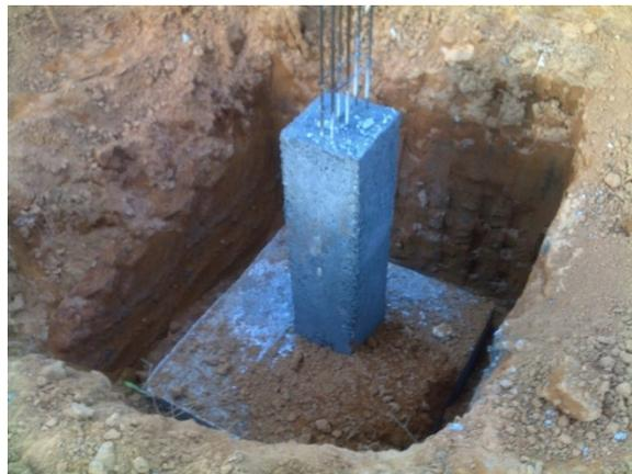
**Figura 2.4 - Sapata isolada [w<sub>2</sub>]**
