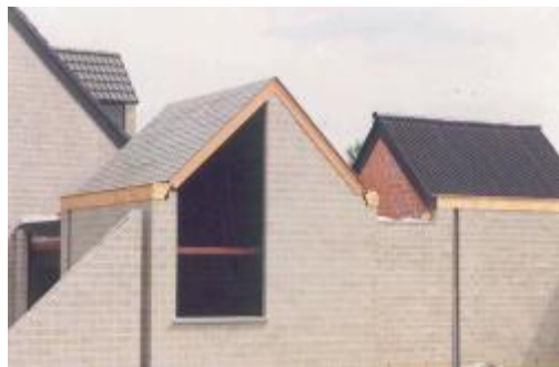
Figura 18 – Telhados dos anexos [29]
