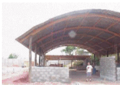
Figura 32 – Cobertura de ecotelhas [37]
