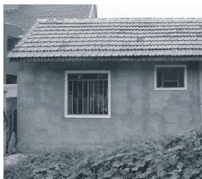
Figura 28 – Casa construída com blocos ISOPET [36]
