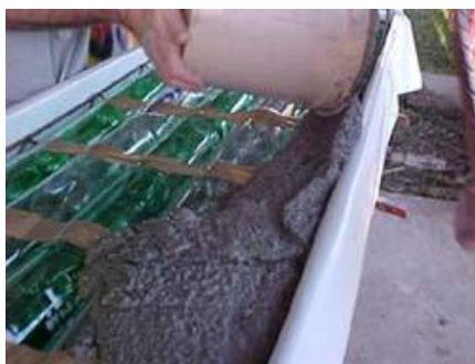
Figura 26 – Execução de ISOPET [35]
