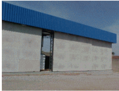
Figura 30 – Armazém com ecoplacas [37]
