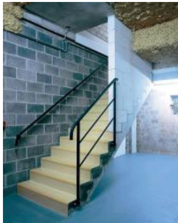
Figura 20 – Vista da cave [29]
