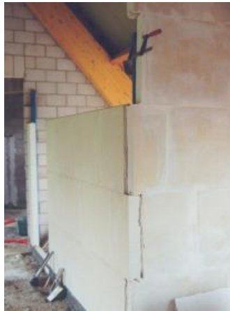
Figura 17 – Divisórias interiores no piso superior [29]
