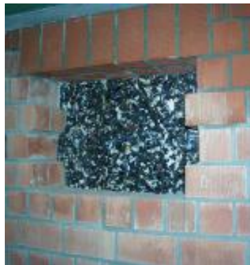
Figura 15 – Vista interior de uma parede da cave [29]
