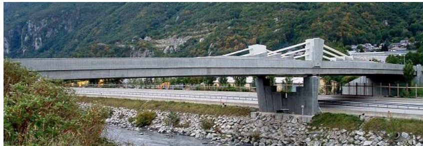
Figura 1.9 – Ponte Saint-Remy-de-Maurienne, França [1.30].
