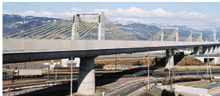
Figura 1.10 – Viaduto Yashiro, Japão [1.34].
