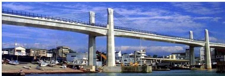
Figura 1.7 – Ponte de Odawara Blueway, Japão [1.14].
