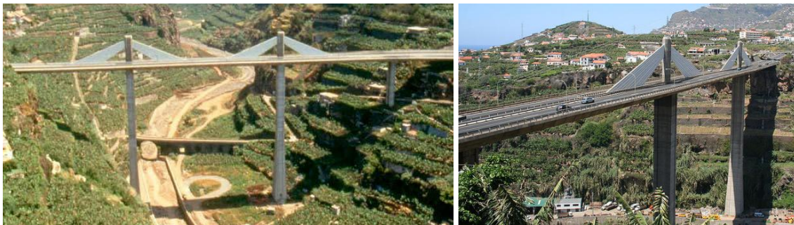
Figura 1.6 – Ponte dos Socorridos, Portugal [1.13,1.14].
