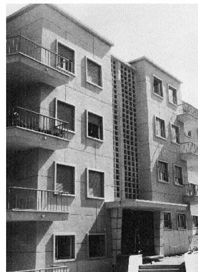
Figura 26 - Avenida D. Rodrigo da Cunha, fotografia de época, 1952
