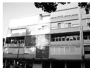
Figura 68 - Caso 07, vista da rua, fotografia actual
