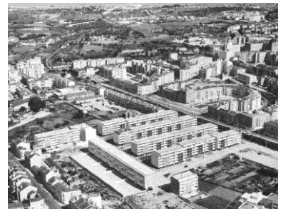
Figura 56 - Bairro das Estacas, fotografia aérea, 1954
