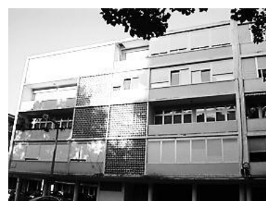
Figura 72 - Caso 09, vista da rua, fotografia actual
