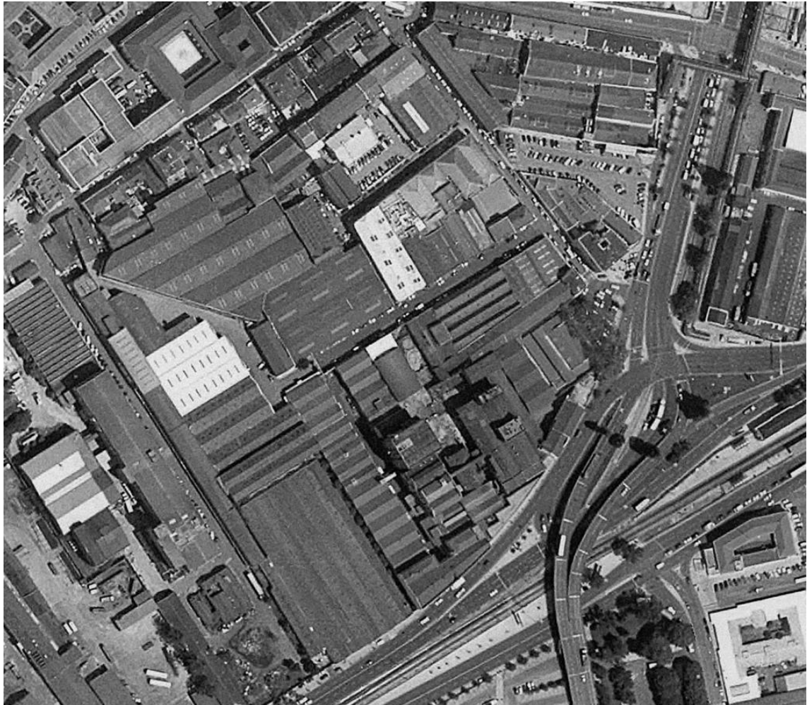
Figura 32 – Fotografia aérea de Alcântara, anterior às demolições (fonte: fotografia disponibilizada pelo ateliê Castanheira & Bassai Arquitectos Associados).
