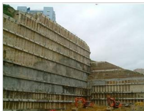
Figura 2.3 – Escavação e contenção periférica da Biblioteca Central e Arquivo Municipal de Lisboa. Taludes revestidos com betão projectado, pregados e drenados, nos alçados de menor altura (Cenga, 2009).
