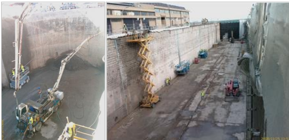
Figura 2.4 – Reparação da Doca Seca do Arsenal do Alfeite 2ª Fase, 2009. Reabilitação das estruturas em betão armado do interior da doca, através da picagem de toda a superfície, substituição e adição de armaduras e projecção de betão C35/45 com fibras de polietileno. (Reproduzida por H Tecnic Lda)
