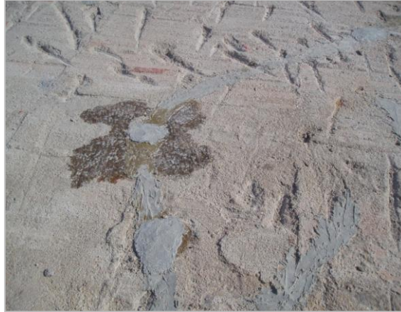
Figura 5.5 – Enchimento de fissuras com resina epóxida.
