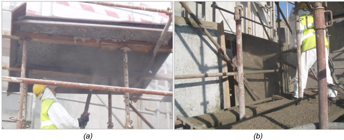
Figura 3.8 – Projecção (a) vertical do betão e (b) projecção horizontal do betão.
