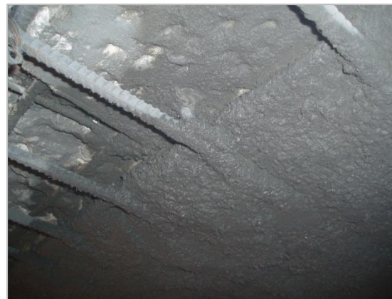
Figura 5.4 – Pormenor da primeira camada de betão aplicado.
