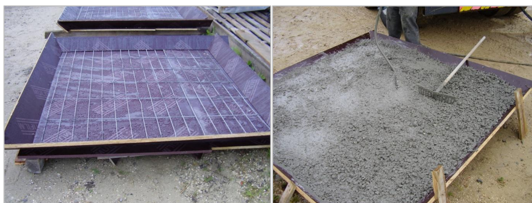
Figura 3.4 – Execução dos painéis de ensaio: (a) colocação de armadura e (b) betonagem.
