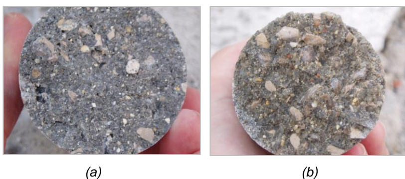
Figura 4.2 – (a) Superfície de rotura com uma boa mistura dos constituintes do betão projectado e (b) superfície de rotura com indícios de ligação insuficiente entre os agregados.
