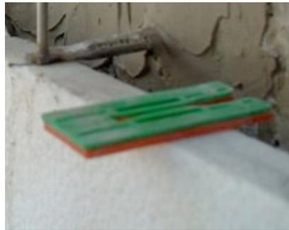
Fig 3.6 - Cunhas de PVC para garantir o espaçamento de 5 mm das juntas
