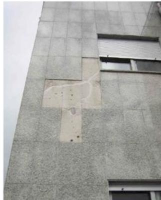
Fig 4.1 - Fachada de um edifício onde é visível o destacamento de várias placas de pedra [14]
