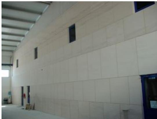
Fig 3.23 - Exemplo de fachada revestida a pedra realizada com estrutura intermédia de suporte
