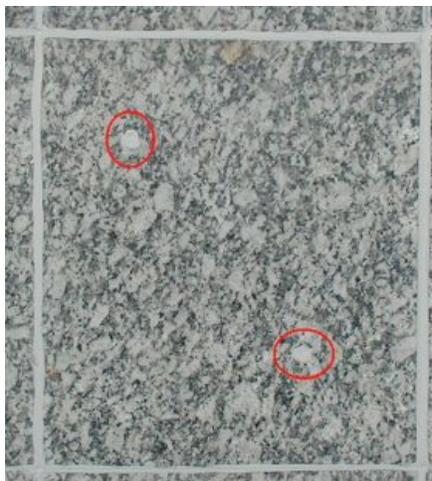
Fig 5.1 - Pormenor da fixação mecânica realizada com parafusos metálicos
