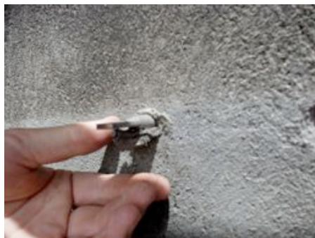
Fig 7.1 - Pormenor dum gato metálico fixo com cunhas de madeira
