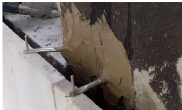
Fig 3.12 - Aspecto final do chumbadouro depois de alisado com uma talocha
