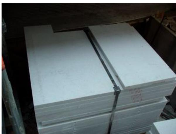
Fig 7.16 - Placas de pedra à chegada à obra, bem acondicionadas e em boas condições
