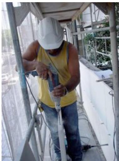
Fig 3.18 - Realização dos furos verticais nas laterais das placas de pedra para os pinos de suporte dos gatos metálicos
