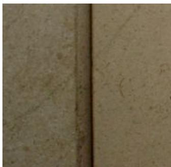
Fig 7.2 - Pormenor da fachada com as juntas entre pedras de tamanho insuficiente
