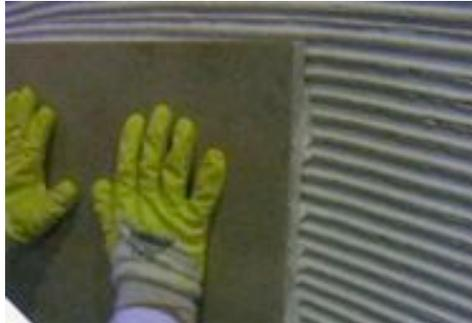
Fig 3.2 - Aplicação de uma placa de pedra sobre o material de assentamento [15]
