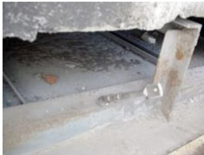
Fig 7.5 - Pormenor do gato metálico soldado à estrutura metálica do edifício
