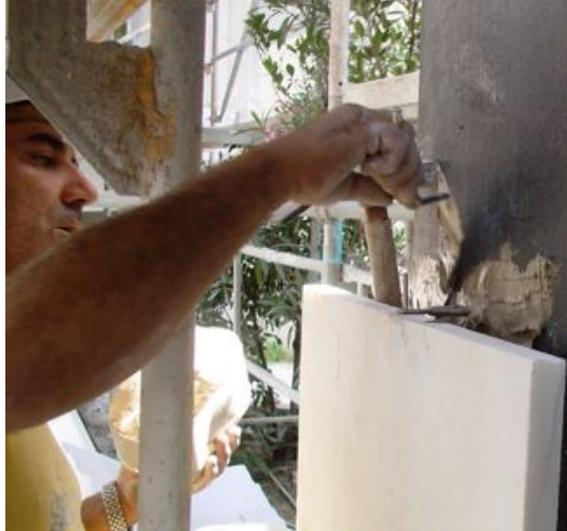
Fig 3.20 - Inserção dos pinos nos gatos superiores da placa de pedra
