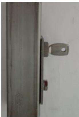
Fig 2.11 - Pormenor de elemento vertical da estrutura intermédia de suporte com o gato para fixar as placas de pedra
