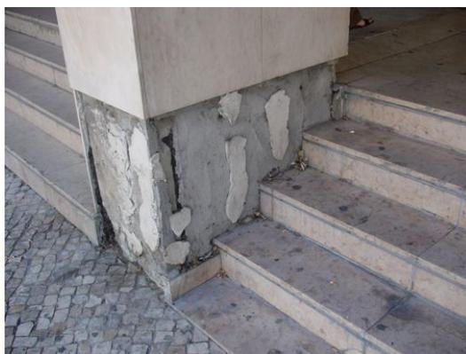
Fig 7.13 – Exemplo de descolamento de placas de pedra originados pela incorrecta aplicação das placas
