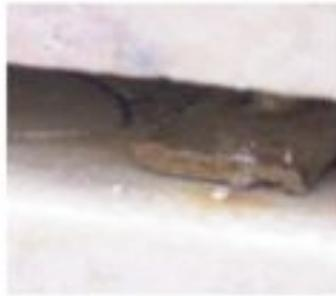
Fig 4.6 – Pormenor de um gato metálico corroído [22]
