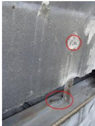
Fig 7.4 - Gatos metálicos (círculos a vermelho) suportando uma mesma pedra fixos a dois tipos de suportes diferentes: alvenaria e estrutura metálica
