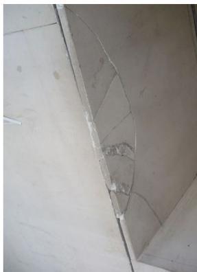
Fig 7.12 - Pormenor de uma placa de pedra fracturada localizada numa zona de passagem
