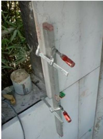
Fig 3.19 - Fixação provisória das placas de pedra antes de colocação dos pinos superiores
