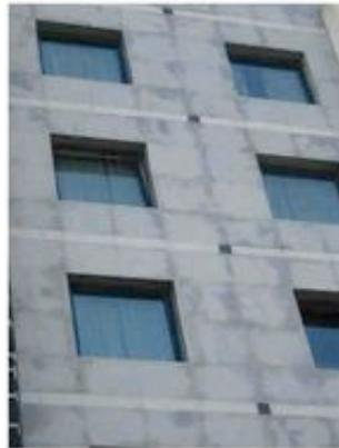
Fig 4.4 - Detalhe de uma fachada de um edifício onde são visíveis manchas nas placas de pedra [14]
