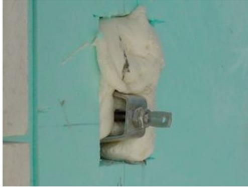
Fig 3.8 - Zona onde o isolamento foi cortado na envolvente do gato metálico de fixação mecânica e preenchido com poliuretano expansível
