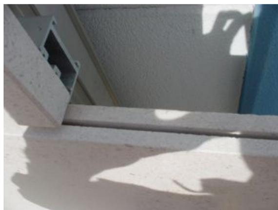
Fig 3.28 - Detalhe da calha efectuada na pedra para colocação do clip de suporte
