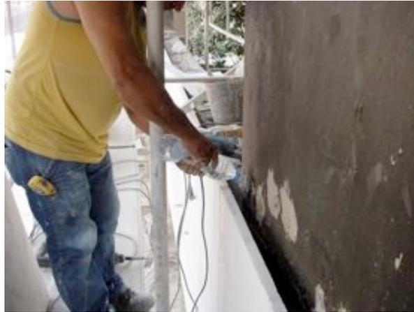
Fig 3.10 - Limpeza e molhagem do furo para o chumbadouro
