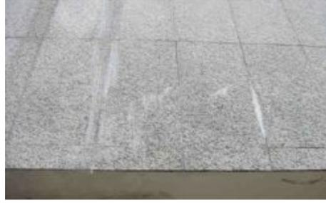
Fig 4.3 - Detalhe de uma fachada de um edifício onde são visíveis eflorescências com maior intensidade nas juntas entre pedras [14]
