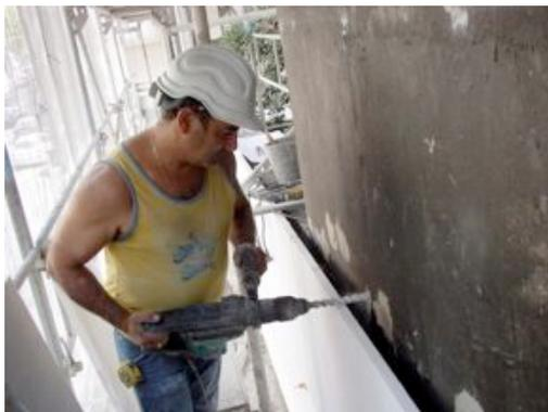
Fig 3.7 - Abertura dos furos para os chumbadouros
