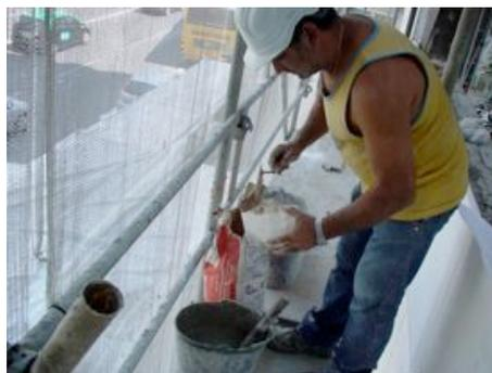
Fig 3.9 - Preparação de pequena quantidade de cimento de secagem rápida para preenchimento dos chumbadouros
