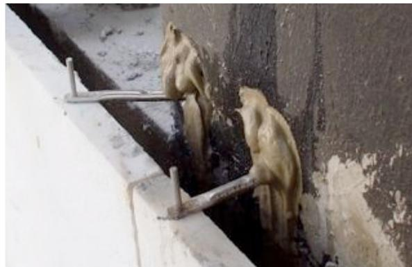
Fig 3.11 - Chumbadouro preenchido com cimento de secagem rápida depois de aplicado
