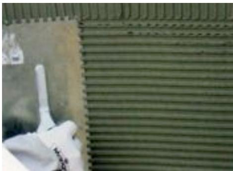
Fig 3.1 – Aplicação do material de assentamento no suporte [15]
