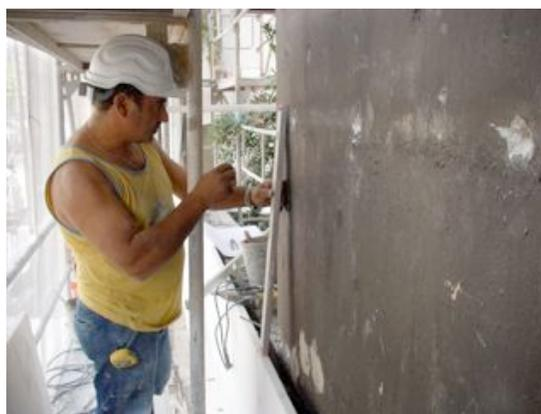
Fig 3.5 - Marcação do local de fixação dos gatos metálicos com um nível e uma fita métrica
