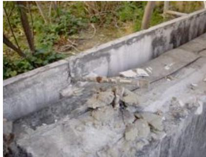
Fig 7.9 - Gatos que suportam as pedras do lado interior e exterior do muro soldados um ao outro
