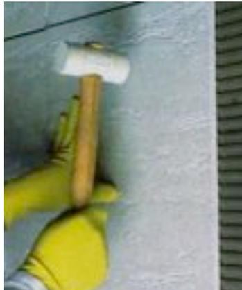
Fig 3.3 - Placa de pedra aplicada e pressionada para garantir o esmagamento dos cordões de cola [15]
