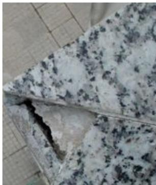
Fig 4.2 - Detalhe da fachada de um edifício onde é possível ver o fracturação dos cantos de placas de pedra
