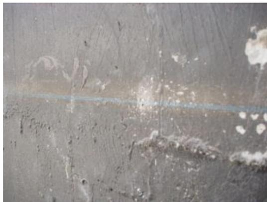
Fig 3.4 - Marca realizada na fachada para sinalizar a horizontal e a altura onde serão colocados os gatos metálicos
