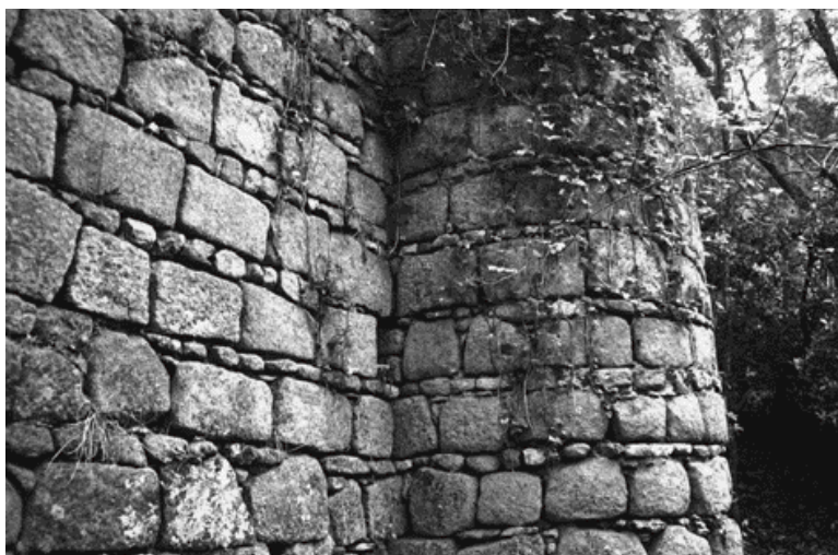
Figura 7 – Troço de muralha mais antigo - pormenor do aparelho construtivo (Coelho C. , 2000)
