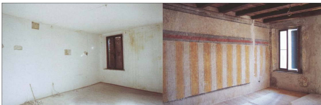
Figura 10 – Comparação entre o estado anterior e a fase próxima da conclusão (Doglioni, 2006).
