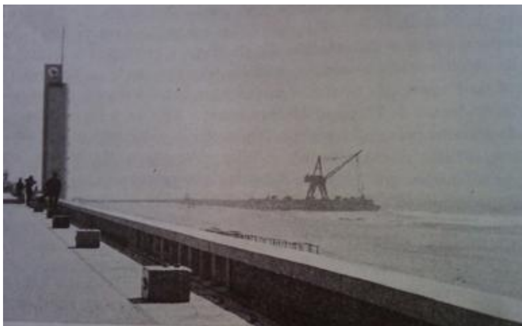
Figura 3.2 – Construção do molhe norte do porto da Figueira da Foz, 1961, (Carvalho, et al., 1966)
