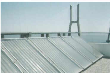
Figura 5 – Sistemas solares térmicos instalados na cobertura do edifício Torre Verde; Fonte: Tirone, (2008)
