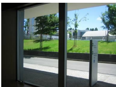
Figura 35 – Vãos envidraçados; caixilhos em alumínio; Fonte: Autor (2010)
