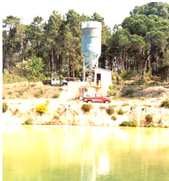
Figura 4 - Bacia de decantação e estação de tratamento químico da água da mina (fotografia de Setembro de 1996 (Neves, 2002)).
