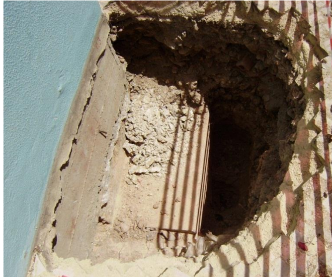
FIGURA 1. EXEMPLO DE SONDAGEM PARA AVERIGUAR A PROFUNDIDADE E ESTADO DAS FUNDAÇÕES EXISTENTES [5].
