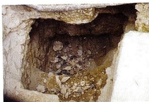
FIGURA 10. EXEMPLO DE POÇO DE INSPECÇÃO [3].
