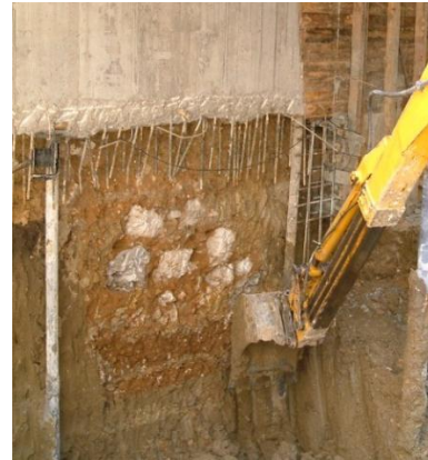
FIGURA 5. FUNDAÇÃO CORRIDA EM ALVENARIA [5].
