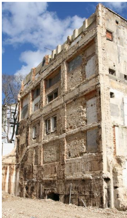
FIGURA 109. FOTOGRAFIA DE UMA DAS FACHADAS A CONSERVAR, QUE CONFRONTA COM O INTERIOR DO RECINTO DE OBRA [5].
