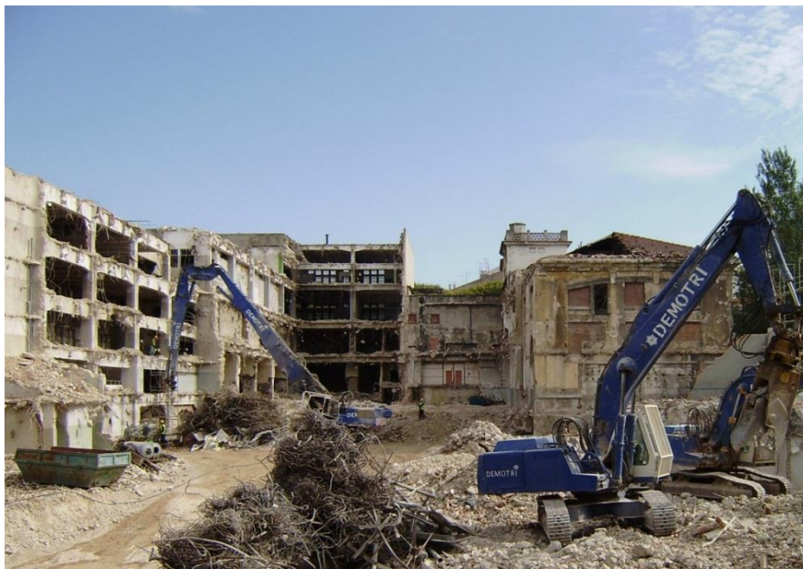
FIGURA 34. FOTO DO RECINTO DE OBRA COM AS DIFERENTES TOPOLOGIAS DE CONSTRUÇÃO.
