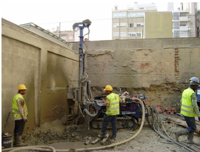
FIGURA 38. EXECUÇÃO DE MICROESTACA COM RECURSO A TRADOS [5].
