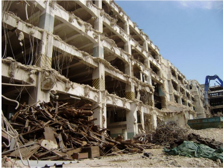
FIGURA 33. ENFRAQUECIMENTO DA ESTRUTURA ANTES DAS DEMOLIÇÕES DOS ELEMENTOS RESISTENTES.
