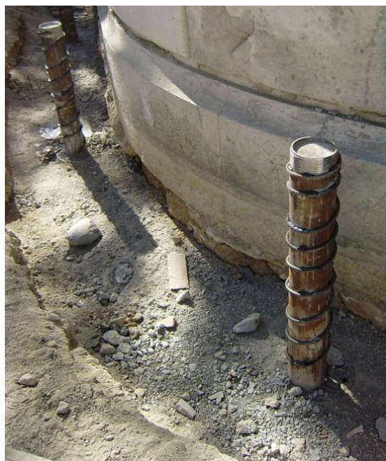
FIGURA 75. TOPO DAS MICROESTACAS COM VARÃO EM ESPIRAL SOLDADO [5].
