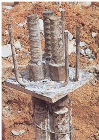
FIGURA 39. APLICAÇÃO EM OBRA DE MICROESTACA COM MÚLTIPLOS VARÕES GEWI [17].
