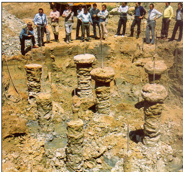
FIGURA 91. CORPOS TESTE DE JET GROUTING PARA VALIDAÇÃO E CALIBRAÇÃO DE PARÂMETROS [18].
