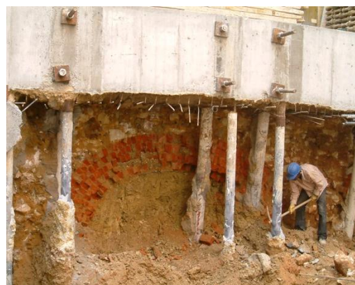
FIGURA 3. FUNDAÇÃO SEMI-DIRECTA POR POÇOS E ARCOS [5].
