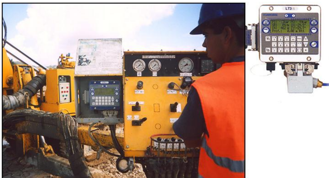
FIGURA 92. CONTROLO DE EXECUÇÃO DE CORPOS DE JET GROUTING [18].
