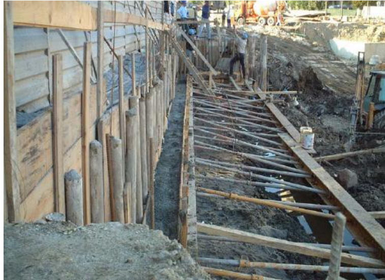
FIGURA 35. CORTINA DE CONTENÇÃO COM RECURSO A MICROESTACAS [14].
