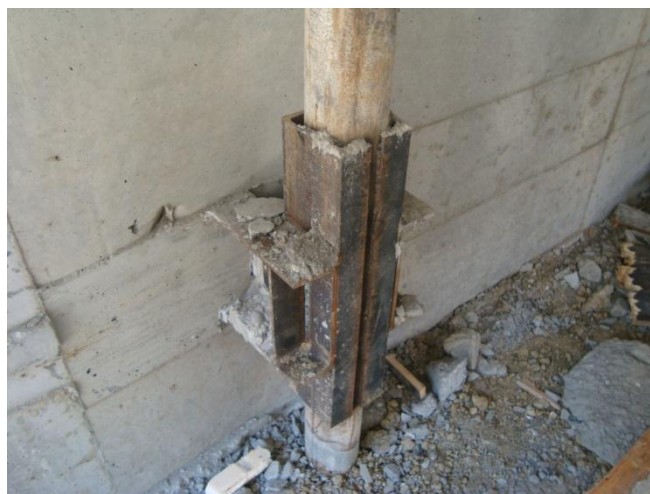
FIGURA 62. CACHORROS METÁLICOS DE TRAVAMENTO DAS MICROESTACAS [5].
