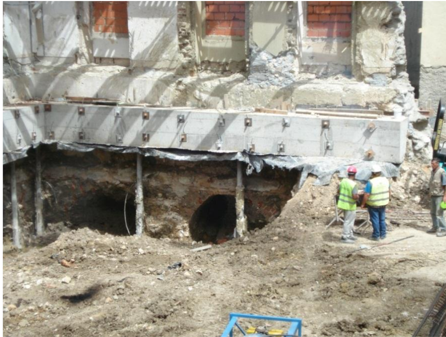
FIGURA 44. RECURSO A VARÕES PRÉ-ESFORÇADOS [5].
