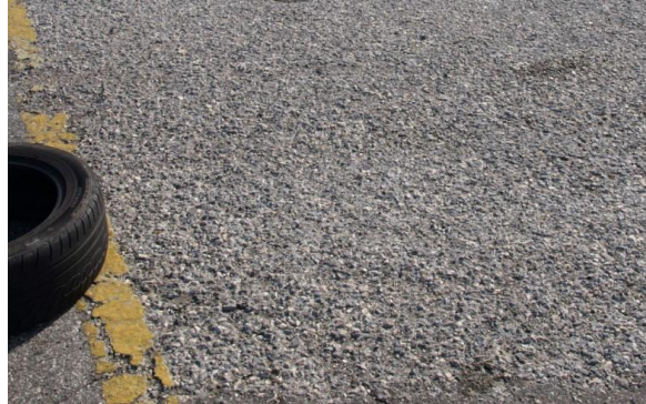
Figura 5.4 Polimento como uma anomalia entre outras mais gravosas
