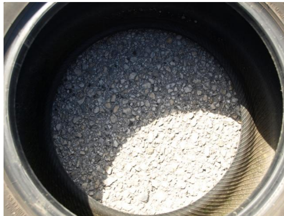
Figura 5.5 Polimento de agregados como anomalia evidente, ainda que seja acompanhada de desagregação da superfície numa fase inicial
