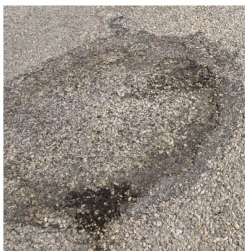
Figura 5.9 Depressão com profundidade inferior a 1,5cm, numa secção com outras anomalias importantes
