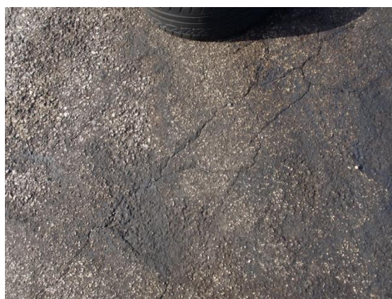
Figura 5.19 Fendas cruzadas numa secção com outras anomalias mais gravosas (rodeiras e derrame de óleos)
