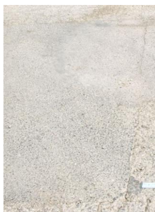
Figura 5.24 Junta do remendo aberta e ligeiro assentamento deste (nível 2)
