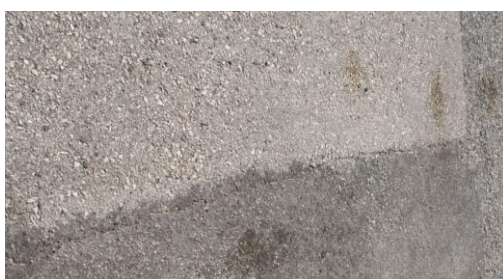
Figura 5.23 Junta do remendo aberta mas sem influência na classificação da secção (nível 1)
