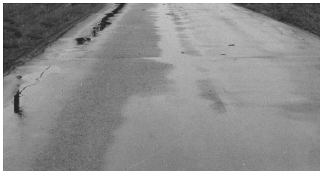
Figura 5.6 Rodeiras com filme de água após chuvas, extraída de (U. S. Department of Transportation, 2004)
