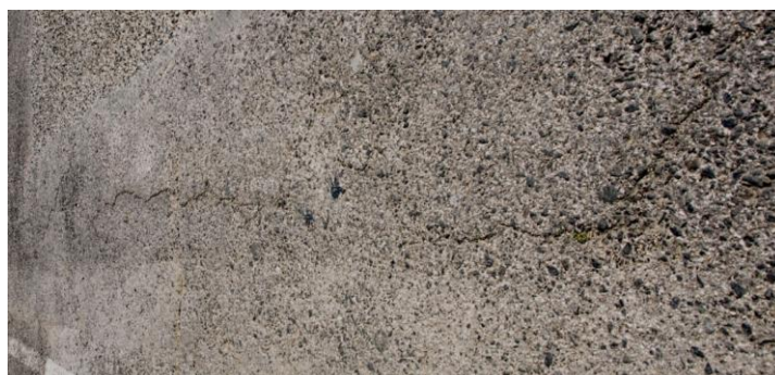
Figura 5.14 Fenda de reflexão do fim do pavimento inferior
