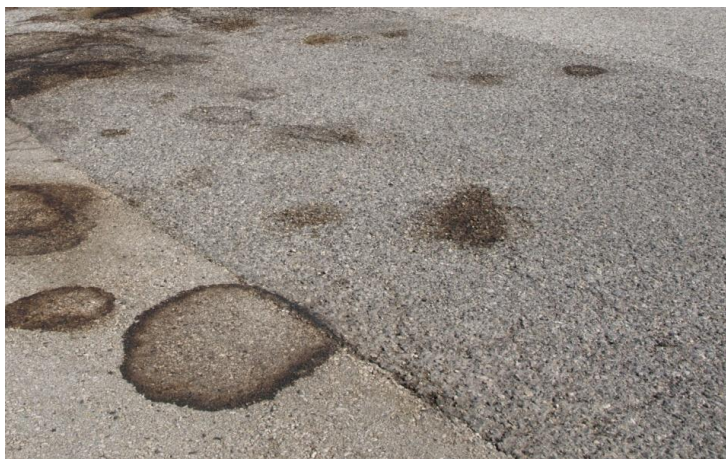
Figura 5.17 Junta de pavimento com fenda aberta apesar da existência de anomalias mais gravosas (nível 1)
