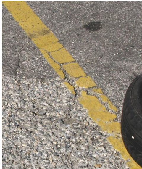
Figura 5.12 Fendas térmicas numa secção com outras anomalias mais gravosas
