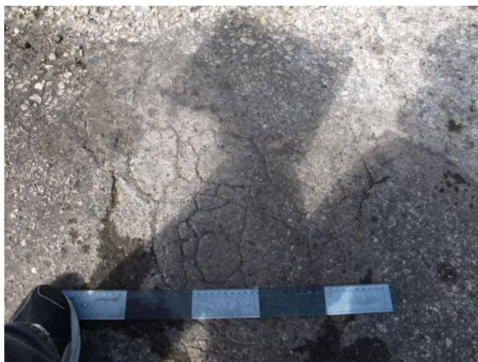
Figura 5.21 Pele de crocodilo existente mas numa área diminuta, com outras anomalias mais gravosas na secção
