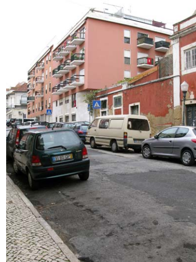
FIG. 3. 4 Engil Prédio n.º 2, 1961. [foto do autor]
