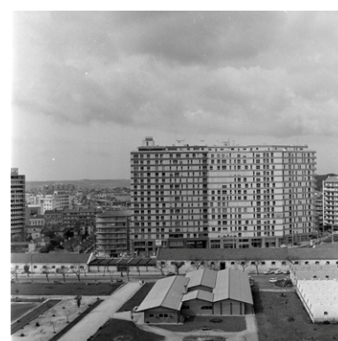
FIG. 2. 12 Edifício Valadas e Simões , 1967. [Arquivo do Atelier Conceição Silva]
