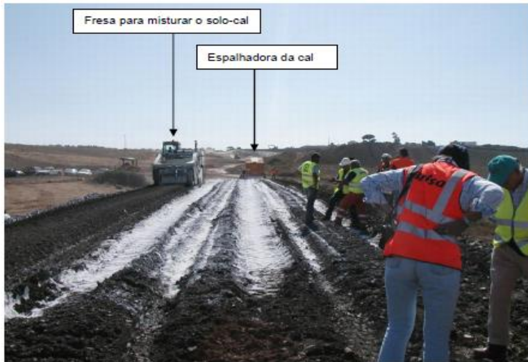
Figura 3.3 – Espalhamento e mistura da cal para formar a espalda de solo-cal
