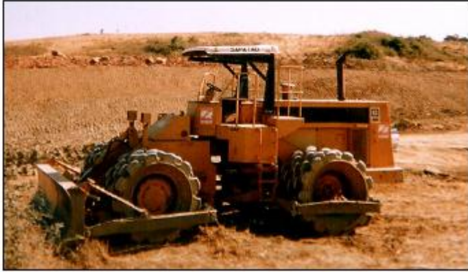
Figura 3.5 – Cilindro vibrador pés de carneiro utilizado na construção do aterro
