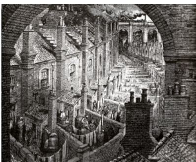
Fig. 1.2.5: Bairro pobre de Londres sob viaduto ferroviário
