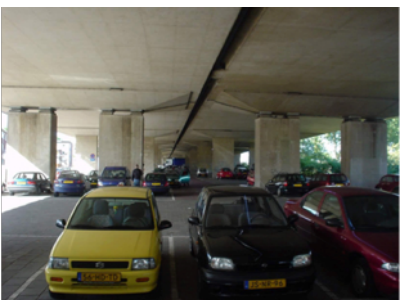
Fig. 2.2.2: O local antes da intervenção
