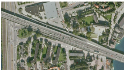
Fig. 2.2.1: Troço da A8 sob o qual foi feita a intervenção
