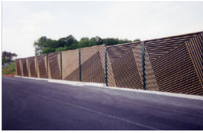
Fig. 3.2.3: Exemplo de barreira acústica de madeira
