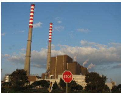
Fig. 1.3.6: Central termoelétrica de Sines
