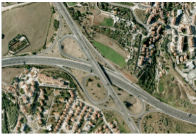
Fig. 1.4.1: Nó da A5 com a CREL, em Queijas
