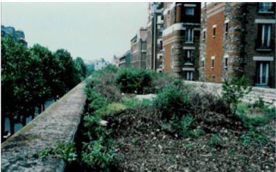
Fig. 2.3.1: A linha férrea antes da intervenção
