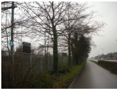
Fig. 3.2.4: Barreira de protecção em Zaanstad, na Holanda
