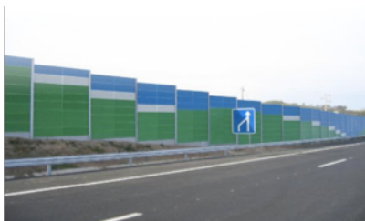
Fig. 3.2.1: Barreira acústica em autoestrada
