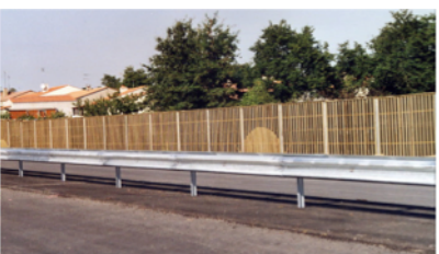
Fig. 3.2.2: Exemplo de barreira acústica de madeira
