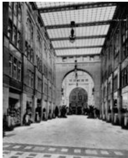
FIGURA 65, Fotografia da galeria comercial em funcionamento 146
