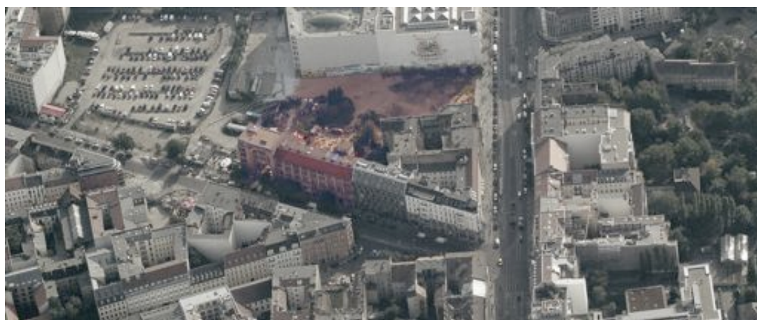
FIGURA 64, Fotografia em perspectiva área do local 145
