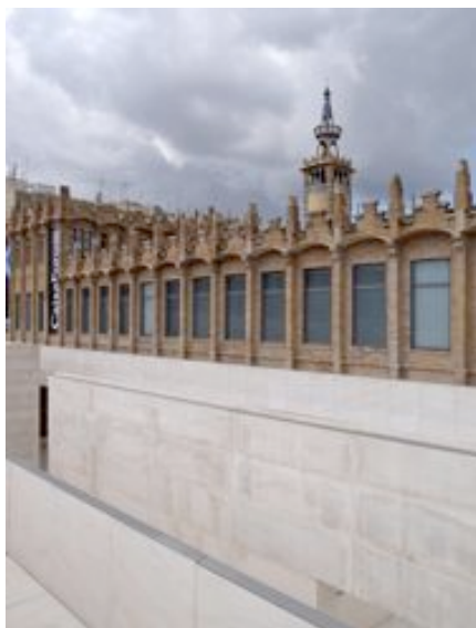
FIGURA 100, Fotografia do exterior da fundação 174
