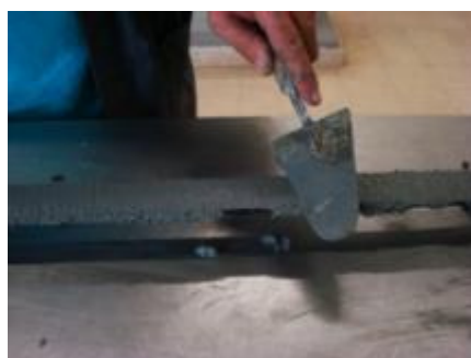
Figura 5- Preparação das calhas metálicas.
