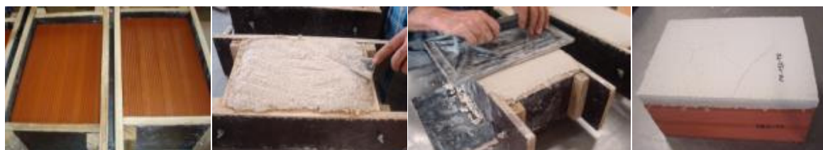
a) Moldagem dos tijolos. b) Aplicação da argamassa no tijolo. c) Acabamento final com talocha. d) Tijolo desmoldado.
