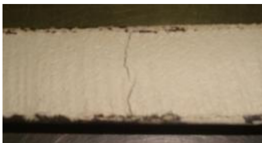
Figura 34- Fissura presente no revestimento da argamassa PZ2.
