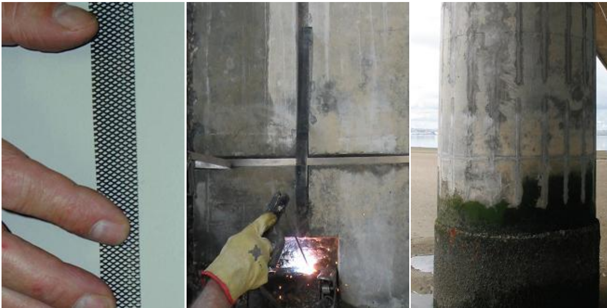
Figuras 10, 11 e 12 - Fita de Ti/MMO, a sua aplicação e aspecto final (Lourenço, 2007)
