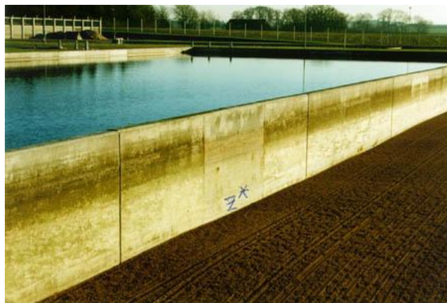
Figura 4 - Efeito dos sistemas CPF na redução do crescimento de microrganismos ( www2.dupont.com/Zemdrain/en_US/products/benefits_zemdrain/benefits/microbio_growth.html )
