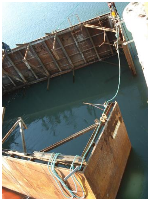
Figura 14 - Aplicação de ensecadeira num pilar da ponte Eiffel, Viana do Castelo (Appleton e Costa, 2009)
