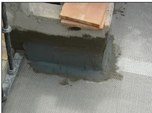
**Figura 2.6 – Tratamento de zona de remate com superfície vertical em sistema cimentício.**
