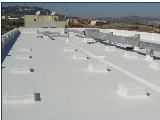
**Figura 2.13 – Cobertura com elevada quantidade de singularidades, executada com produto acrílico.**
