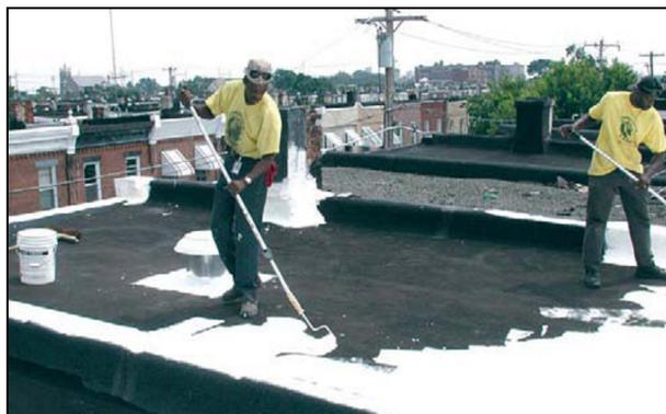
**Figura 2.3 – Aumento da reflectância solar de cobertura betuminosa com aplicação de revestimento elastomérico acrílico branco [17].**
