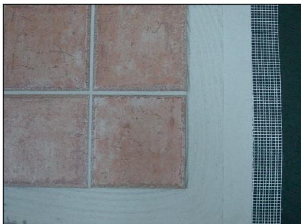
**Figura 2.5 – Estratificação de sistema de impermeabilização armado com revestimento de ladrilhos cerâmicos.**
