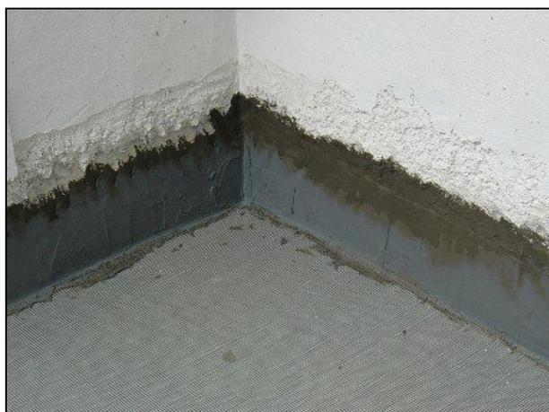
**Figura 2.12 – Remate de sistema cimentício com parede emergente.**
