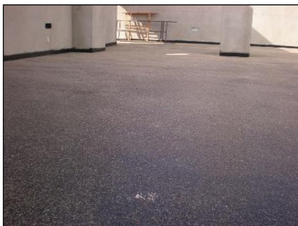
Figura 2.14 – Espalhamento de areia sobre borracha líquida.
