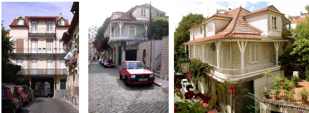
Figs. 59, 60 e 61 – Edifício do arco (à esquerda) e chalet (vistas à direita)
