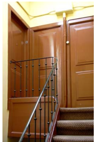
patamar de entrada para os fogos 2º piso
