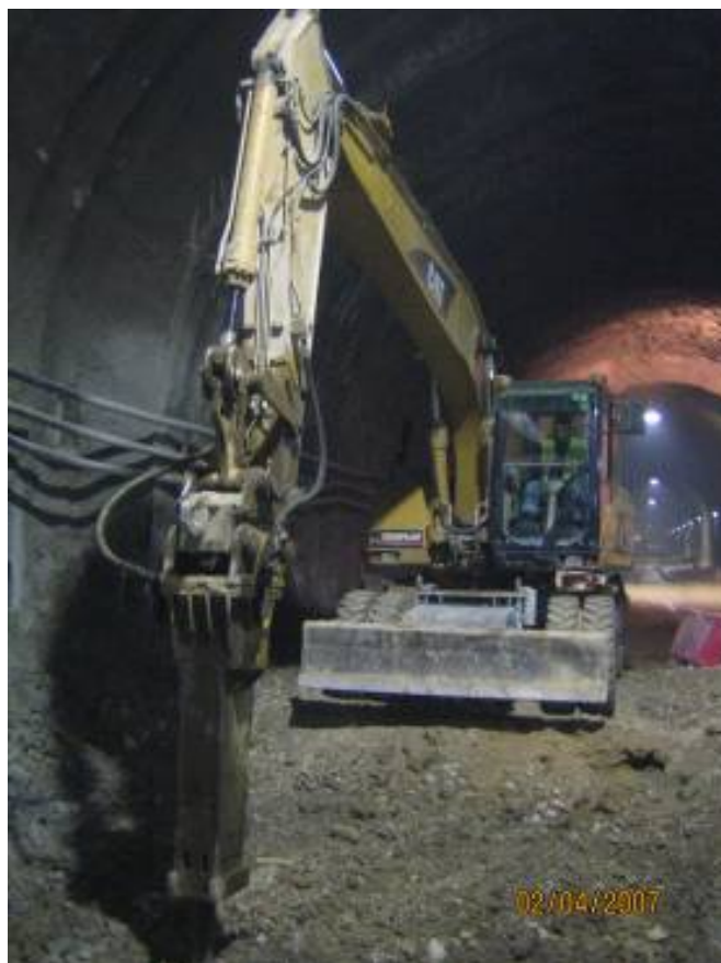
Figura 4.24 – Martelo Pneumático acoplado à Giratória
