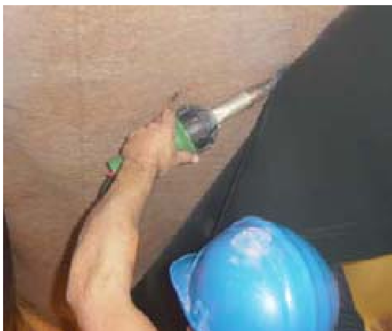
Figura 4.52 – Soldadura da geomembrana às arandelas
