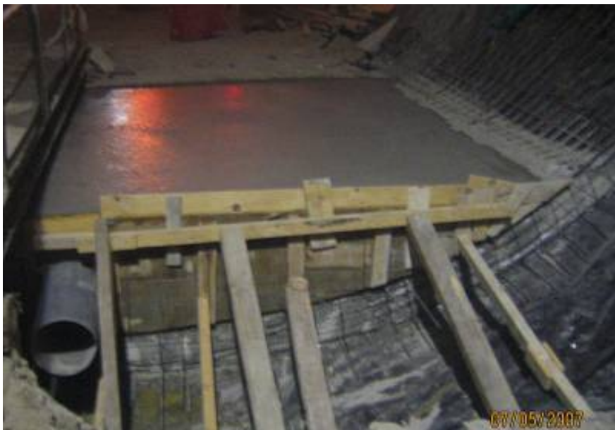
Figura 4.50 – Finalização da betonagem com betão de enchimento C12/15
