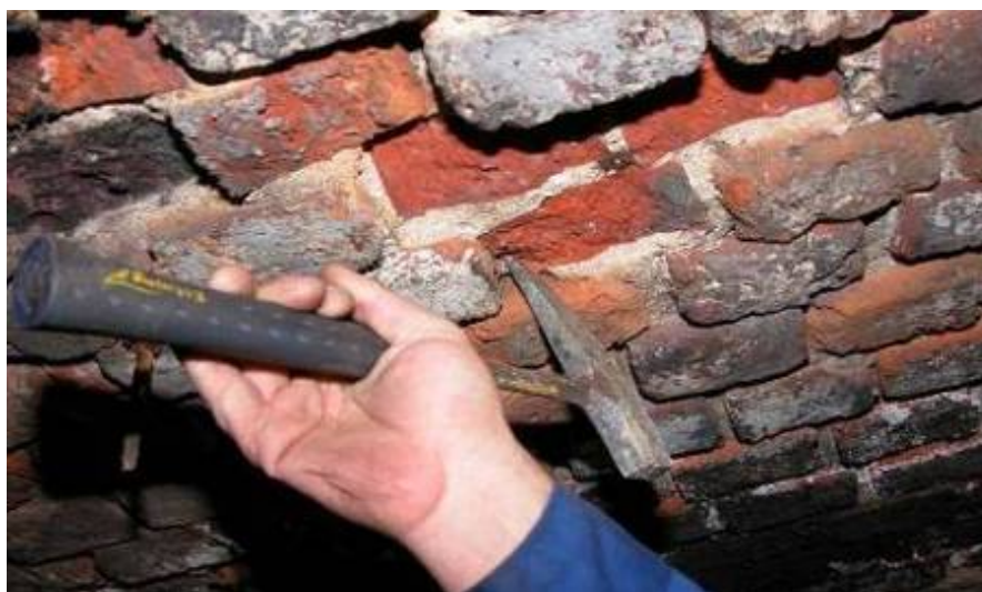
Figura 3.8 – Deslocamento de blocos de alvenaria com martelo de geólogo
