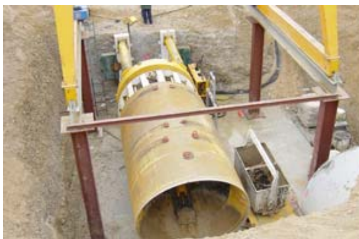
Figura 2.3 – Tuneladora com escudo aberto [3]
