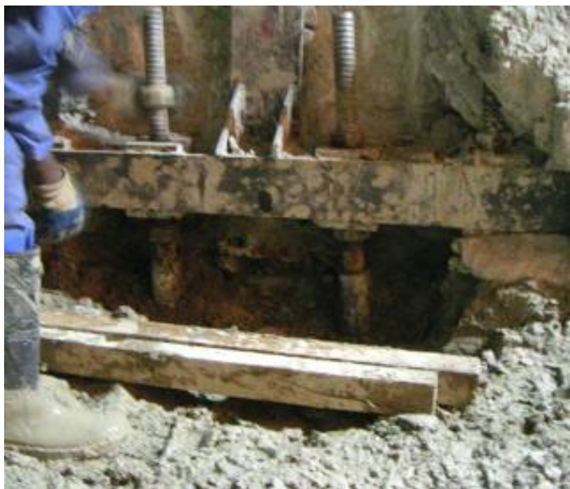
Figura 4.31 – Viga de reacção com as microestacas
