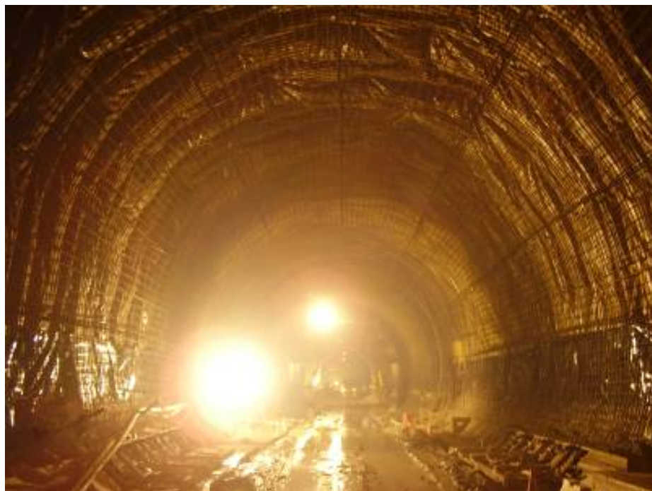
Figura 4.57 – Finalização da montagem de armaduras nos hasteais e abóbada
