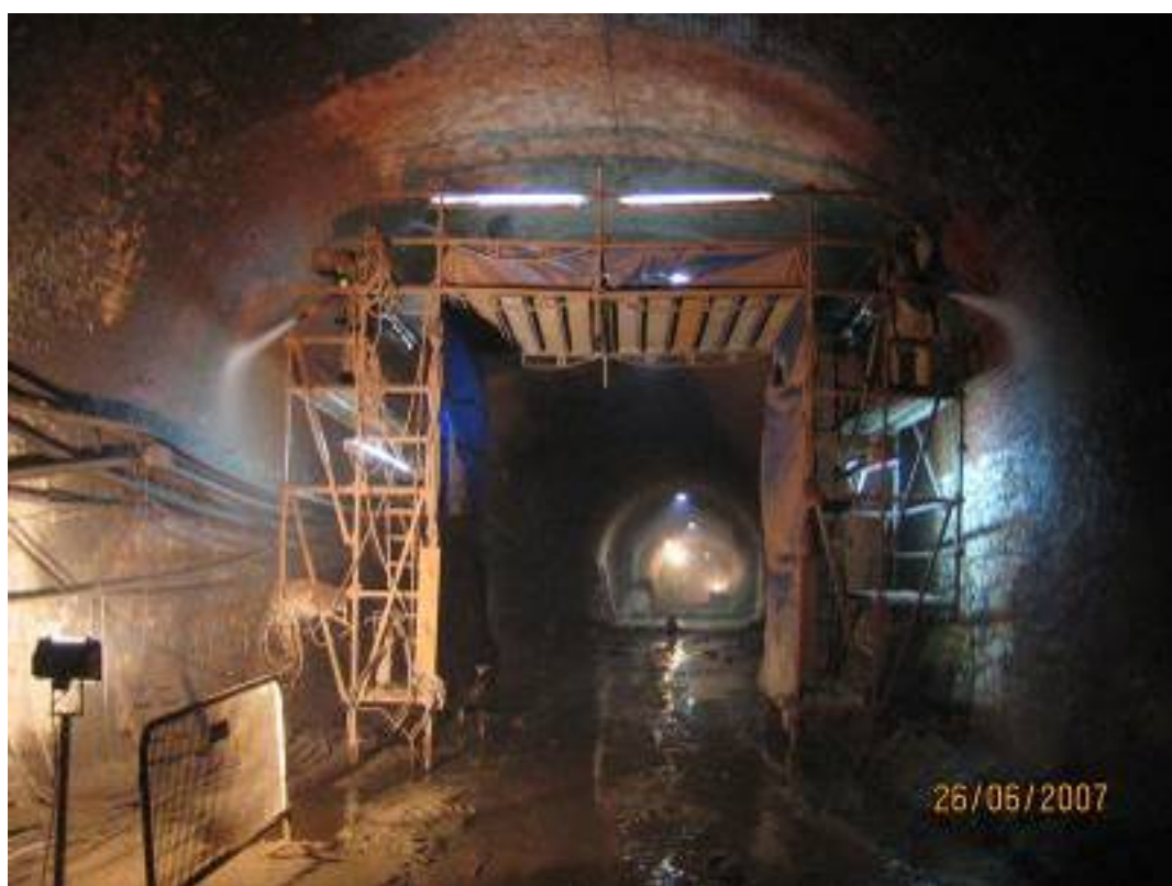
Figura 4.66 – Limpeza de alvenaria a jacto por via húmida
