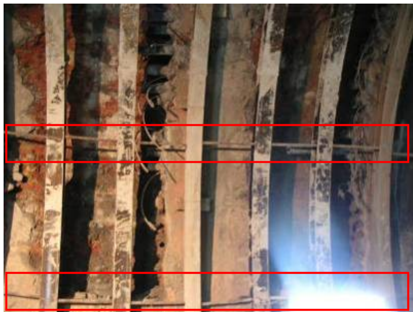
Figura 4.3 – Contraventamento das Cambotas
