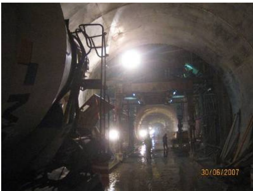
Figura 4.62 – Betonagem do molde
