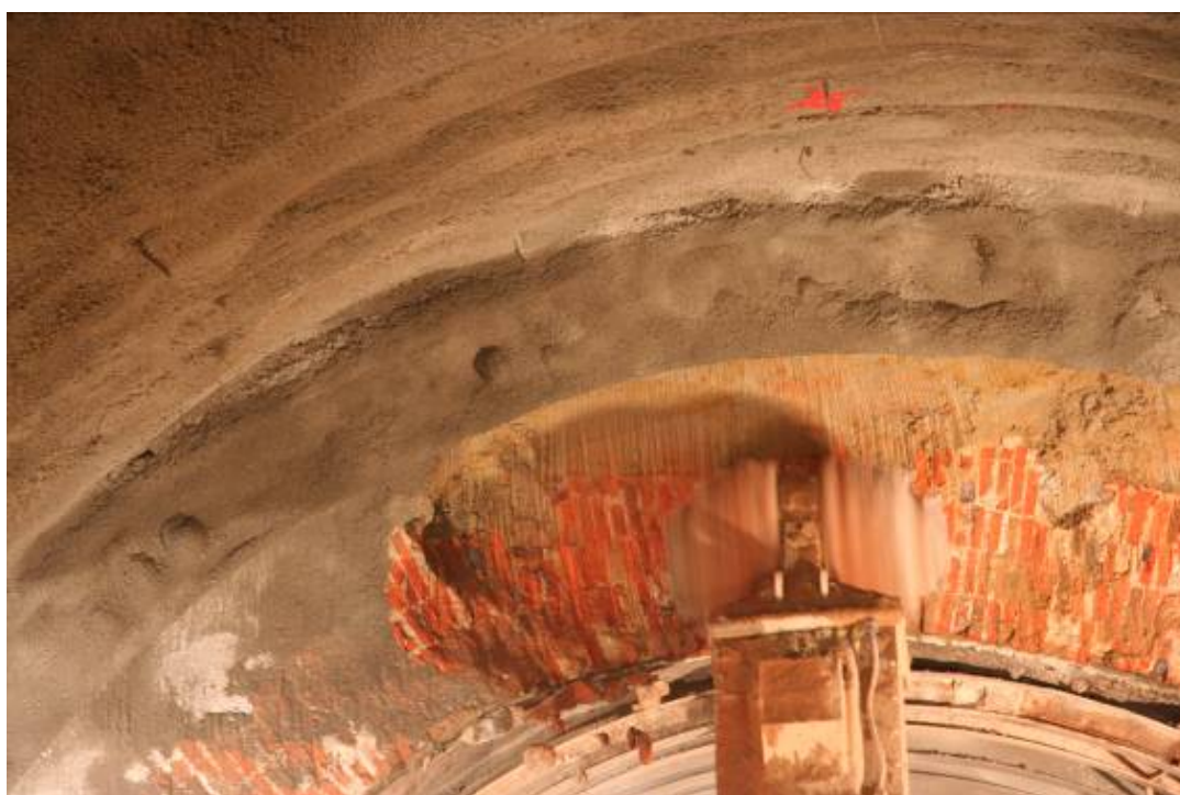
Figura 4.23 – Escavação da alvenaria de tijolo
