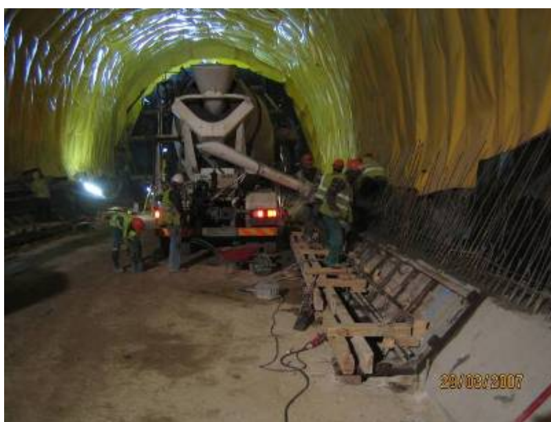
Figura 4.59 – Betonagem dos arranques dos hasteais
