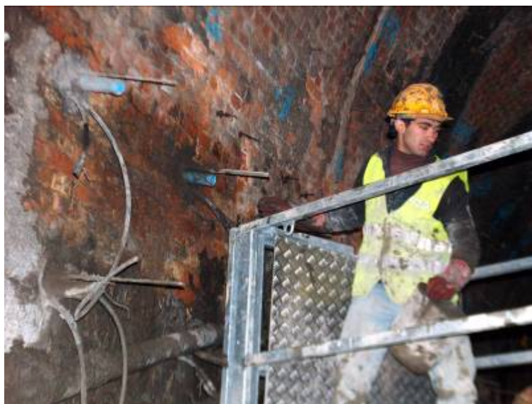
Figura 4.13 – Injecção da pregagem
