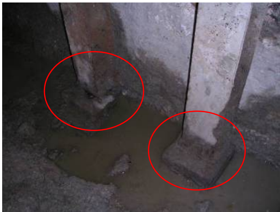
Figura 4.6 – Calços de betão sob os pés das cambotas para posicionamento destas [19]
