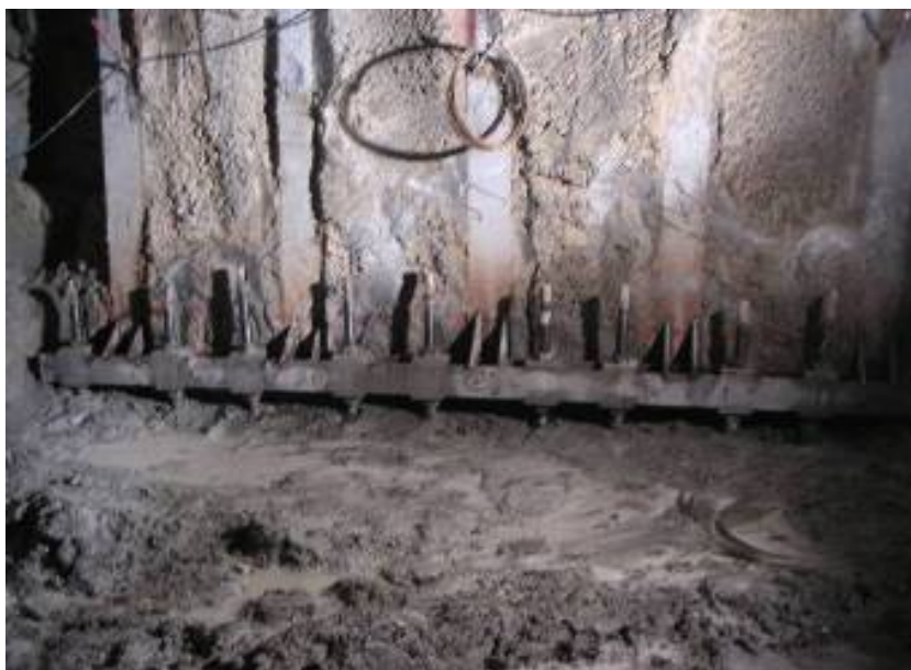
Figura 4.32 – Sequência de vigas de reacção soldadas, com as microestacas
