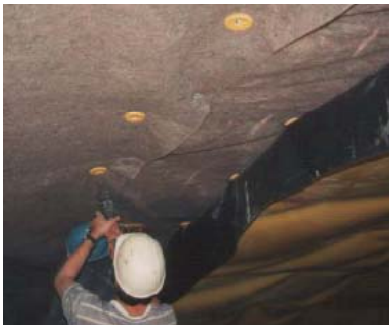
Figura 4.51 – Fixação do geotêxtil com pregos de disparo
