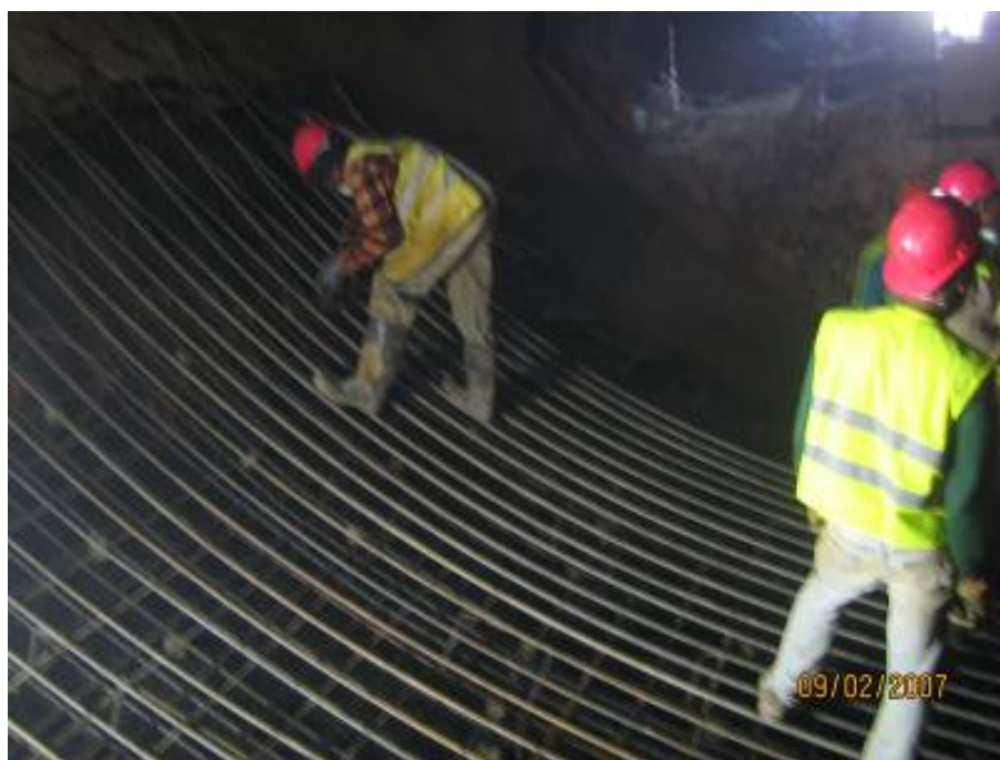
Figura 4.43 – Montagem de armadura
