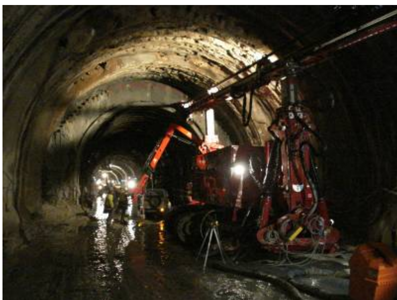
Figura 4.18 – Furação de enfilagens com Posicionador
