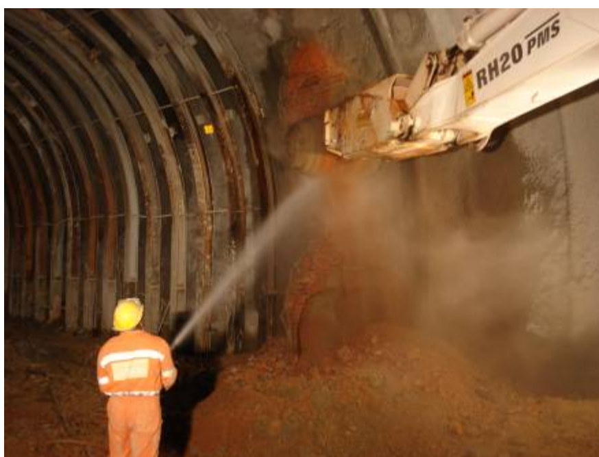
Figura 4.25 – Jacto de água para evitar a excessiva propagação de poeiras
