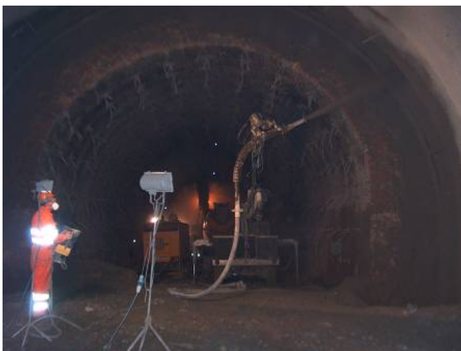
Figura 4.28 – Betão projectado com fibras metálicas
