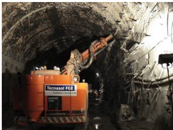
Figura 4.9 – Furação com a TAMROCK
