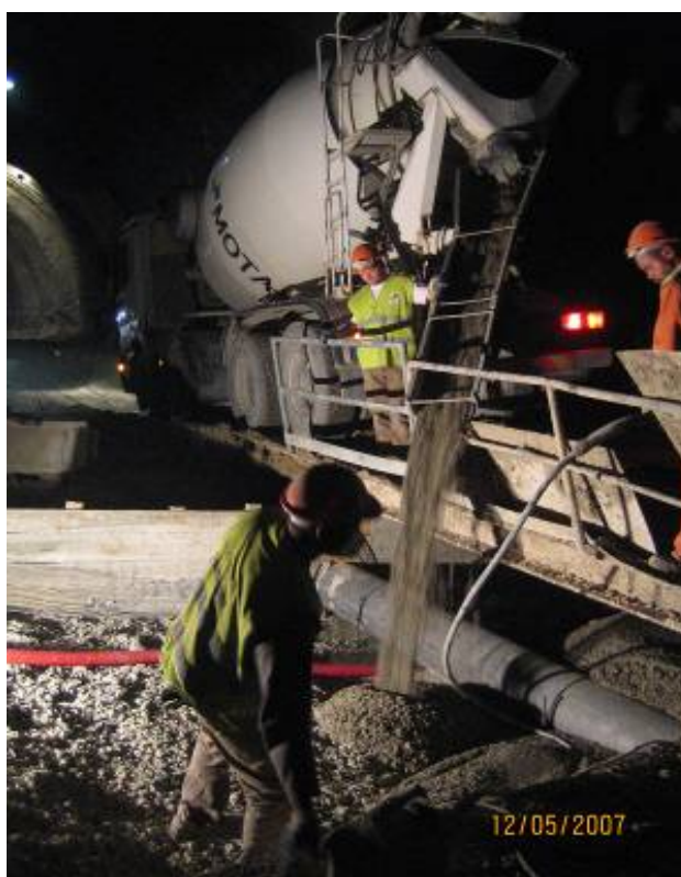
Figura 4.49 – Aplicação de betão de enchimento C12/15
