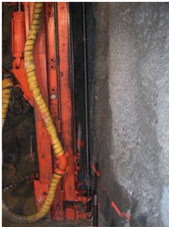
Figura 4.30 – Colocação da armadura
