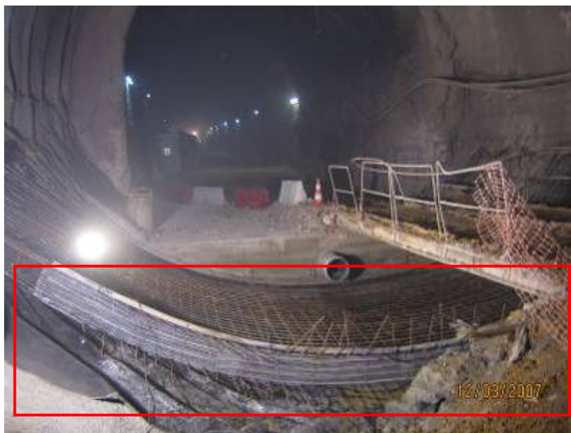
Figura 4.42 – Cofragem em aço-nervurado perpendicular ao eixo do túnel
