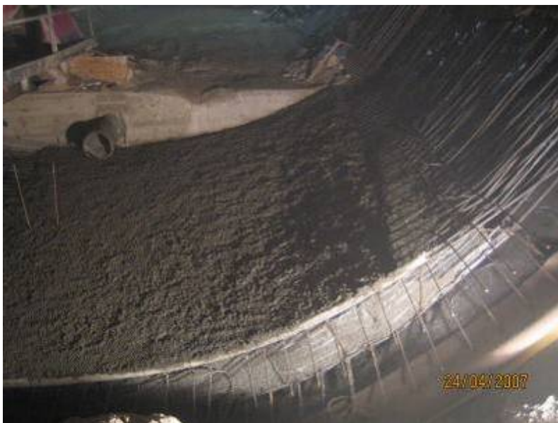
Figura 4.46 – Aplicação de betão estrutural (conclusão da betonagem)
