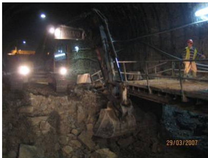
Figura 4.35 – Escavação do troço de soleira
