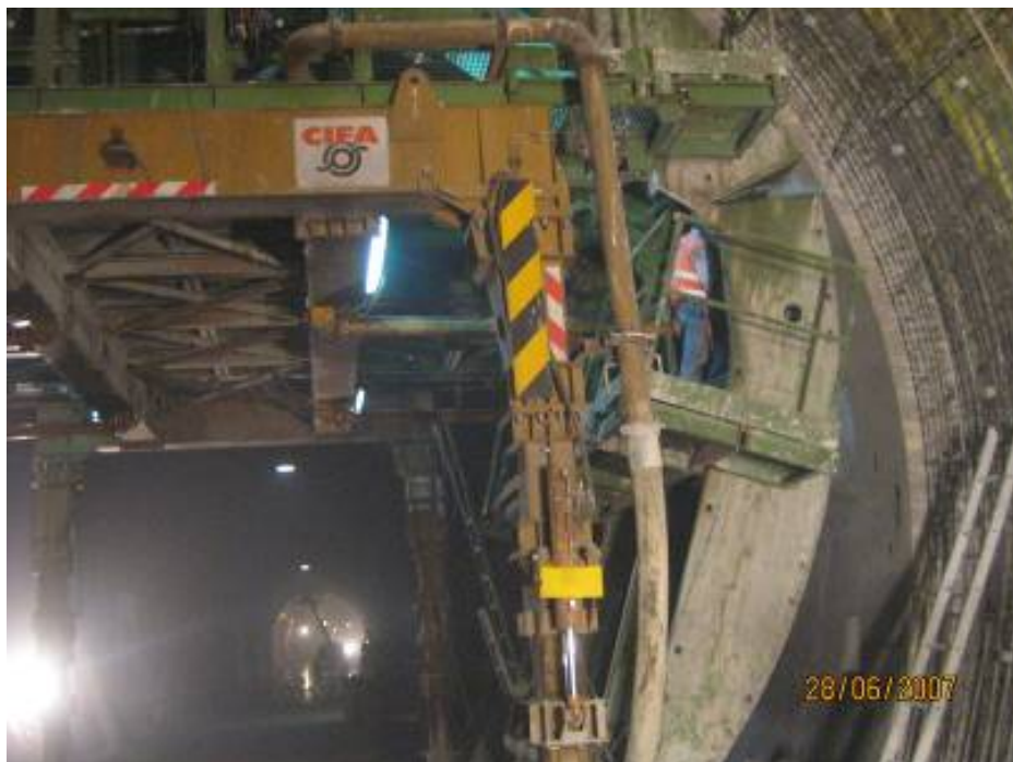
Figura 4.64 – Descofragem do molde (abertura das abas)
