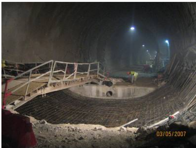
Figura 4.44 – Vista geral da malha de armadura executada
