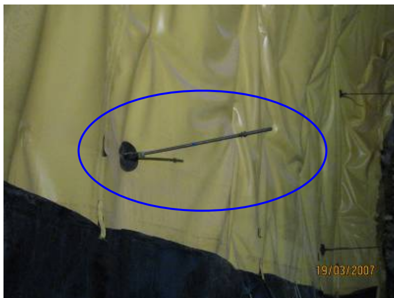
Figura 4.54 – Trompette no sistema de impermeabilização
