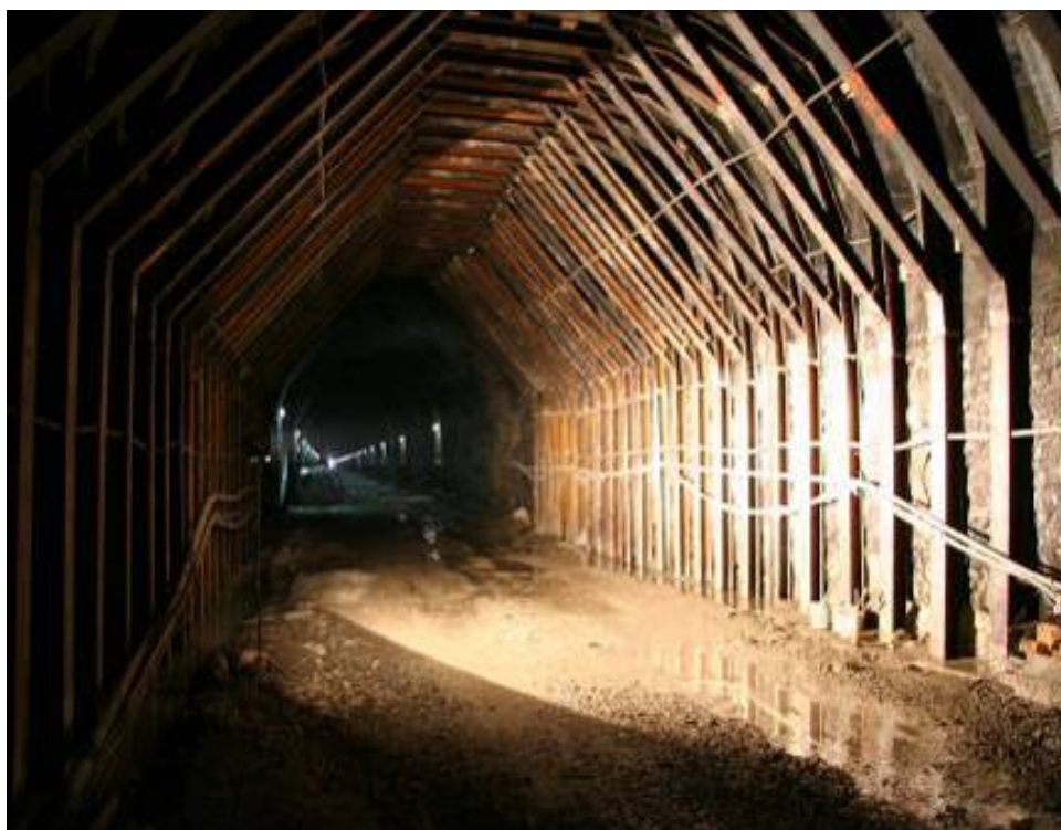
Figura 3.10 – Secção com Escoramento Provisório (cambotas) entre os Pk [0+194 ; 0+221]
