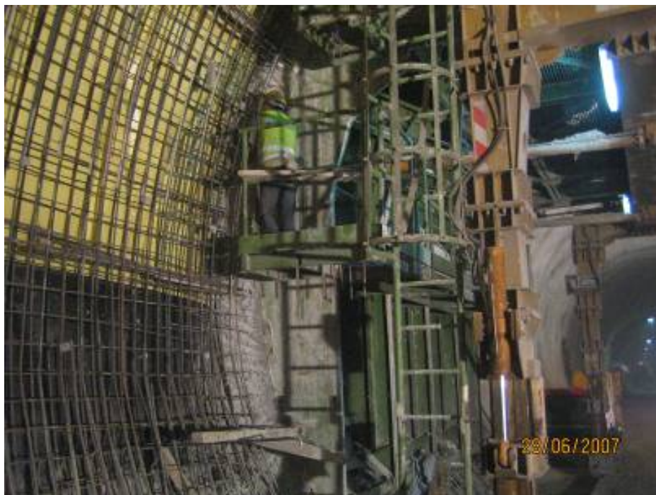
Figura 4.63 – Descofragem do molde (picagem dos topos)
