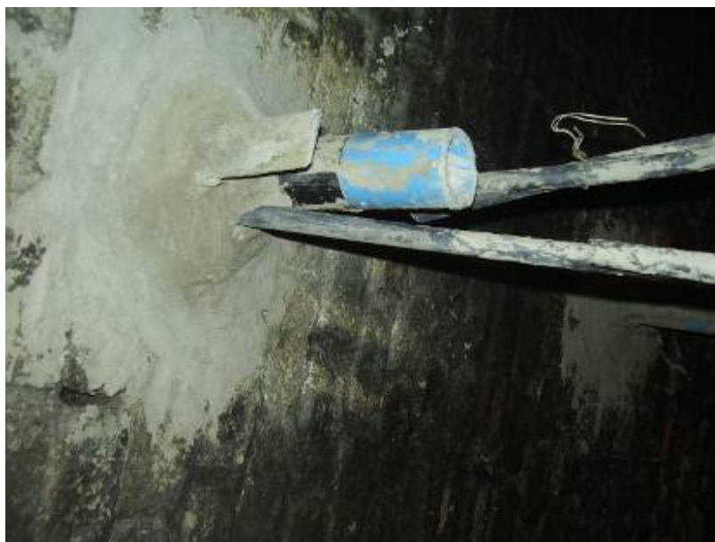
Figura 4.15 – Pregagem de fibra de vidro depois da injeção
