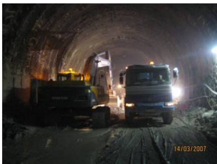
Figura 4.36 – Retirada das terras provenientes da escavação do troço de soleira
