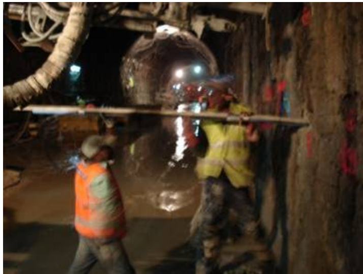
Figura 4.12 – Colocação da armadura no furo
