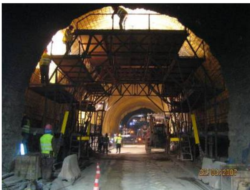
Figura 4.56 – Montagem de armaduras nos hasteais e abóbada realizada em andaimes
