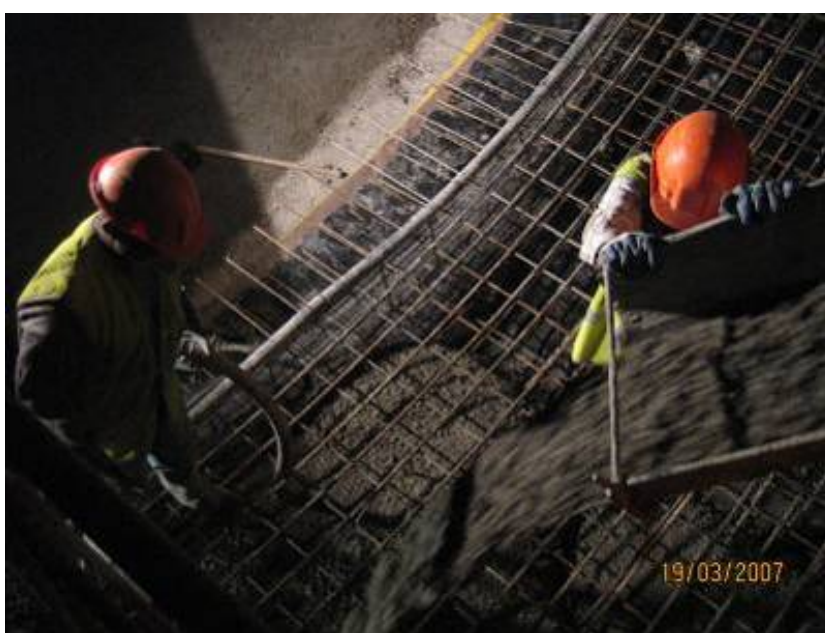
Figura 4.45 – Aplicação de betão estrutural (descarga directa)
