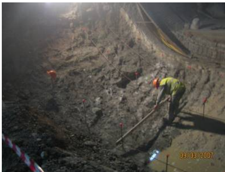
Figura 4.37 – Limpeza após a escavação e aplicação de bitolas
