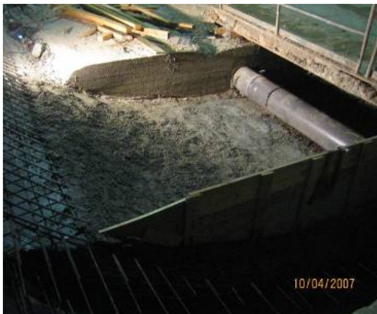
Figura 4.48 – Montagem da cofragem e do tubo colector (vista final)
