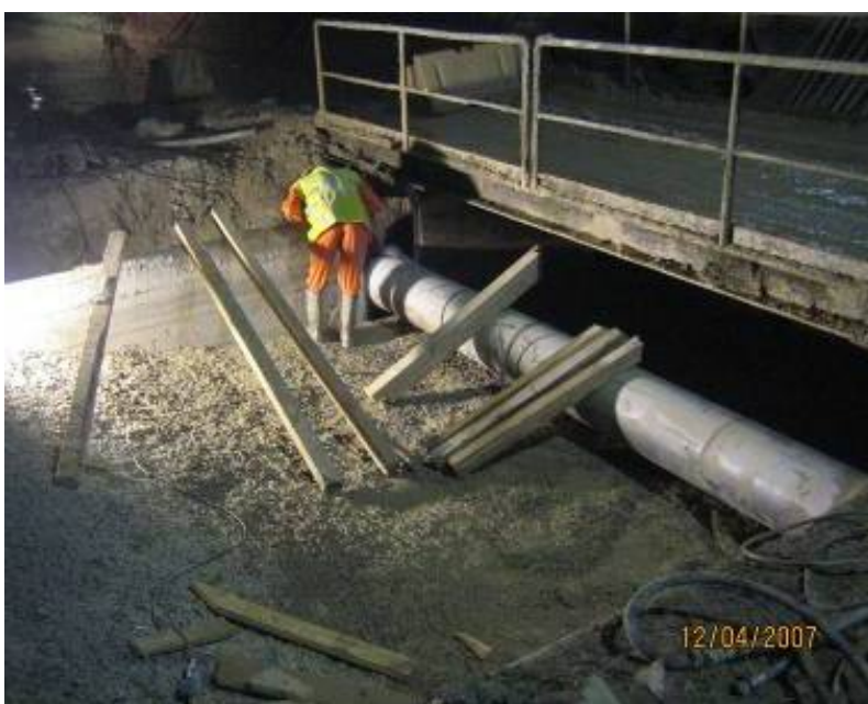
Figura 4.47 – Montagem da cofragem e do tubo colector
