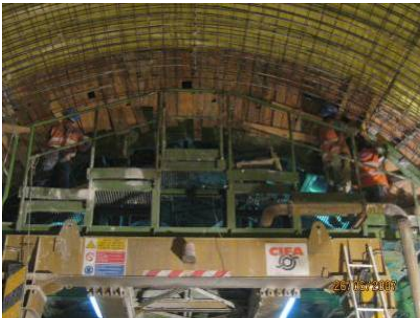
Figura 4.61 – Montagem de cofragem nos topos do molde
