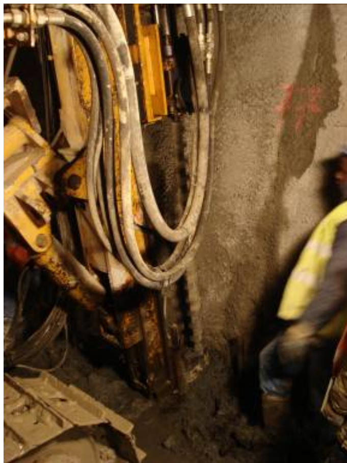
Figura 4.29 – Furação das microestacas a trado contínuo
