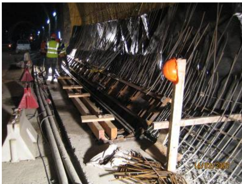
Figura 4.58 – Cofragem dos arranques
