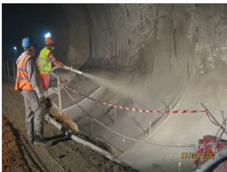
Figura 4.38 – Gunitagem da soleira
