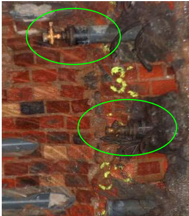
Figura 4.21 – Válvula de injeção da enfilagem
