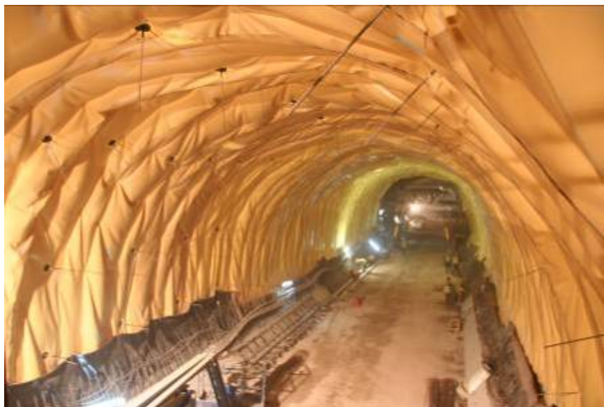
Figura 4.55 – Vista do sistema de impermeabilização executado
