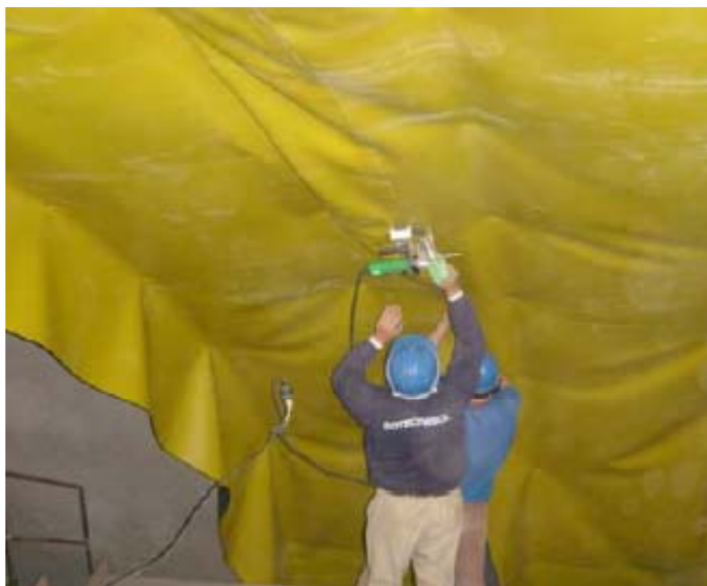
Figura 4.53 – Soldadura de sobreposição da geomembrana
